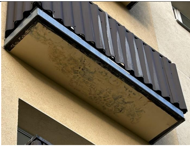
1.5.8.35. attēls. Ēka Nr. 12. Atjaunošana laiks – ~10 gadi. Metāla lāsenis visā balkona plātnes biezumā. Margas apdare nav zemāka par lāseņa un balkona plātnes apakšu. Lokāli mitruma un aļģu veidošanās pleķi, ārējā perimetrā izsāļojumi, krāsojuma atslāņošanās pa plātnes perimetru.
