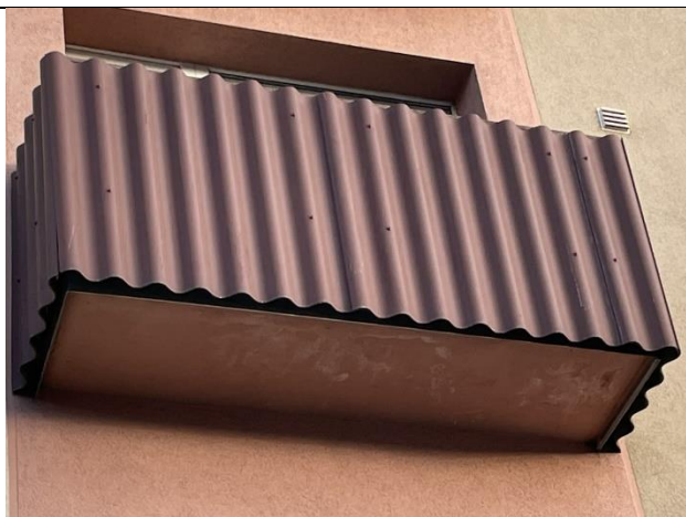
1.5.8.28. attēls. Ēka Nr. 7. Atjaunošana laiks – ~10 gadi. Metāla lāsenis visā balkona plātnes biezumā. Margas apdare zemāka par lāseņa un balkona plātnes apakšu. Tikai lokāli izsāļojumi uz plātnes apakšējās virsmas.
