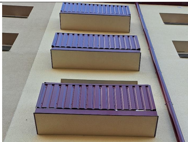
1.5.8.29. attēls. Ēka Nr. 8. Atjaunošana laiks – ~1 gads. Metāla lāsenis visā balkona plātnes biezumā. Margas apdare nav zemāka par lāseņa un balkona plātnes apakšu. Bojājumu nav.
