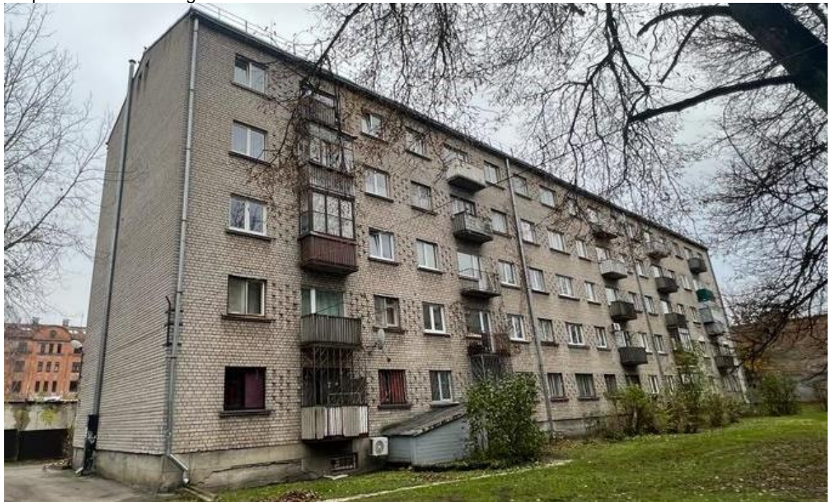
1.5.1.1. attēls. 1-316 sērijas ēku fasāde.
