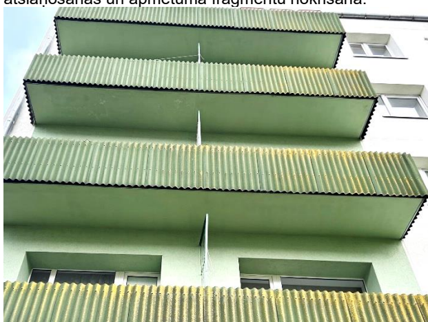
1.5.8.32. attēls. Ēka Nr. 10. Atjaunošana laiks – ~10 gadi. Metāla lāsenis visā balkona plātnes biezumā. Margas apdare zemāka par lāseņa un balkona plātnes apakšu. Bojājumu praktiski nav, tikai lokāli minimāli izsāļojumi balkona plātnes apakšā.
