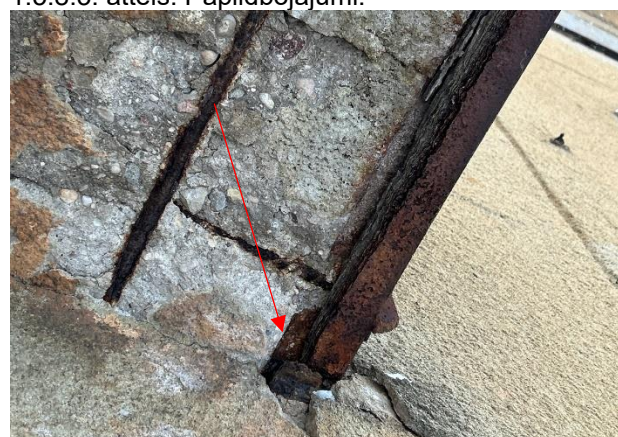
1.5.8.6. attēls. Mehānisko stiprību un stabilitāti ietekmējoši bojājumi. Perimetra profils atslāņojies pilnā apmērā - tas atdalījies.
