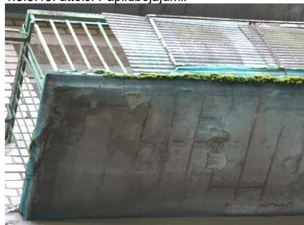
1.5.8.17. attēls. Mehānisko stiprību un stabilitāti ietekmējoši bojājumi.
