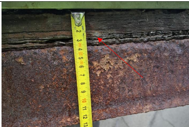
1.5.8.7. attēls. Mehānisko stiprību un stabilitāti ietekmējoši bojājumi. Perimetra profila augšējais plaukts atslāņojies – pieaudzis tilpumā līdz 3.5 cm. Spriegumu rezultātā deformēta sienīņa.
