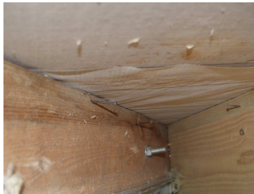
Nav izveidotas ventilācijas spraugas
