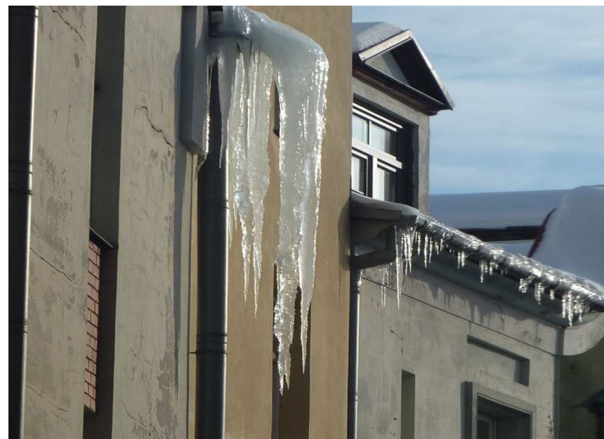
Izkausētais sniegs sasalst uz jumta malām
