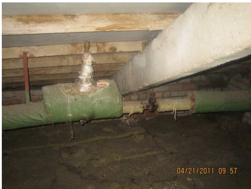
Nenosiltināti krāni un slikti nosiltinātas apkures caurules
