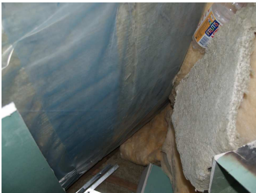
Pavirši ieklāta tvaika izolācija
