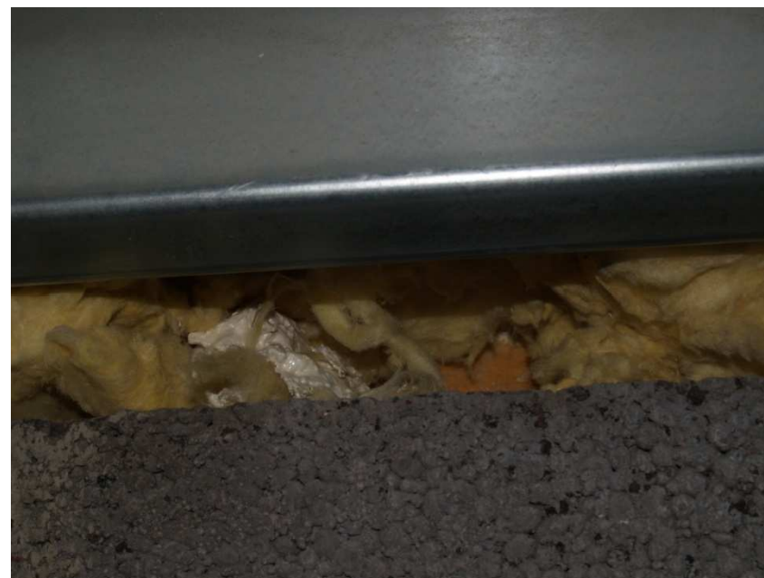
Pavirši nosiltinātas spraugas
