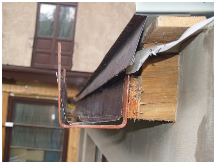
Pavirši izpildītas jumta nobeiguma detaļas
