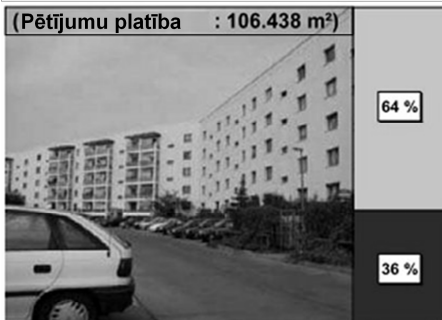
5-stāvu ēka divcauruļu apkure
