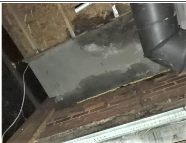
4.5.7. att. Nehermētiska lūka kurināmā noliktavas pārsegumā.
