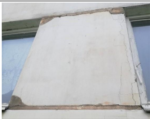
4.5.2. att. Nehermētiskas starppaneļu šuves.
