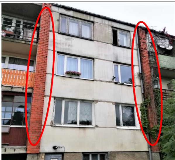
4.2.1.att. Ēkas nesošās ķieģeļu mūra šķērssienu 510 mm biezumā.
