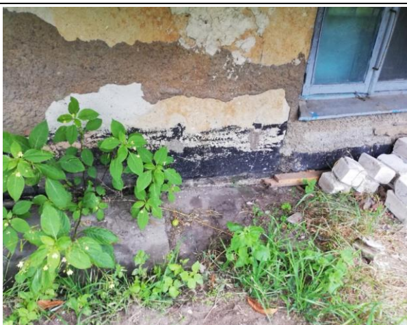
4.5.5.att. Ēkas pamatu vertikālā hidroizolācija.
