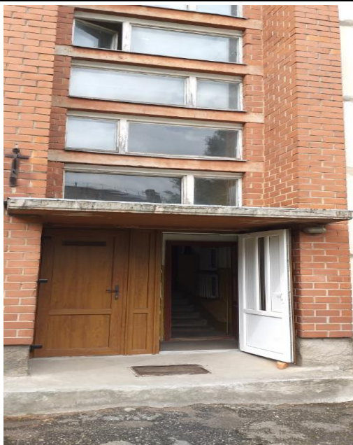
4.13.5.att. 1. kāpņu telpā iebūvētas PVC durvis, koka logi – nolietojušies
