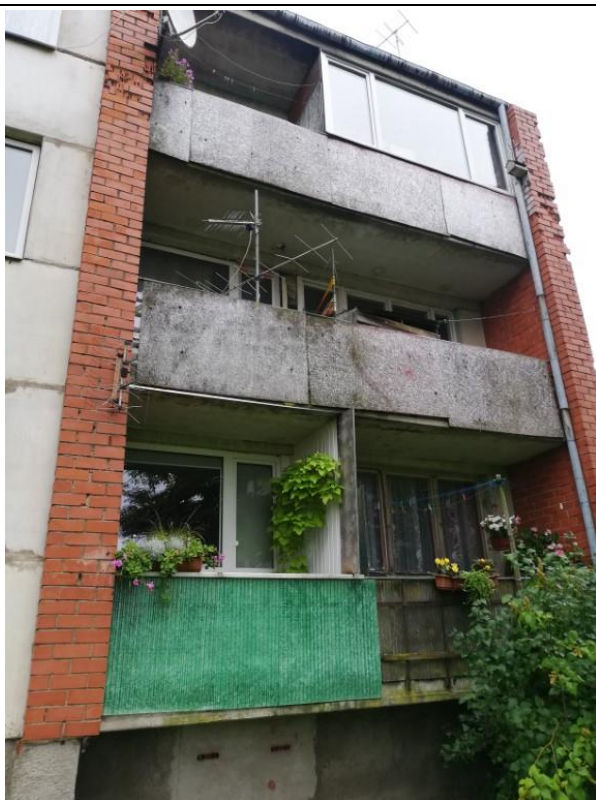
4.9.5., 4.9.6.att. Korodētas margas un ieliekamās detaļas, dažādu materiālu norobežojošās konstrukcijas.
