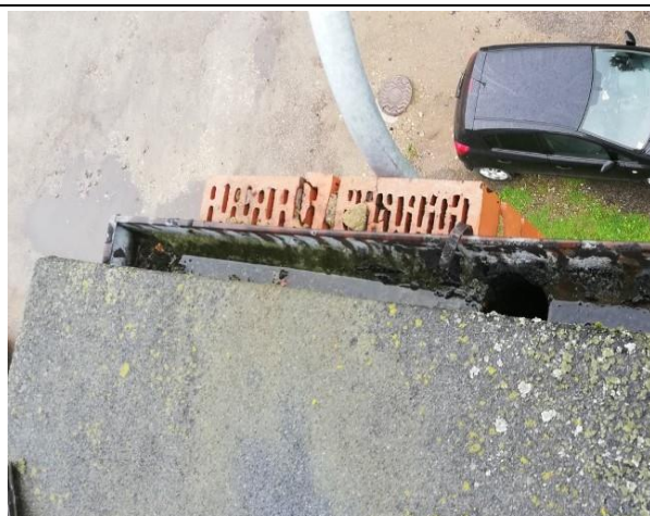
4.5.6. att. Nehermētisks gala sienas mūris. Nepieciešams nosegt ar cementa javu un skārdi.
