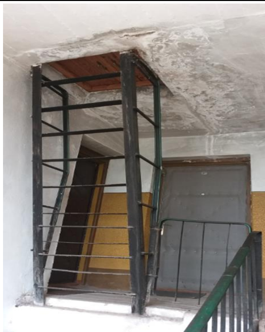
4.10.7.att. Metāla kāpnes nokļūšanai uz jumta.
