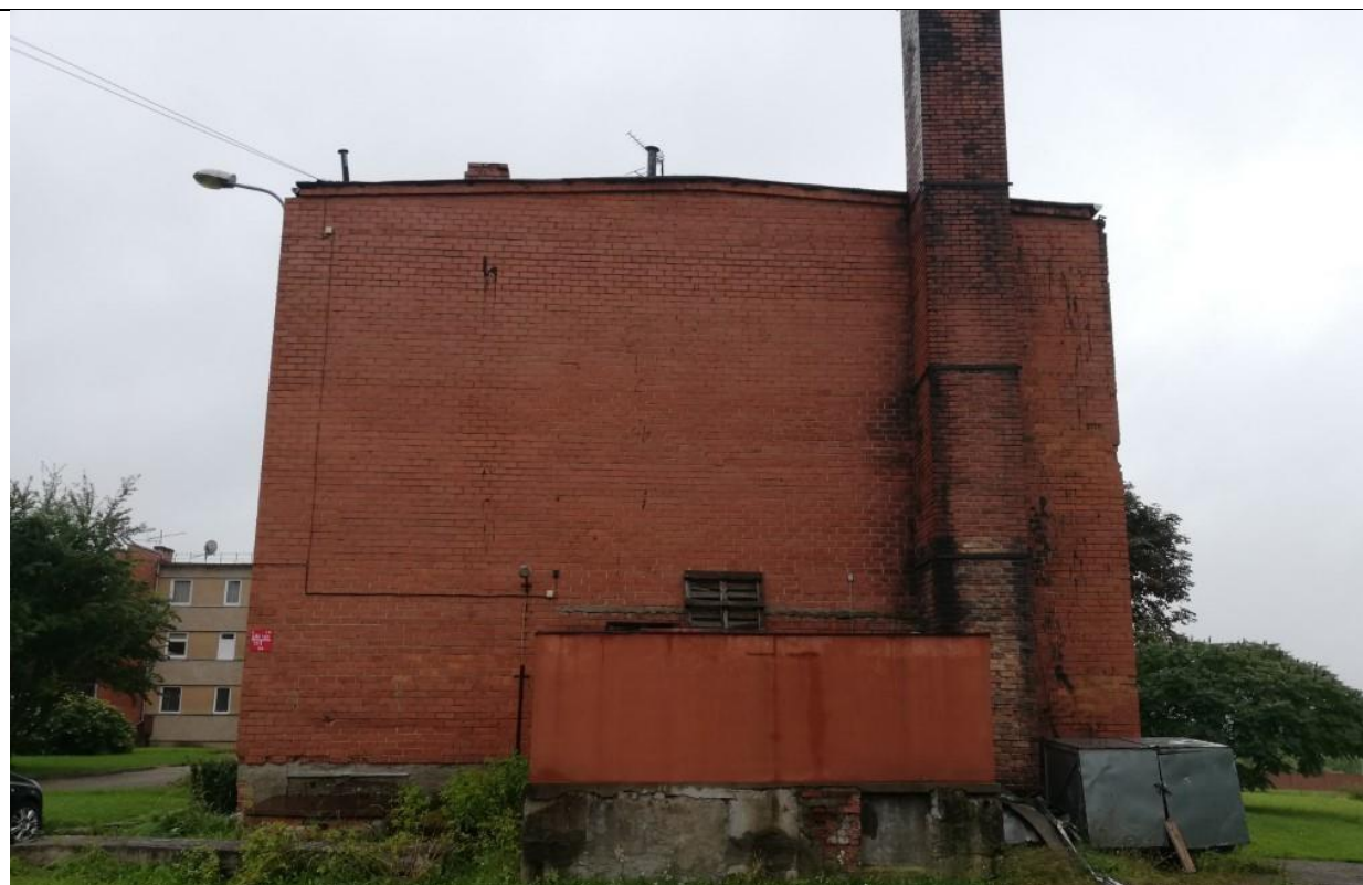
1.4. att. Apsekotā ēka, ziemeļu fasāde.
