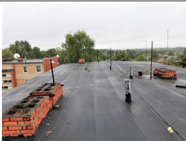
4.8.1.att. Rullveida bitumena jumta segums daļā ēkas jumta ir atjaunots.
