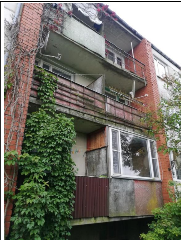
4.9.5., 4.9.6.att. Korodētas margas un ieliekamās detaļas, dažādu materiālu norobežojošās konstrukcijas.
