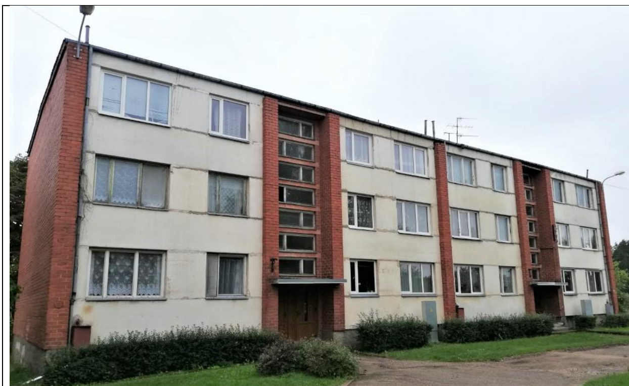
1.4. att. Apsekotā ēka, austrumu fasāde.
