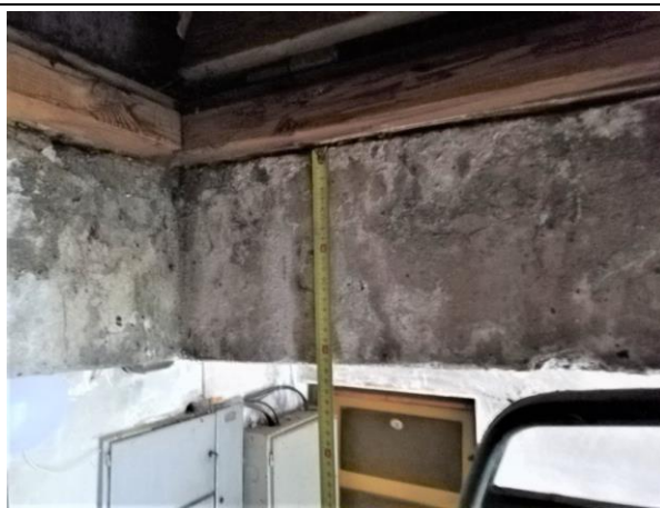
4.8.16.att. Jumta nesošā saliekamā dobā dzelzsbetona pārseguma plātne 220 mm biezumā.
