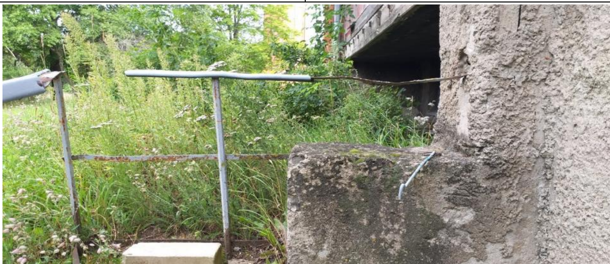
4.10.4.att. Nedrošs norobežojums – iztrūkstošie un korodējuši margu posmi pie pagraba kāpnēm.
