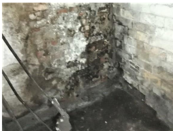
4.1.6.att. Uz pamatu (pagraba) sienām vērojami mitruma radīti bojājumi.
