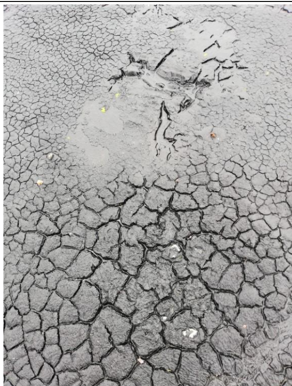
4.8.4.att. Bitumena mastikas segums plaisājis ar iesēdumiem, kuros krājas ūdens, iespējams tas ir nehermētisks.
