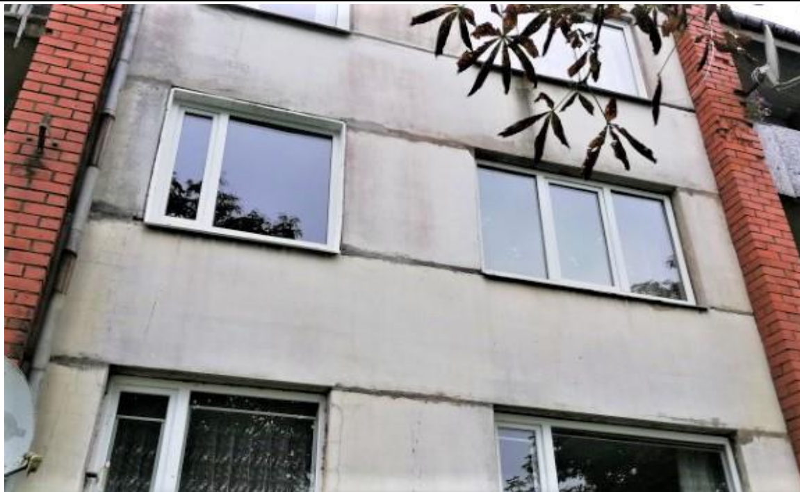
4.4.1.att. Piekarinātie gāzbetona paneļi 300 mm biezumā.
