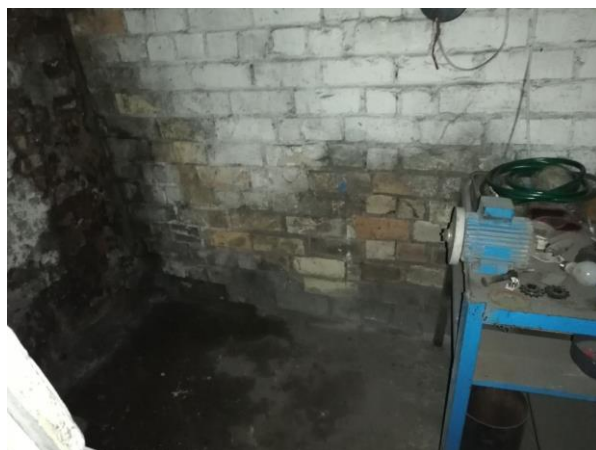
4.1.4.att. Mitruma radīti bojājumi pagraba ārsienās.
