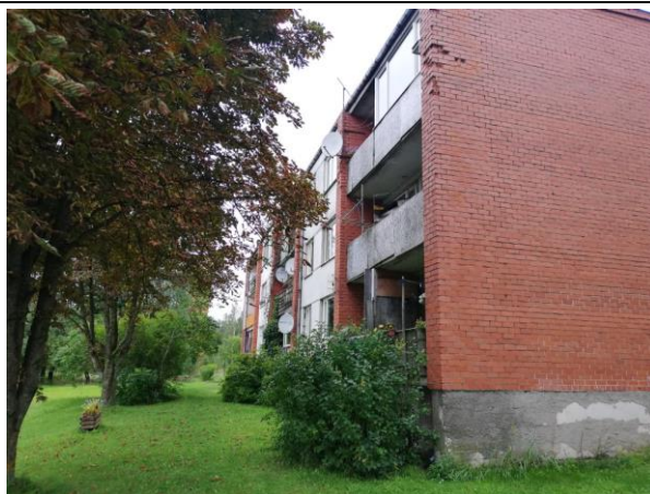
3.3.2.att. Apstādījumi – apmierinošā stāvoklī.
