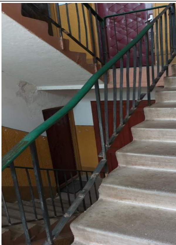
4.10.2.att. Trūkstošie un bojātie margu posmi.
