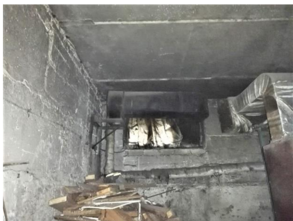
4.1.5.att. Pamatu (pagraba) ārsienas no 400 mm betona blokiem.
