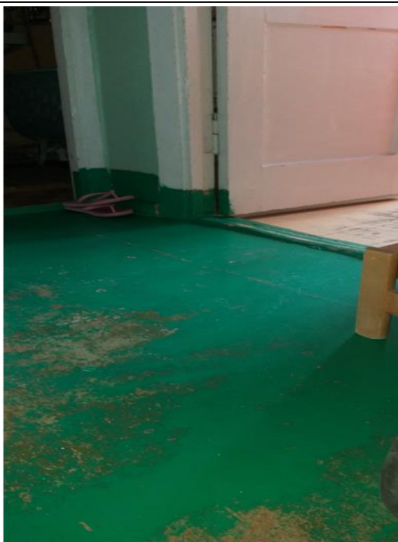
4.12.1., 4.12.2.att. Pastiprināta nodiluma grīdas segumi.
