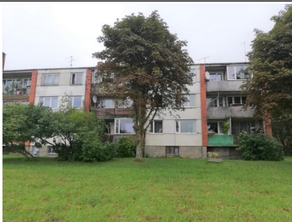
3.3.1.att. Apstādījumi – apmierinošā stāvoklī.
