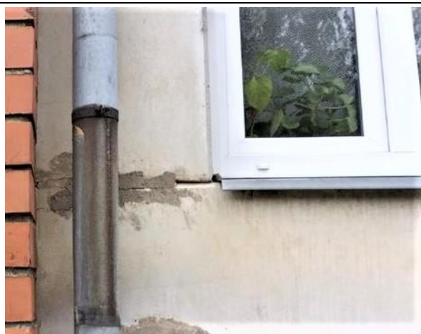
4.5.1. att. Nehermētiska starp paneļu šuve.
