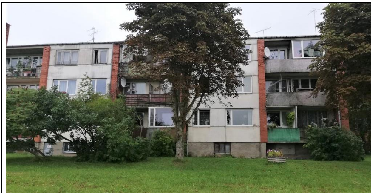
1.4. att. Apsekotā ēka, rietumu fasāde.
