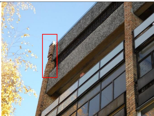
4.2.10.att. Izdrupumi nesošās mūra sienas augšdaļā (1.sekcija), sk. kopā ar att. 4.2.11.
