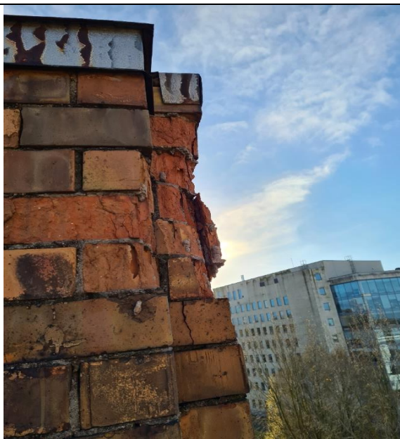
4.2.10.att. Izdrupumi nesošās mūra sienas augšdaļā (1.sekcija), sk. kopā ar att. 4.2.11.
