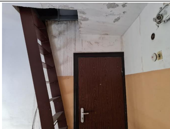
4.10.8.att. Metāla kāpnes uz jumtu
