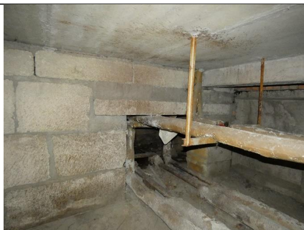
4.1.8.att. Tehniskais gaitenis ēkas pagrabā: pamatu bloki 400 mm biezumā
