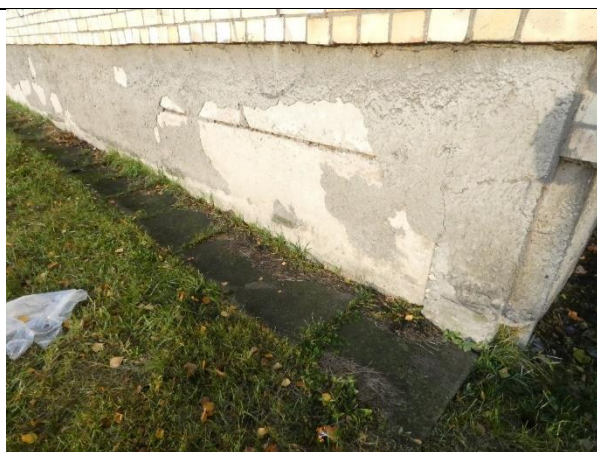
4.1.1.att. Ēkas gala sienas pamatu bloki ar horizontālo hidroizolāciju
