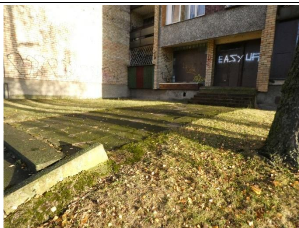
3.1.2.att. Betona plātņu ietves ar iesēdumiem un apaugumu DR pusē
