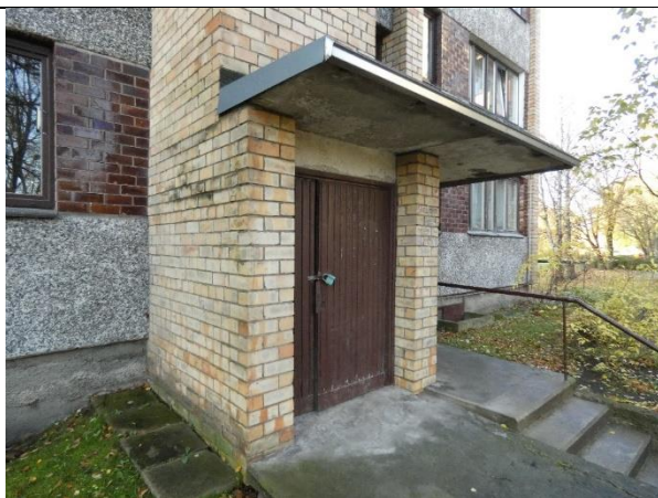
4.9.5.att. Jumtiņš ar valcētā skārda segumu 1.sekcija
