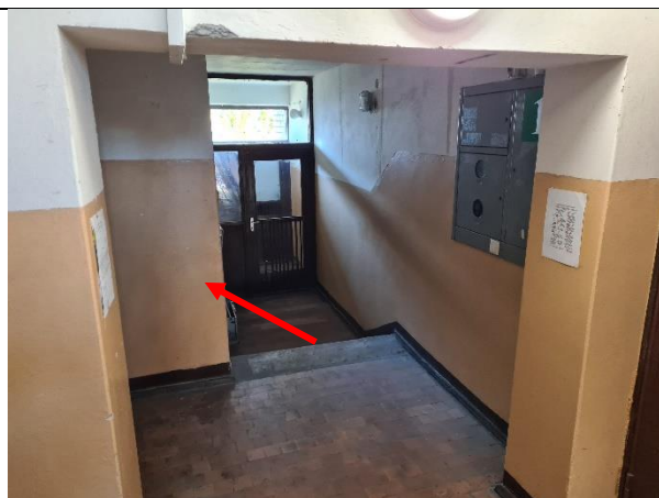
4.11.2.att. Ķieģeļu mūra starpsiena kāpņu telpā
