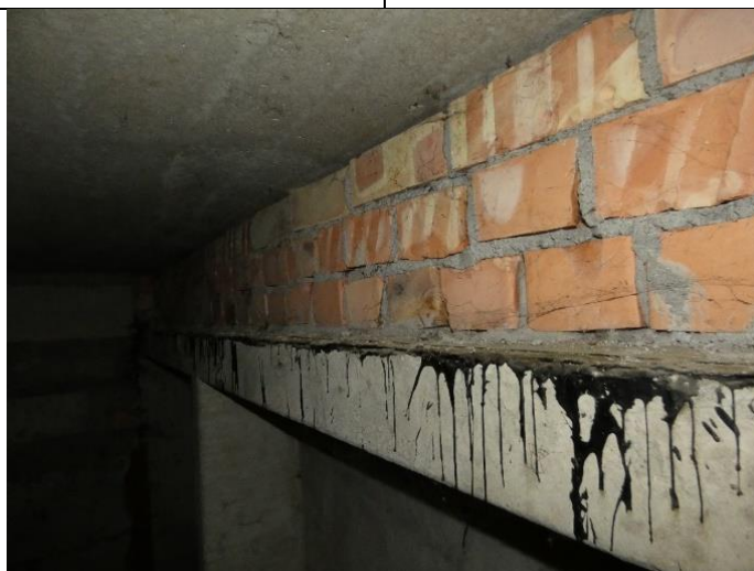
4.2.22.att. Horizontālā hidroizolācija virs ārsienu cokola paneļiem, ēkas pagrabā
