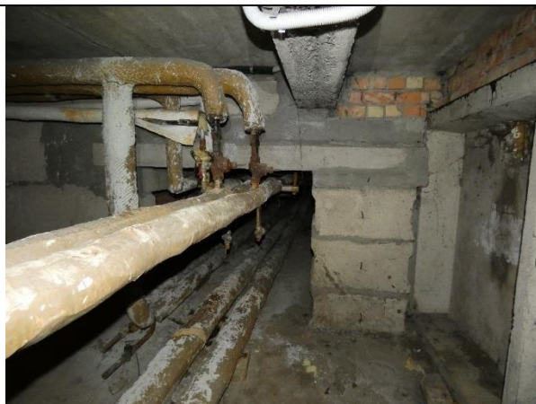
4.1.5.att. Pamatu bloki ēkas pagraba tehniskajā gaitenī. Pārsedze balstīta uz pamatu blokiem
