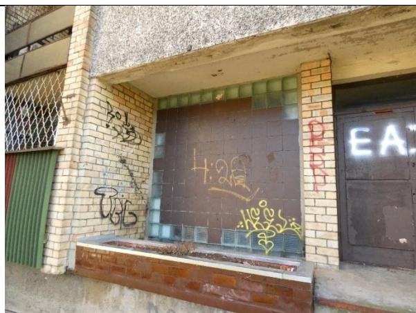
4.12.1.att. Ratiņtelpas ailas aizpildījums ar stikla blokiem, atbilstoši Projektam
