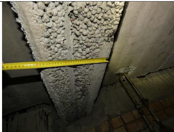
4.4.2.att. Keramzītbetona ārsienu paneļi 300 mm biezumā
