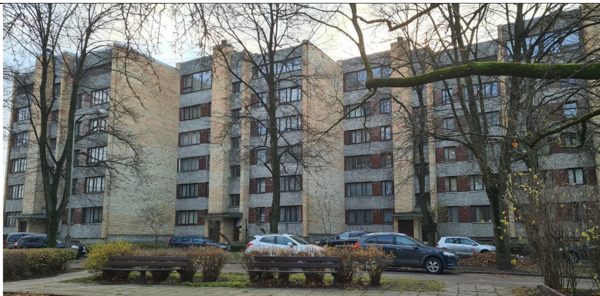
1.4. att. Apsekotā ēka, ziemeļaustrumu fasāde
