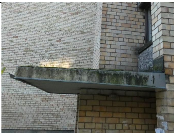
4.9.7.att. Skārda seguma pieslēgums pie ārsienas
