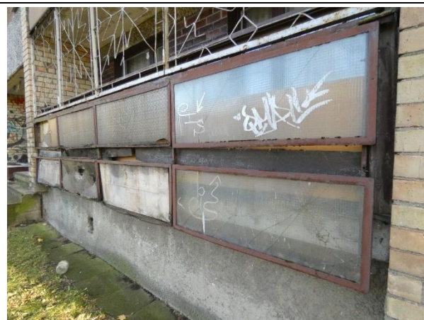
4.9.2.att. Armētā stikla aizpildījums bojāts, vietām stikls nomainīts ar saplāksni
