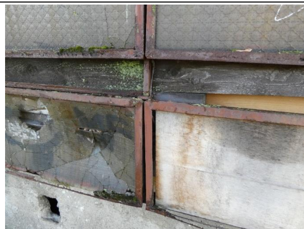
4.9.4.att. Armētā stikla aizpildījums bojāts, kas rada lietošanas risku
