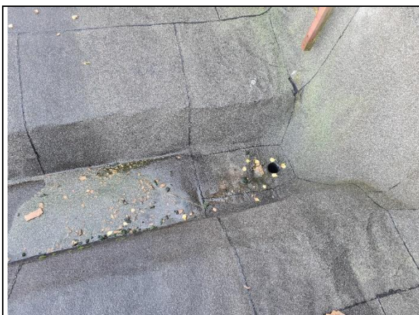
4.8.25.att. Jumta lietus ūdens novadīšanas tekne, atvere bez aizsargrestes
