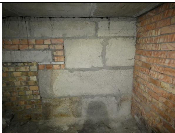
4.1.4.att. Pamatu bloki ēkas pagrabā. Vietām mūrēti iecirkņi.
