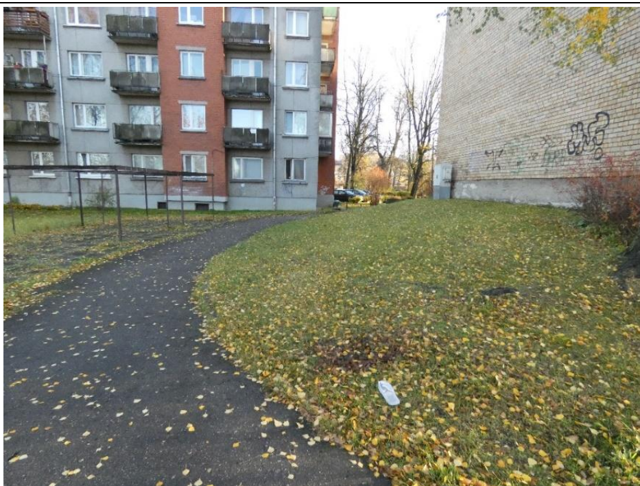
3.1.5.att. Asfaltbetona seguma ietve ēkas ZR pusē
