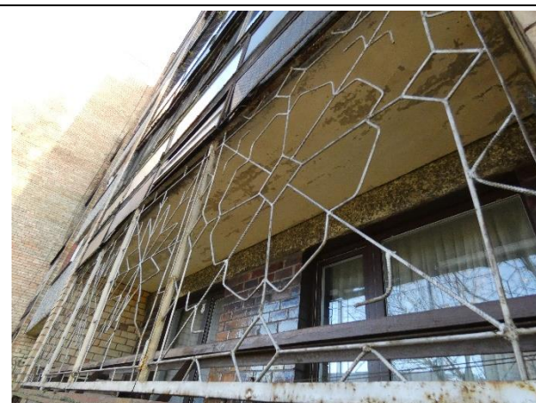
4.6.5.att. Lodžijas pārseguma plātne 1190 mm platumā. Nebūtiski virsmas mitruma bojājumi.
