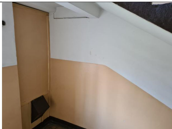
4.16.1.att. Atkritumu vada vāks pieskrūvēts un atkritumu vads netiek ekspluatēts
