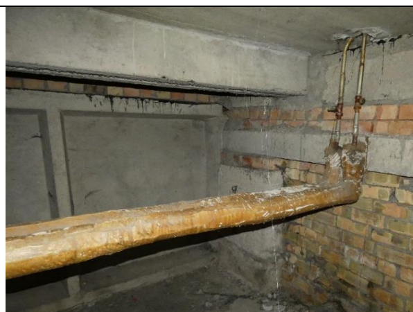
4.2.20.att. Ārsienu cokola paneļi labā tehniskā stāvoklī
