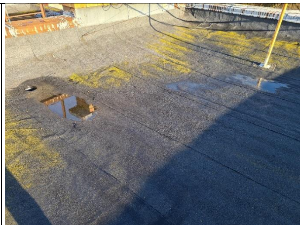
4.8.20.att. Jumta segums ar apaugumu
