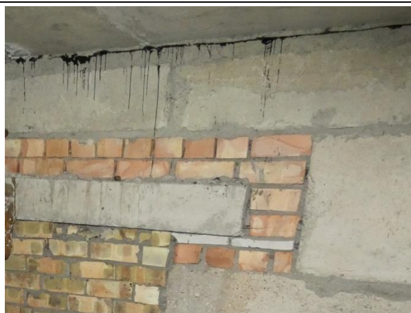
4.5.2.2.att. Gala sienas pamatu horizontālā hidroizolācija ēkas pagrabā
