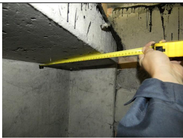
4.2.21.att. Ārsienu cokola paneļi un horizontālā hidroizolācija virs tiem ēkas pagrabā
