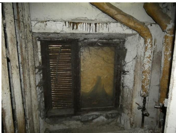
4.12.7.att. Pagraba logu aillas aizpildītas ar metāla ventilācijas resti un stiklojumu
