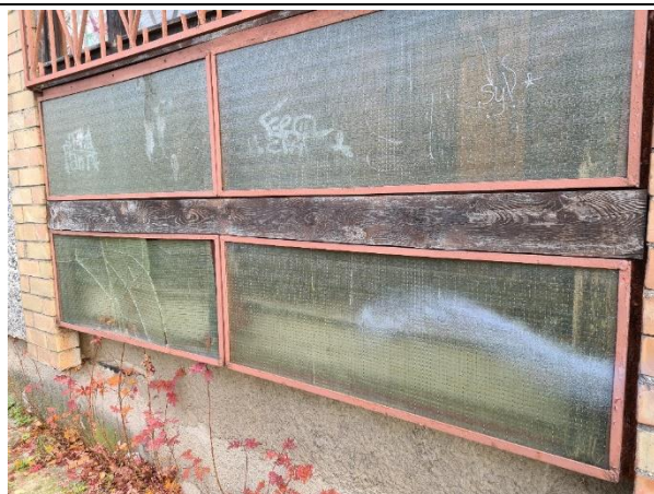
4.9.3.att. Armētā stikla aizpildījums bojāts
