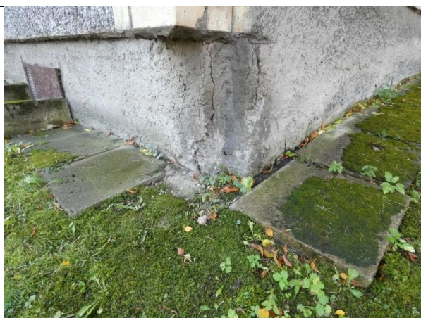
4.1.3.att. Pamatu bloku apmetums ar plaisām un izdrupumiem. Aizsargapmale sabrukusi.
