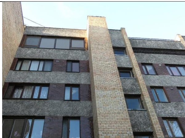
4.4.1.att. Fasādes siena - ārsienu paneļi 300 mm biezumā
