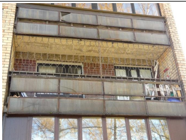
4.9.1.att. Lodžijas ar metāla rāmja norobežojošo konstrukciju un armētā stikla aizpildījumu
