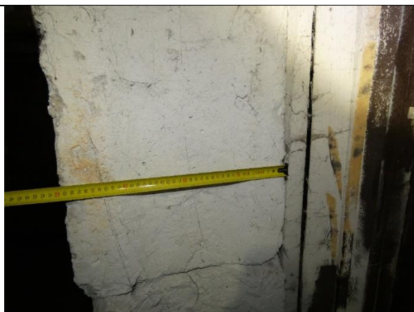
4.1.7.att. Pamatu bloki ēkas pagrabā 400 mm biezumā
