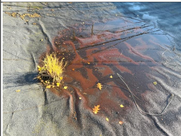
4.8.19.att. Jumta segums ar lokāliem iesēdumiem
