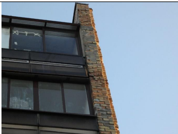
4.2.8.att. Izdrupumi nesošās mūra sienas augšdaļā (2.sekcija)
