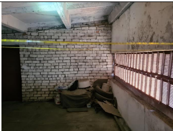
4.2.18.att. Nesošās māla ķieģeļu mūra šķērssienas ēkas bēniņos
