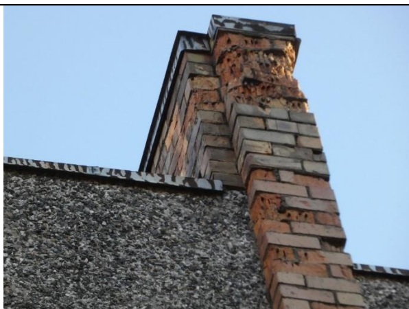
4.2.4.att. Izdrupumi nesošās mūra sekcijas gala sienas augšdaļā pie jumta parapeta (3.sekcija)
