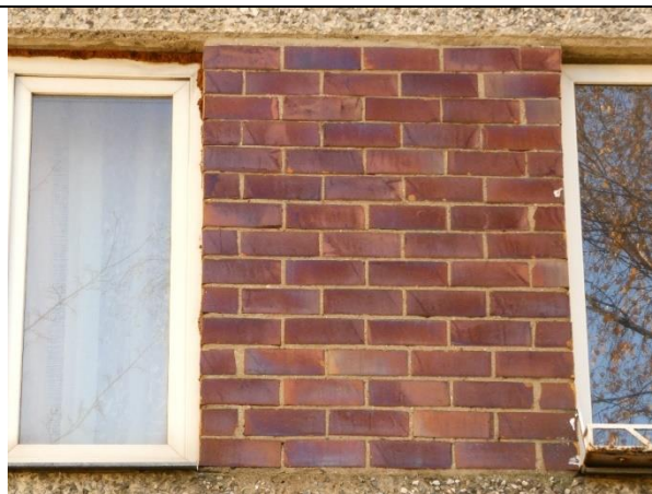
4.4.4.att. Ailas aizpildījums starp logiem veidots no glazētu ķieģeļu mūra
