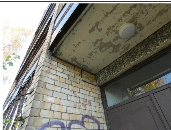
4.6.6.att. Lodžijas pārseguma plātne 1190 mm platumā. Nebūtiski virsmas mitruma bojājumi.
