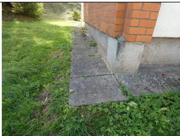
4.1.7.att. Aizsargapmale ar apaugumu un deformācijas pazīmēm
