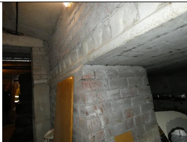
4.1.6.att. Pamatu bloki un ķieģeļu mūra iecirkņi ēkas pagrabā
