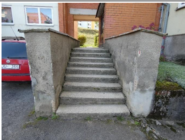
4.10.7.att. Kāpnes pie ieejas mezgla ar betona struktūras bojājumiem
