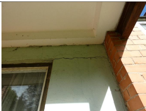
4.4.10.att. Ārsienu paneļi ar plaisām starppaneļu šuvju aizdarē
