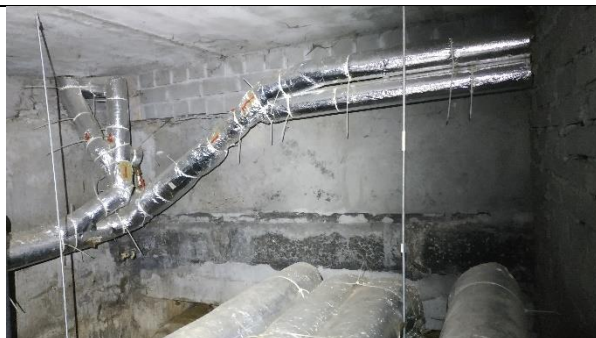
4.1.3.att. Pamatu bloki ar ķieģeļu mūra iecirkņiem
