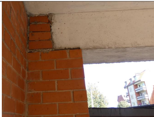
4.2.6.att. Ķieģeļu mūra izdrupumi, mitruma infiltrācijas rezultātā iekštelpās bojājumi, sk. att. 4.2.5.
