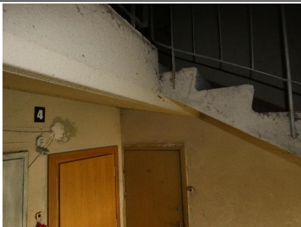
4.10.3.att. Kāpņu konstrukcijas labā tehniskajā stāvoklī
