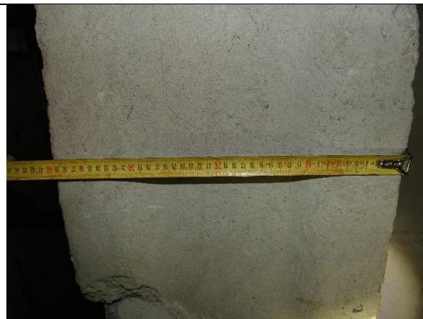
4.1.2.att. Pamatu bloki ēkas pagrabā 400 mm biezumā
