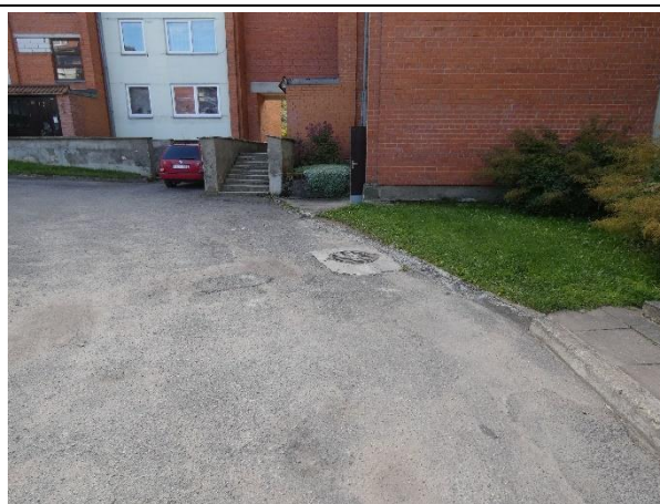
3.1.2.att. Brauktuves ar asfaltbetona segumu ziemeļu pusē. Sadrupušas ceļa apmales.
