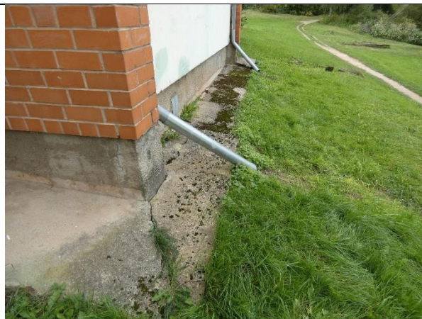
4.1.10.att. Aizsargapmale ar apaugumu un deformācijas pazīmēm
