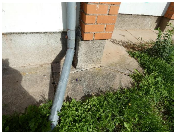
4.1.8.att. Nosēdusies un saplaisājusi aizsargapmales mala
