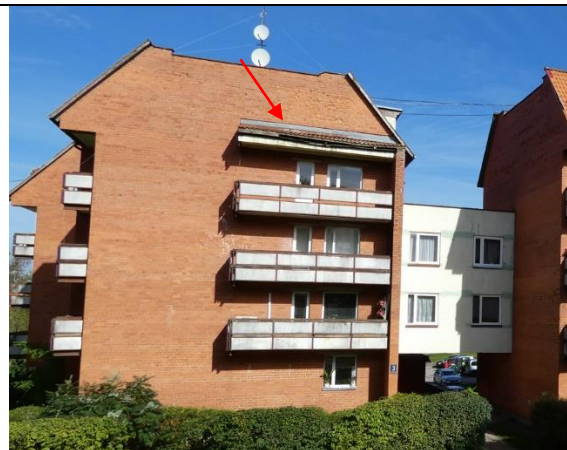
1.5. att. Apsekotā ēka, dienvidu fasāde, 3.sekcija. Jumtiņa virs 4.stāva lodžijas fotofiksāciju sk. att. 4.9.3.
