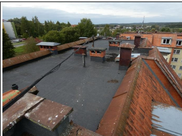
4.8.15.att. Savietotā jumta plakanajā daļā ierīkots bitumena ruļļveida materiāla segums divās kārtās. Siltumizolācija nav ierīkota.
