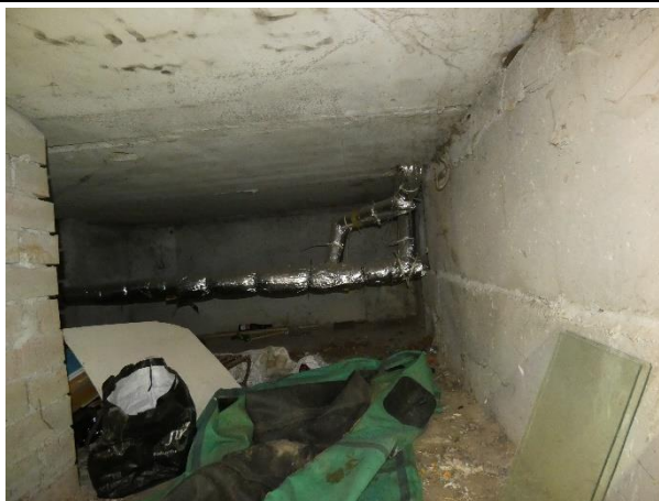
4.6.3.att. Pagraba pārseguma plātnes labā tehniskajā stāvoklī
