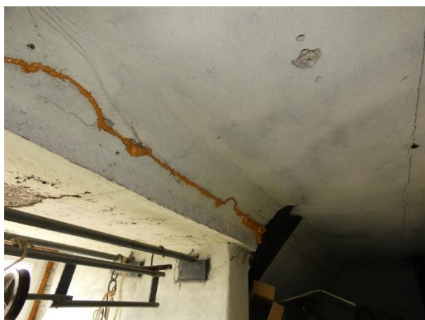
4.8.7.att. Jumta dzelzsbetona pārseguma plātnes un nesošās metāla konstrukcijas U-profilu ēkas 5.stāvā. Spraugas plātņu un monolītā iecirkņa saduršuvēs aizdarinātas ar montāžas putām.
