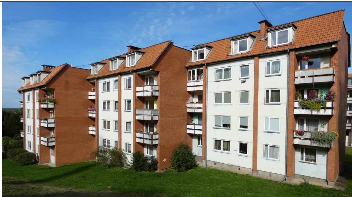
1.1. att. Apsekotā ēka, dienvidu fasāde, 1., 2. un 3. sekcija
