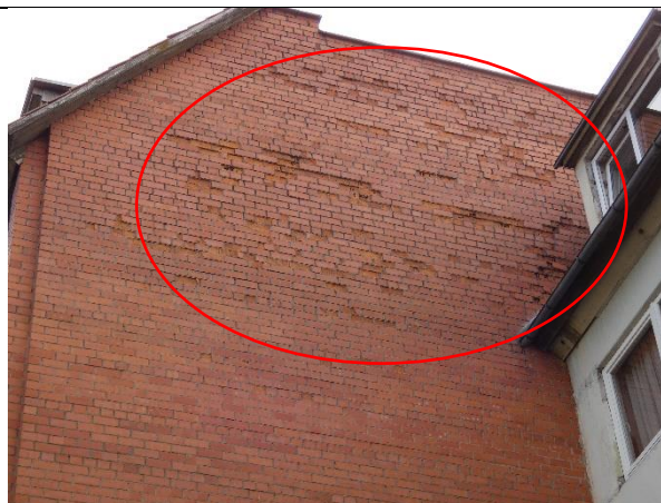
4.2.6.att. Ķieģeļu mūra izdrupumi, mitruma infiltrācijas rezultātā iekštelpās bojājumi, sk. att. 4.2.5.
