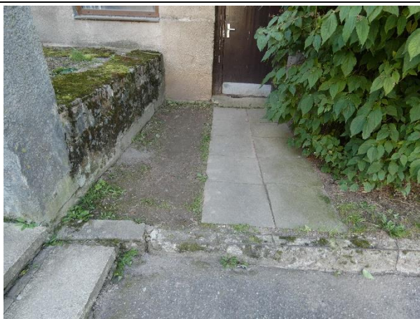
3.1.1.att. Brauktuves ar asfaltbetona segumu ziemeļu pusē. Pilnībā sadrupušas ceļa apmales.
