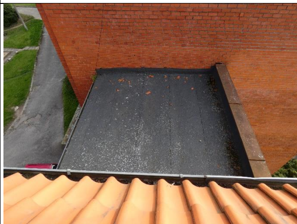
4.8.18.att. Savietotā jumta bitumena ruļļveida materiāla segums būves daļai starp 3. un 4. sekciju (virs caurbrauktuves). Skārda nosed detaļas korodējušas.
