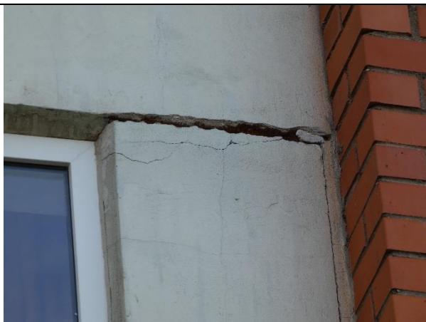
4.4.7.att. Izdrupis starppaneļu šuvju aizpildījums, mikroplaisas paneļos
