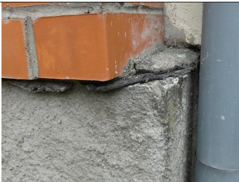
4.5.3. att. Horizontālā hidroizolācija virs pamatu blokiem
