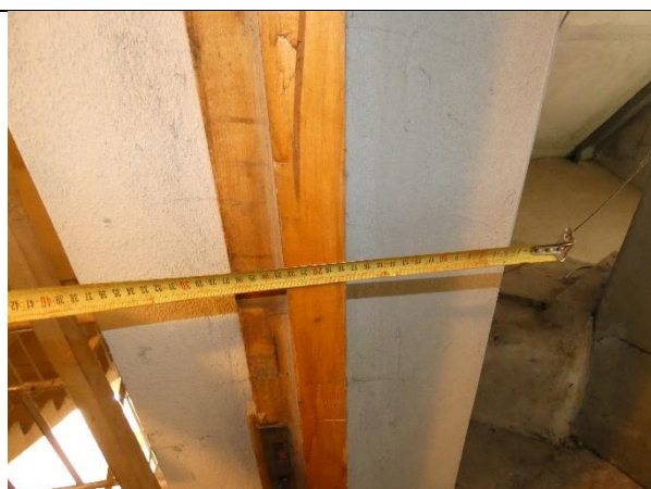
4.2.1.att. nesošās mūra šķērssienas kāpņu telpās 380 mm biezumā
