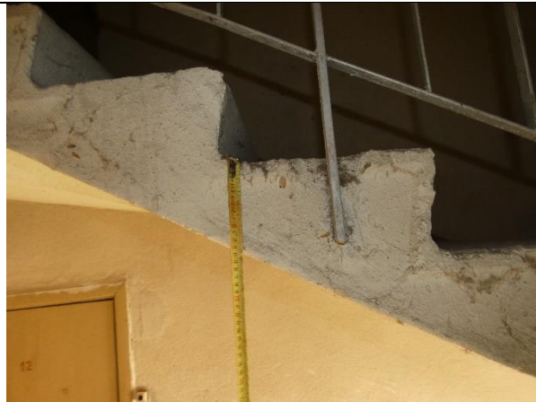
4.10.2.att. Kāpņu laidumu konstrukcijas labā tehniskajā stāvoklī
