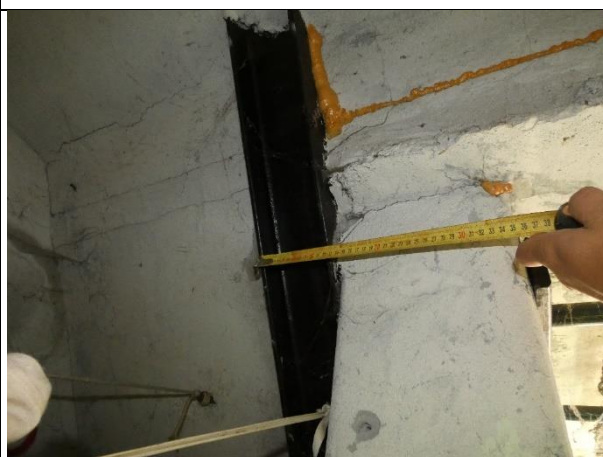
4.8.10.att. Jumta dzelzsbetona pārseguma plātnes un nesošās metāla konstrukcijas U-profilu Nr.12
