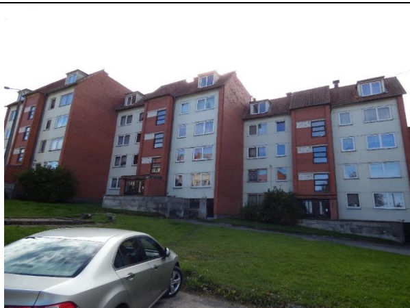
1.2. att. Apsekotā ēka, ziemeļu fasāde, 1., 2. un 3. sekcija
