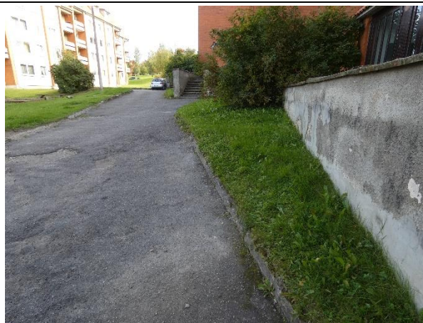
3.1.2.att. Brauktuves ar asfaltbetona segumu ziemeļu pusē. Sadrupušas ceļa apmales.
