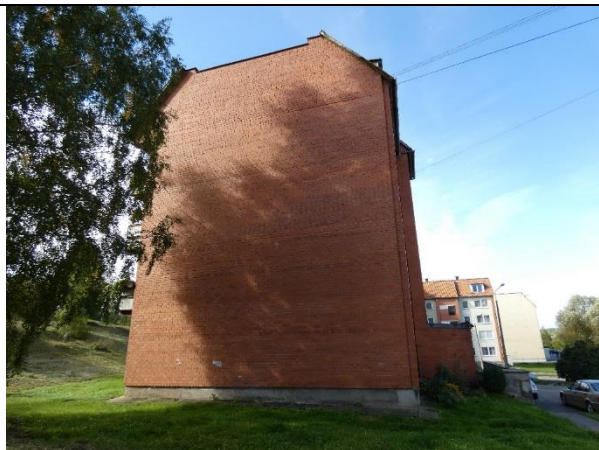
1.4. att. Apsekotā ēka, rietumu fasāde, 1.sekcija
