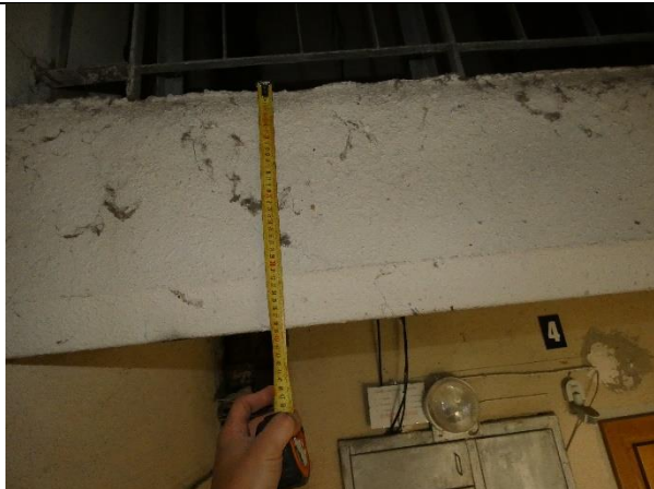
4.10.1.att. Kāpņu laukumu konstrukcijas labā tehniskajā stāvoklī
