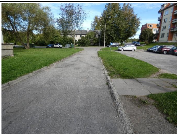
3.1.1.att. Brauktuves ar asfaltbetona segumu ziemeļu pusē. Pilnībā sadrupušas ceļa apmales.
