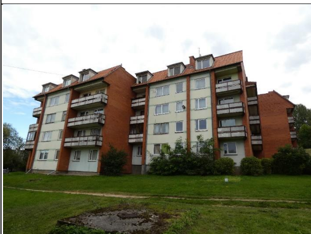
1.6. att. Apsekotā ēka, rietumu fasāde, 3. un 4. sekcija
