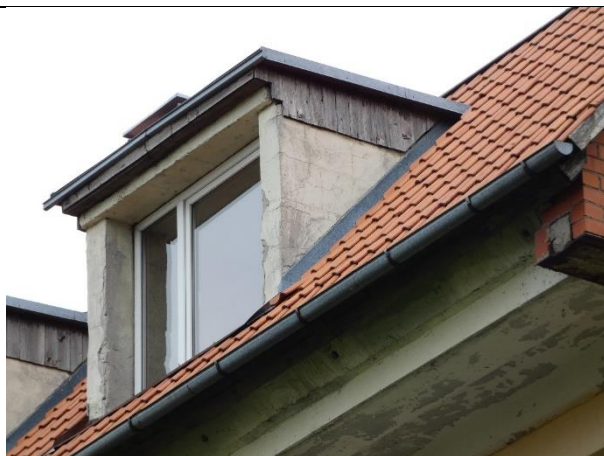
4.8.9.att. Jumta dzelzsbetona pārseguma plātnes un nesošās metāla konstrukcijas U-profilu Nr.20
