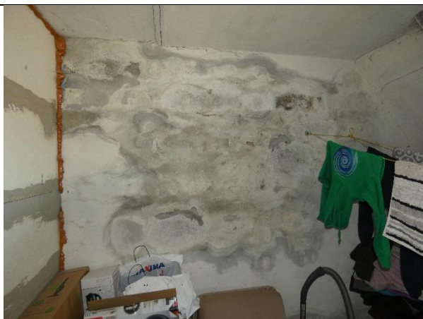
4.2.5.att. Mitruma radīti bojājumi 5.stāva telpās. Skatīt ārsienas fragmentu attēlā 4.2.6.
