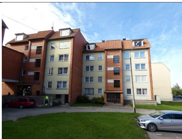
1.7. att. Apsekotā ēka, austrumu fasāde, 3. un 4. sekcija
