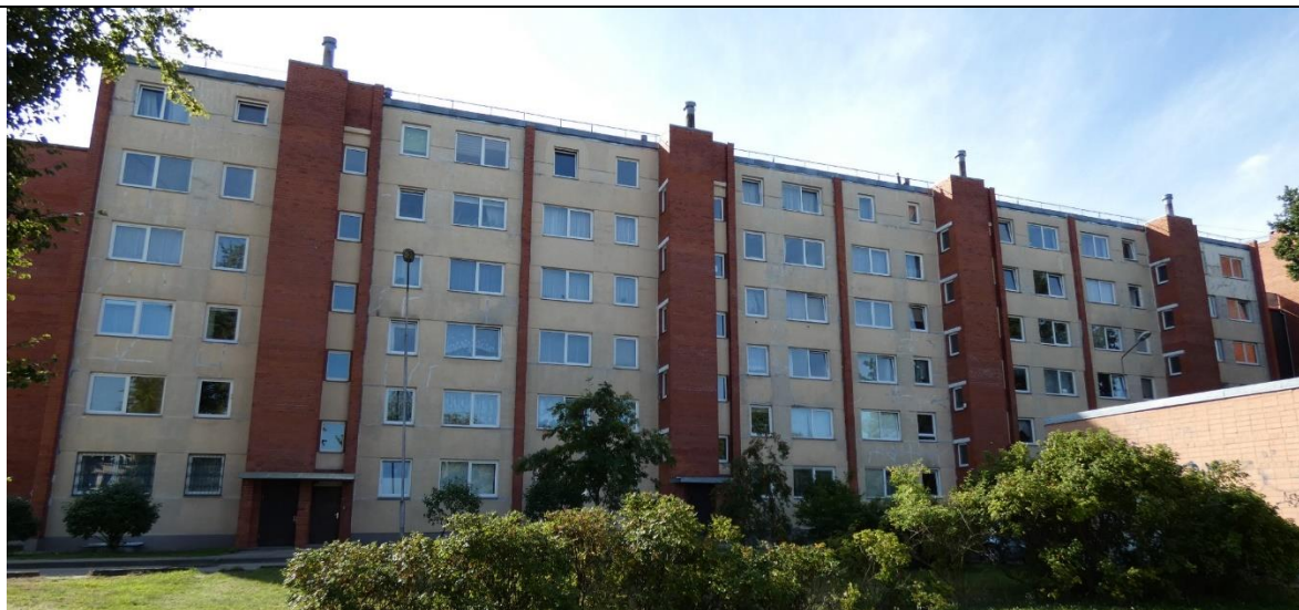
1.3. att. Apsekotā ēka, ziemeļrietumu fasāde
