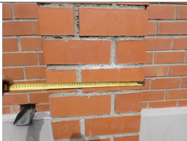
4.2.7.att. Nesošās mūra šķērssienas 380 mm biezumā
