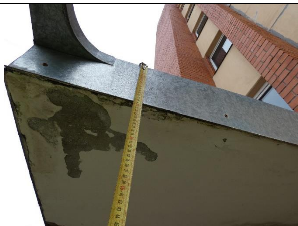
4.9.8.att. Jumtiņa dzelzsbetona plātne 180 mm biezumā
