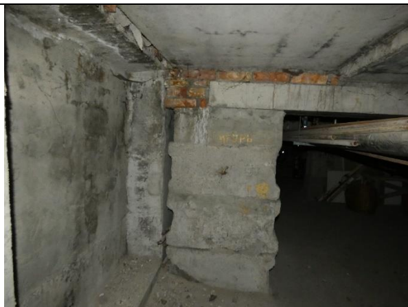
4.1.2.att. Pamatu bloki ēkas pagrabā. Lodžiju pārseguma plātņu balsta vietā ierīkota māla ķieģeļu mūra kārtā – mūrēšanas darbi veikti nekvalitatīvi.
