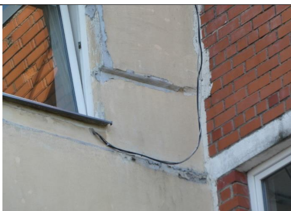
4.4.3. att. Ārsienu paneļi. Starppaneļu šuvju aizdare veikta nekvalitatīvi.
