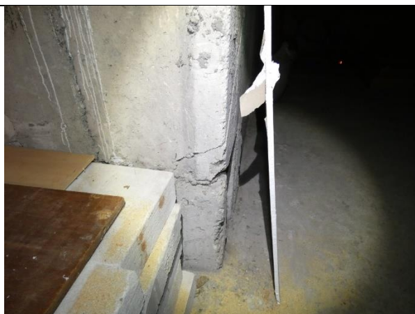
4.1.9.att. Pamatu bloki ēkas pagrabā 400 mm biezumā. Pielietoti nekvalitatīvi
