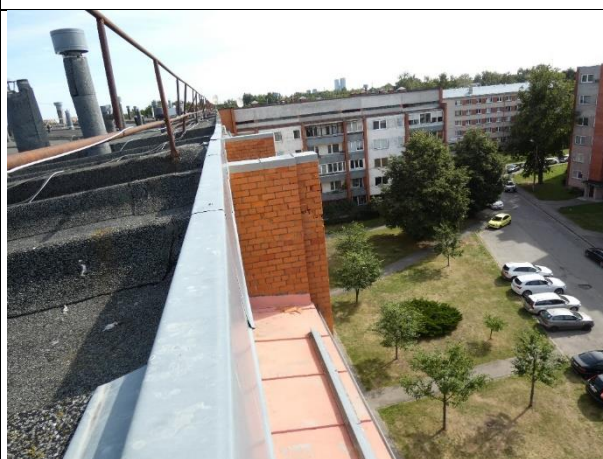
4.8.15.att. Skārda nasegdetāļas labā tehniskā stāvoklī
