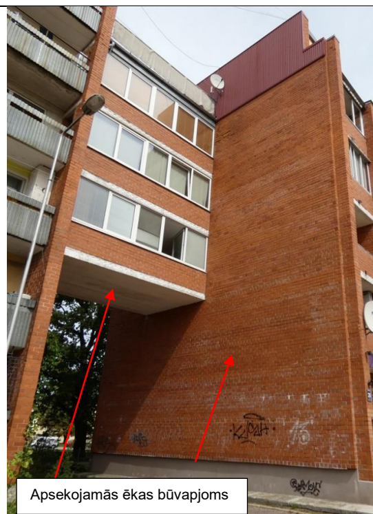
1.2. att. Apsekotā ēka, DR fasādes daļa
