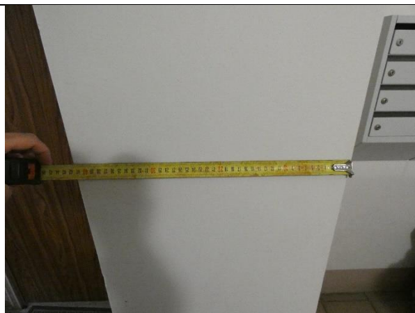
4.2.19.att. Kāpņu telpas nesošā mūra siena 380 mm biezumā
