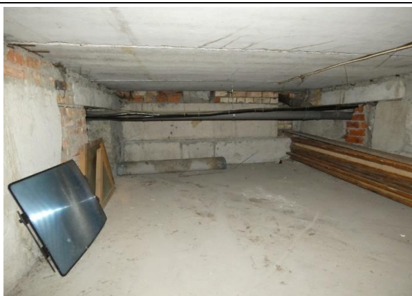
4.6.7.att. Pagraba pārseguma plātnes labā tehniskā stāvoklī
