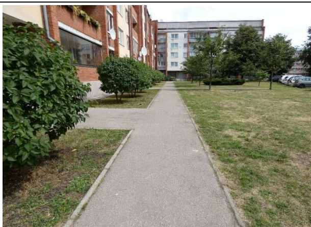
3.1.1.att. Apkārt ēkai izbūvētas ietves ar asfaltbetona segumu.
