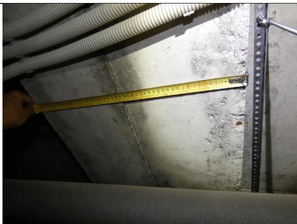
4.2.6.att. Dzelzsbetona gatavelementu pārsedzes pagrabā 250x250 mm
