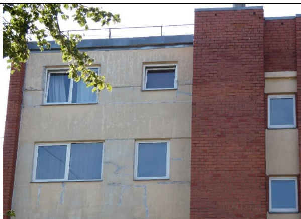
4.4.1. att. Ārsienu paneļi 240 mm biezumā
