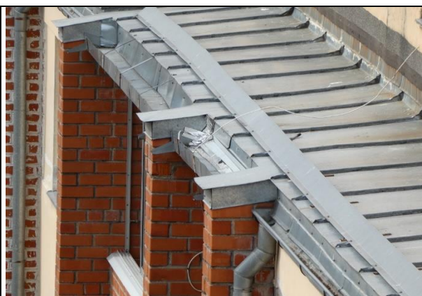
4.8.19.att. Valcētā skārda segums jumta konstrukcijai virs 5.stāva
