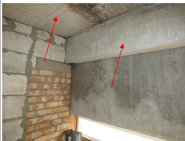
4.8.4.att. Jumta klāja dzelzsbetona plātnes balstītas uz rīģeli PK1
