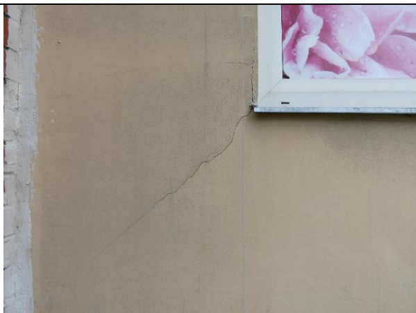
4.4.17. att. Ārsienas paneļi ar mikroplaisām
