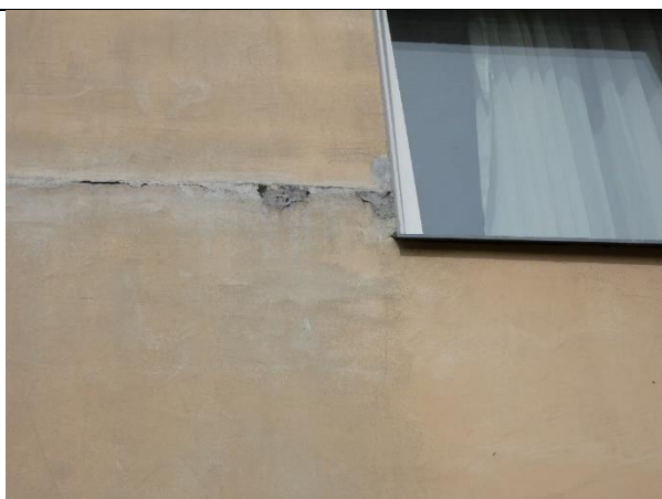
4.4.19. att. Izdrupumi starppaneļu šuvē, aizdare veikta nekvalitatīvi
