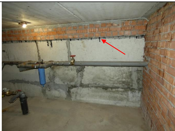
4.1.1.att. Pamatu bloki ēkas pagrabā, hidroizolācija uz atz. -0,62 m
