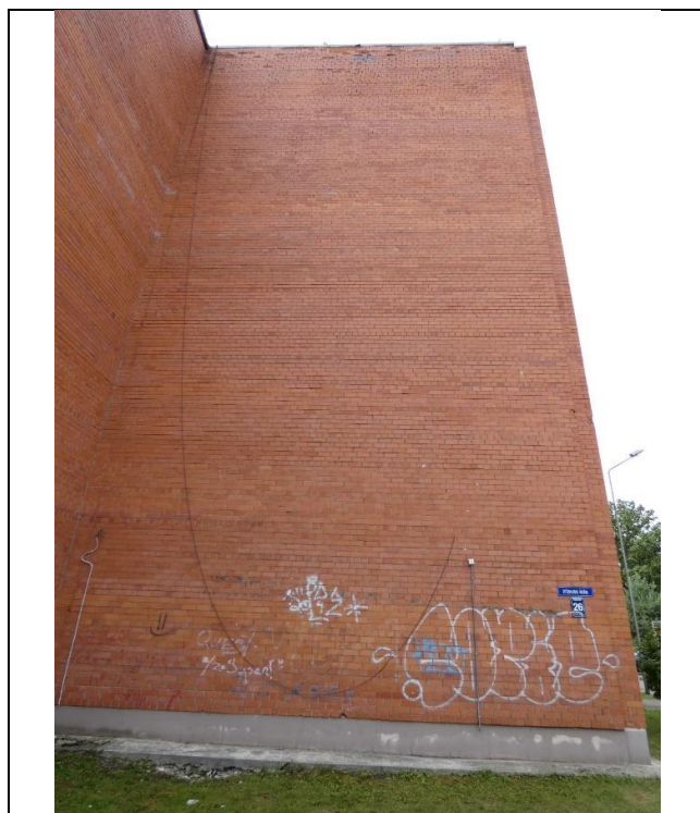
1.1. att. Apsekotā ēka, ZA fasāde
