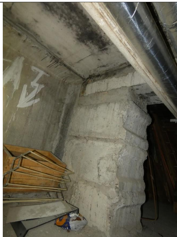
4.1.4.att. Pamatu bloki ēkas pagrabā. Lodžiju pārseguma plātņu balsta vieta.
