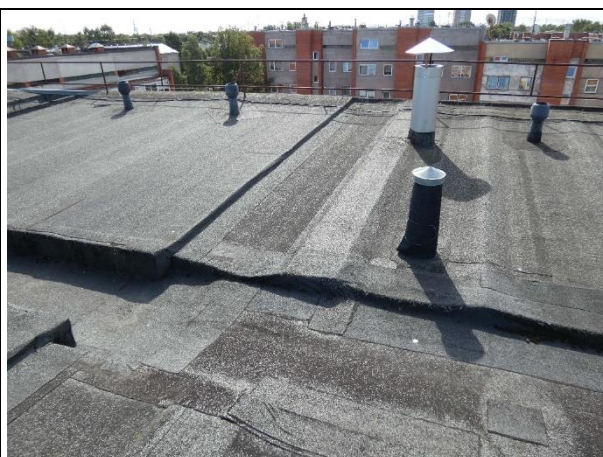
4.8.13.att. Jumta segums labā tehniskajā stāvoklī
