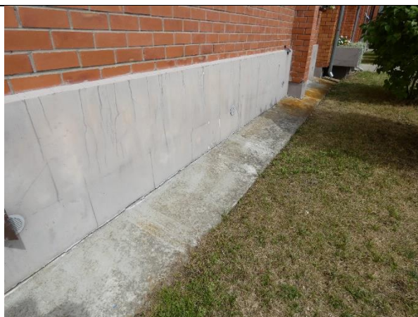
4.1.10.att. Pamatu cokola daļai ierīkota siltumizolācija ar putupolistirola loksnēm 50 mm biezumā.
