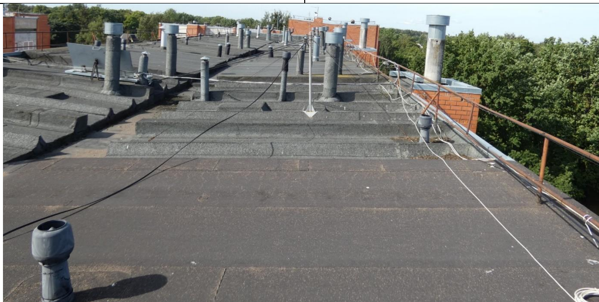
4.8.11.att. Jumtam daļējā apjomā ierīkota siltumizolācijas kārtā
