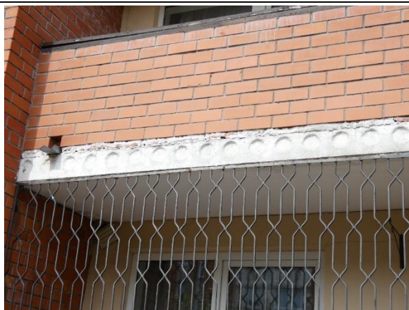
4.6.4.att. Lodžiju pārseguma plātnes labā tehniskā stāvoklī
