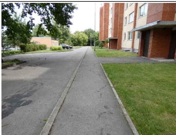
3.1.3.att. Piebraucamie ceļi un ietves ar asfaltbetona segumu apmierinošā tehniskajā stāvoklī.
