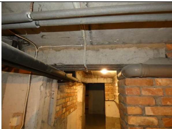
4.2.4.att. Dzelzsbetona gatavelementu pārsedzes pagrabā, sk. kopā ar att.4.2.5.
