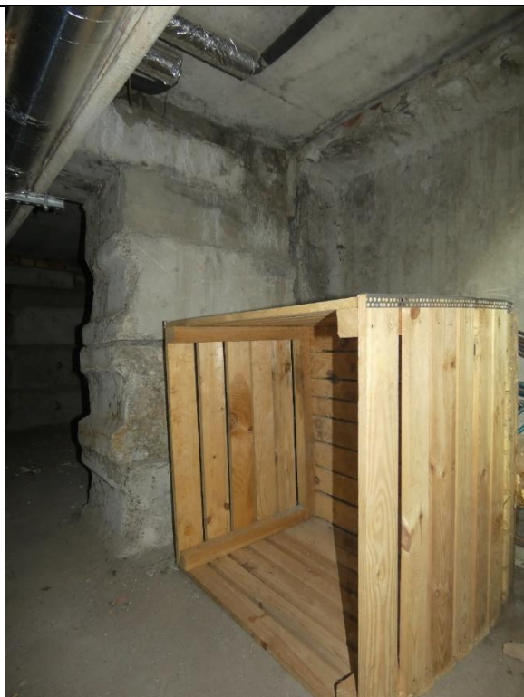
4.1.3.att. Pamatu bloki ēkas pagrabā. Lodžiju pārseguma plātņu balsta vieta.
