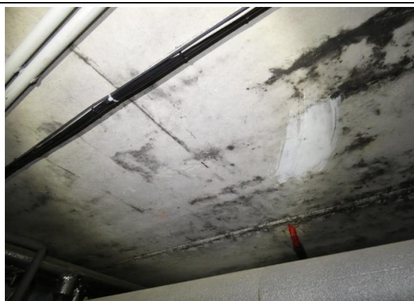
4.6.8.att. Ugunsgrēka rezultātā apkvēpis pagraba pārsegums. Neatbilstošs stiebrojuma aizsargslānis.
