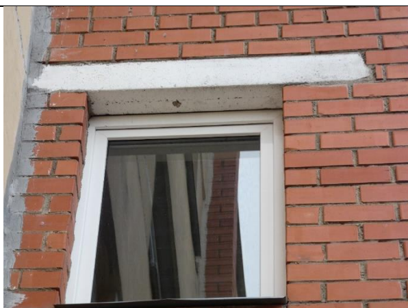
4.2.8.att. Dzelzsbetona gatavelementu pārsedze virs loga kāpņu telpā
