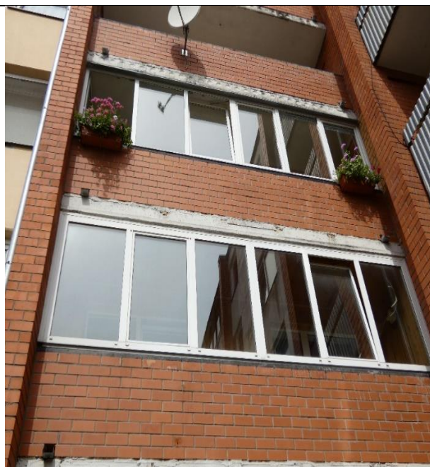
4.12.2.att. Lodžiju ailu aizpildījums ar PVC logiem
