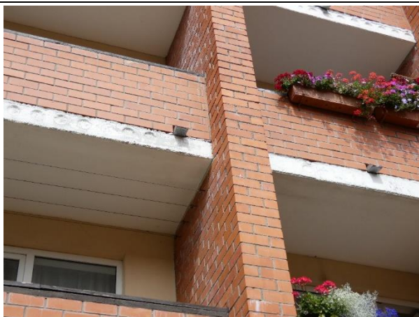
4.6.5.att. Lodžiju pārseguma plātnes un balsta vietas labā tehniskā stāvoklī
