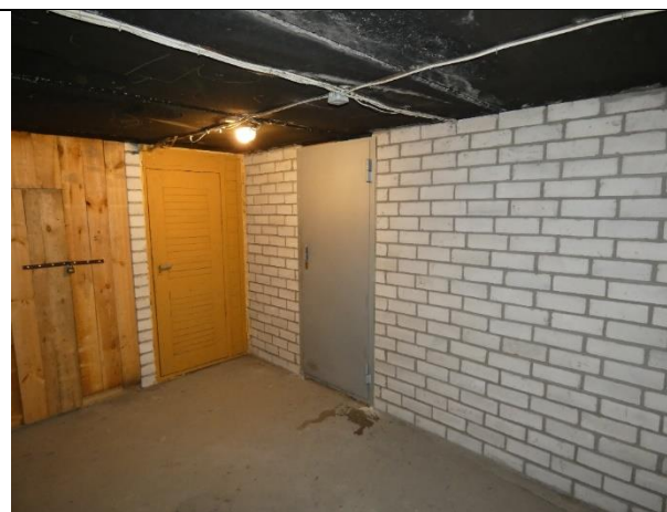
4.11.1.att. Silikāta ķieģeļu mūra starpsienas pagraba stāvā
