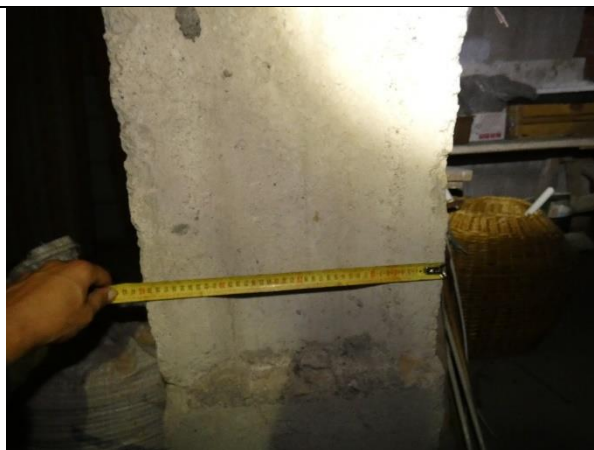
4.1.8.att. Pamatu bloki ēkas pagrabā 400 mm biezumā
