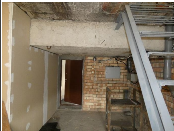
4.8.1.att. Dzelzsbetona tekne 1500 mm platumā
