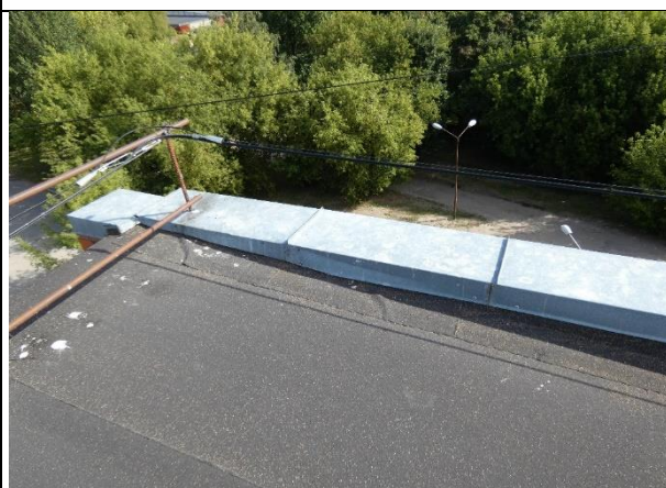
4.8.9.att. Jumtam virs dzīvokļa ierīkota siltumizolācijas kārtā. Margas nav uzstādītas.
