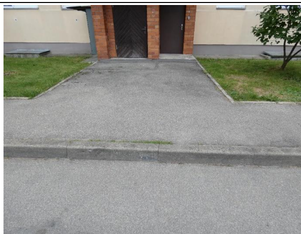
3.1.4.att. Piebraucamie ceļi un ietves ar asfaltbetona segumu apmierinošā tehniskajā stāvoklī.
