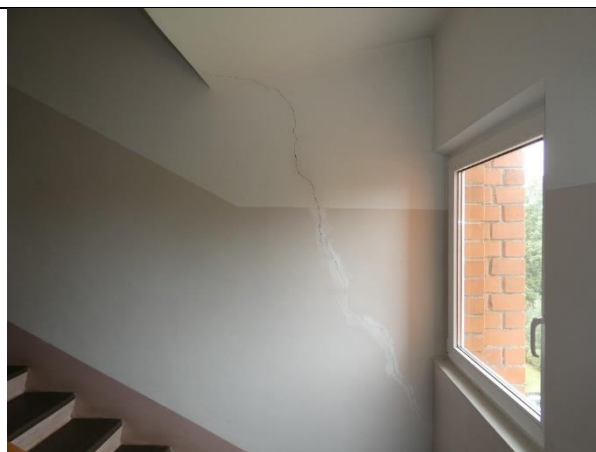
4.2.13.att. Plaisa 1.kāpņu telpas nesošajā mūra šķērssienā
