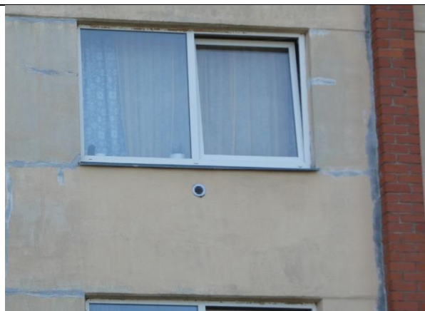
4.4.2. att. Ārsienu paneļi. Veikta starppaneļu šuvju aizdares atjaunošana.
