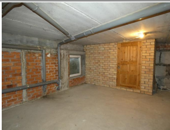
4.6.6.att. Pagraba pārseguma plātnes labā tehniskā stāvoklī
