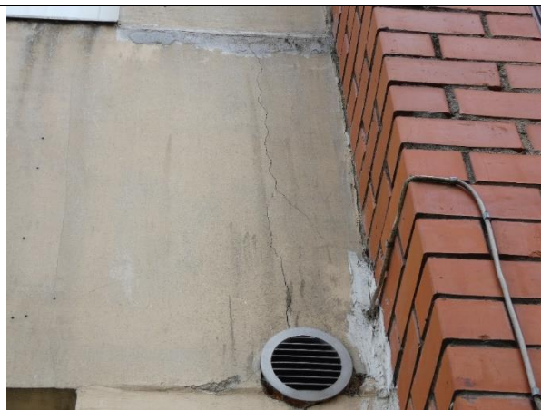
4.4.18. att. Ārsienas paneļi ar mikroplaisām
