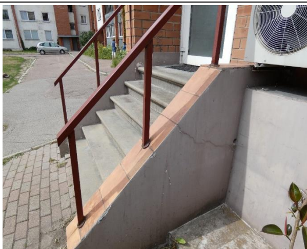
4.10.7.att. Plaisa kāpņu atbalsta sienā – ieeja nedzīvojamā telpā, nevis kāpņu telpā.
