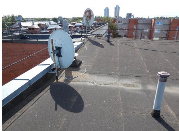
4.8.10.att. Jumtam ierīkota siltumizolācijas kārtā.
