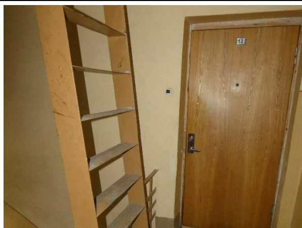
4.10.8.att. Kāpnes uz jumtu apmierinošā stāvoklī.
