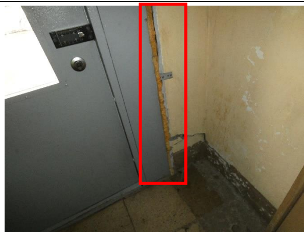
4.13.2. att. Nav veidota atbilstoša durvjailas apdare pēc montāžas.
