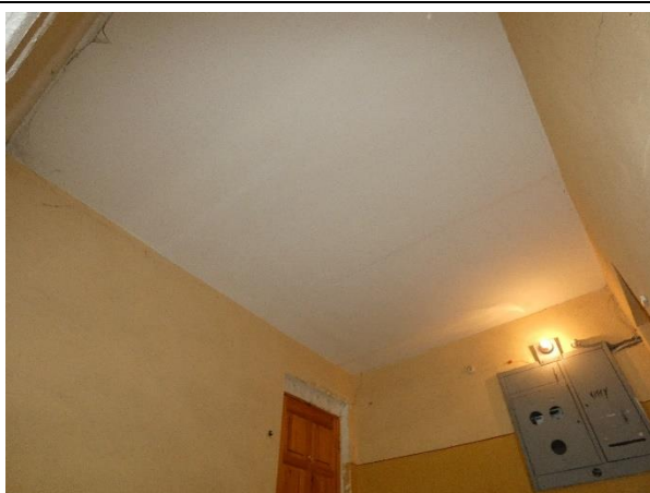
4.6.5. att. Pārsegums virs kāpņu telpas apmierinošā stāvoklī.
