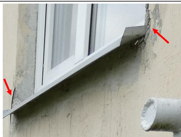
4.5.2. att. Nehermētiska savienojuma vieta starp ēkas sekcijām.
