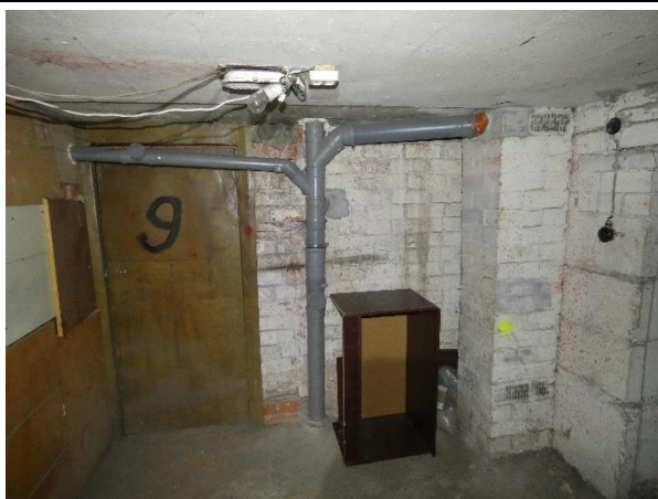
4.6.3. att. Nehermētiski inženierkomunikāciju šķērsojumi pagraba pārsegumā.
