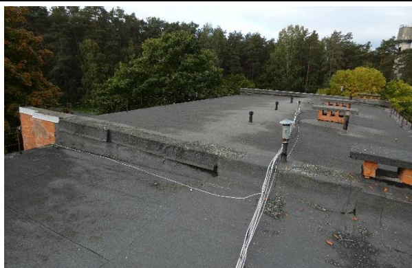
4.8.1.att. Jumta segums daļēji apmierinošā stāvoklī.
