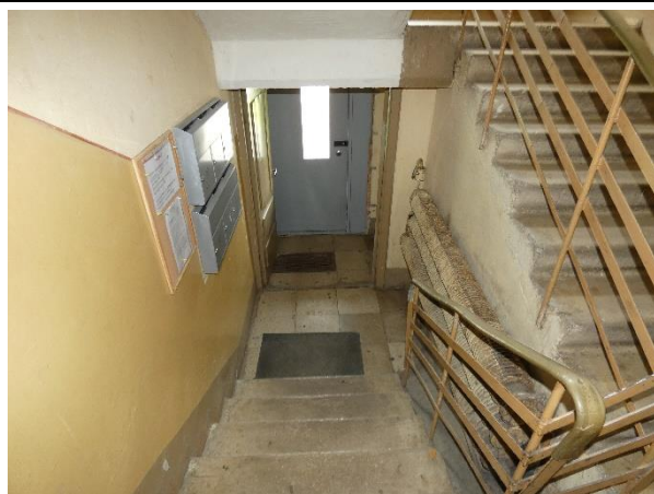
4.10.1.att. Dzelzsbetona kāpņu konstrukcijas apmierinošā stāvoklī.
