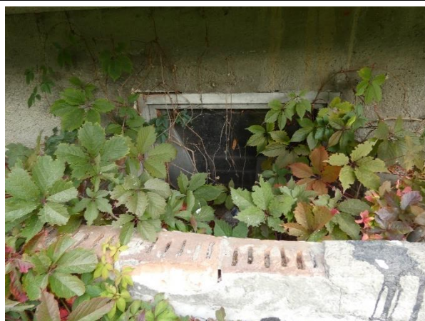
4.13.10. att. Pagraba loga aizpildījums no stikla un plēves. Logs ar vītenaugiem.
