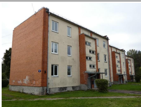
4.5.1. att. Lokāli remontētas zonas.
