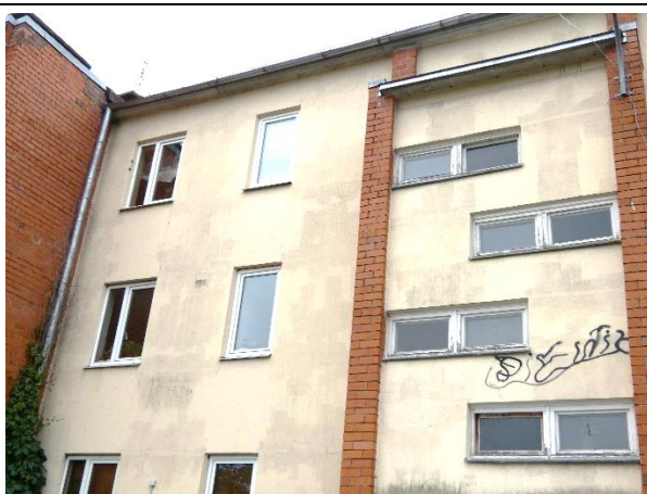
4.13.7. att. Koka logiem konstatēta būtiska aizsargkrāsojuma atslāņošanās.
