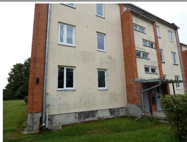
4.5.4. att. Lokāli remontētas saduršuvju vietas.
