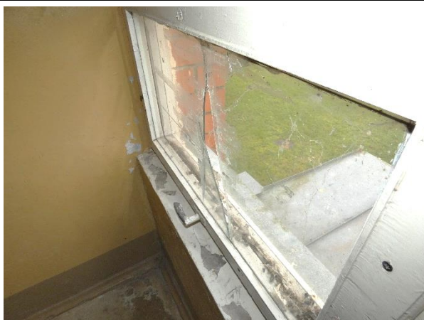
4.13.3. att. Koka logiem bojāts stiklojums.
