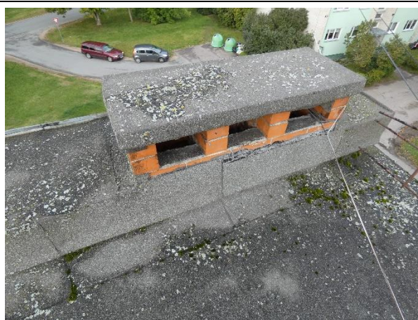
4.8.12.att. Jumta segums ar apaugumiem.
