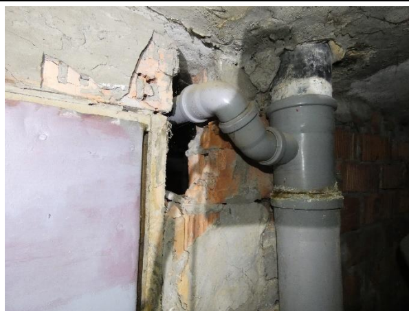
4.6.4. att. Nehermētiski inženierkomunikāciju šķērsojumi pagraba pārsegumā.
