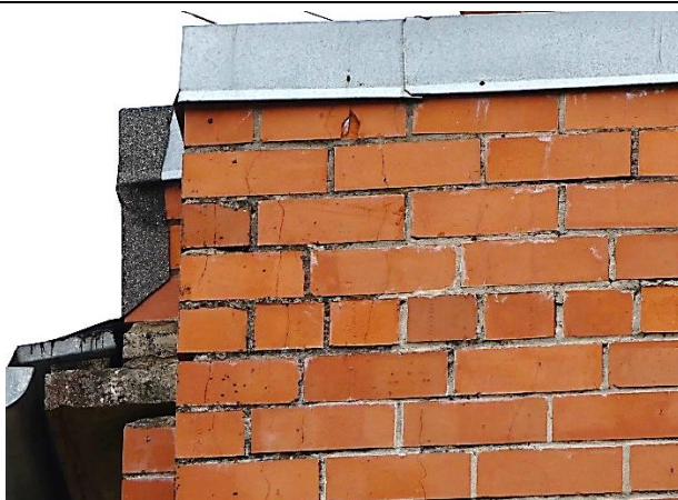
4.2.5.att. No nokrišņiem neaizsargāts gala sienas mūris. Mikroplaisas.
