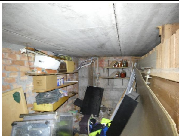
4.6.2. att. Pagraba pārseguma paneļi – apmierinošā stāvoklī.
