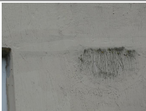
4.5.3. att. Lokāli remontētas zonas.
