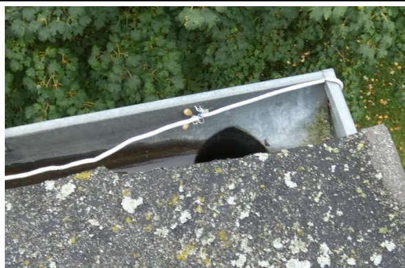
4.8.2.att. Neizolēti kabeļu savienojumi uz jumta.
