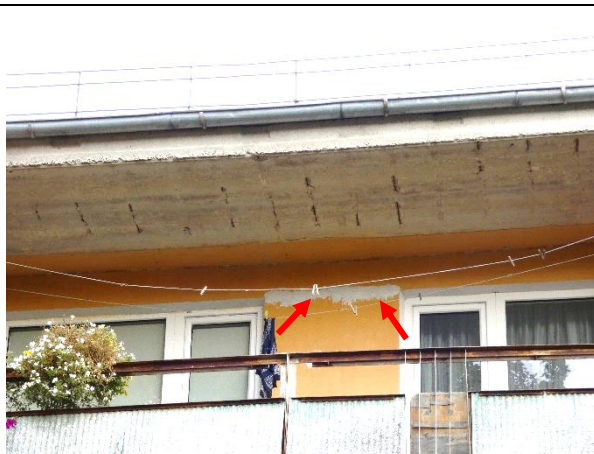
4.4.8.att. Lokāls remonts sienu paneļu sadurvietās.
