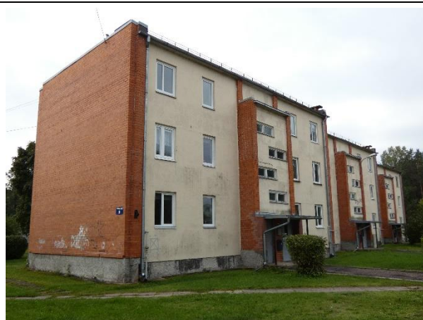
4.13.1. att. Vēsturiskie koka logi lielākoties aizstāti ar stiklapakešu logiem PVC rāmjos.
