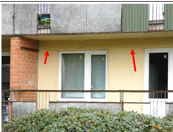
4.4.7.att. Plaisas un izdrupumi sienu paneļu sadurvietās.
