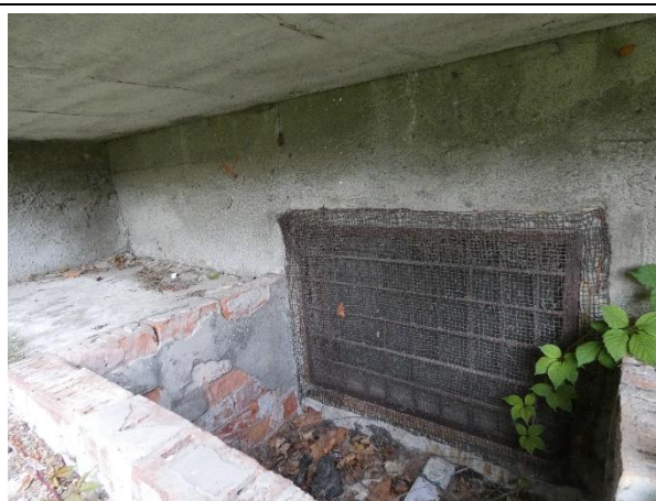
4.13.8. att. Pagraba logi aizdarīti ar dažādiem materiāliem.
