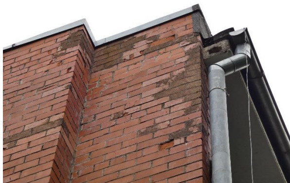
4.2.3.att. Nesošās sienas ķieģeļu bojājumi apkārtējās vides ietekmē.
