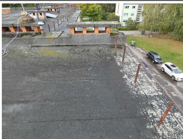
4.8.11.att. Jumta segums ar apaugumiem.
