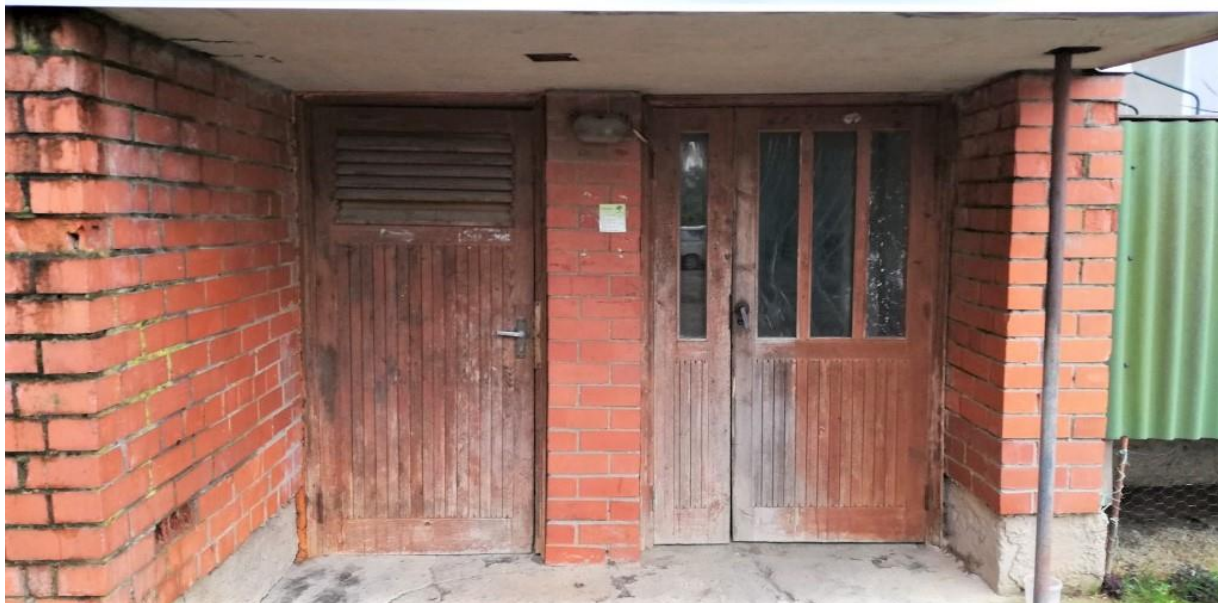
4.13.9.att. Ieejas durvis pagrabā un kāpņu telpā, ar nolietojuma pazīmēm.
