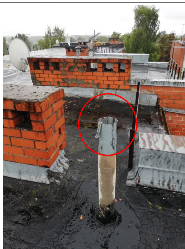
4.8.10.att. Ventilācijas izvads bez nosegelementa.
