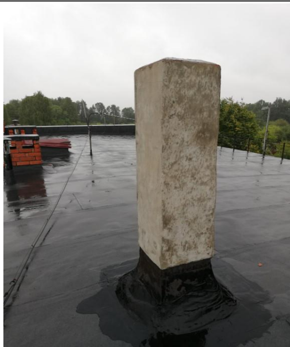
4.8.4.att. Atjaunots jumta segums un ventilācijas izvada pieslēgums.
