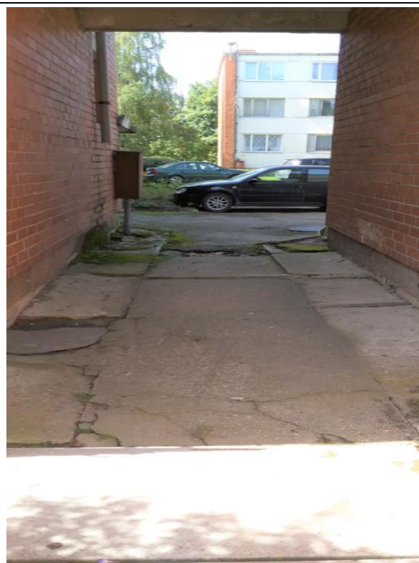
3.1.4.att. Betona plātņu un asfaltbetona segums starp ēkas sekcijām.
