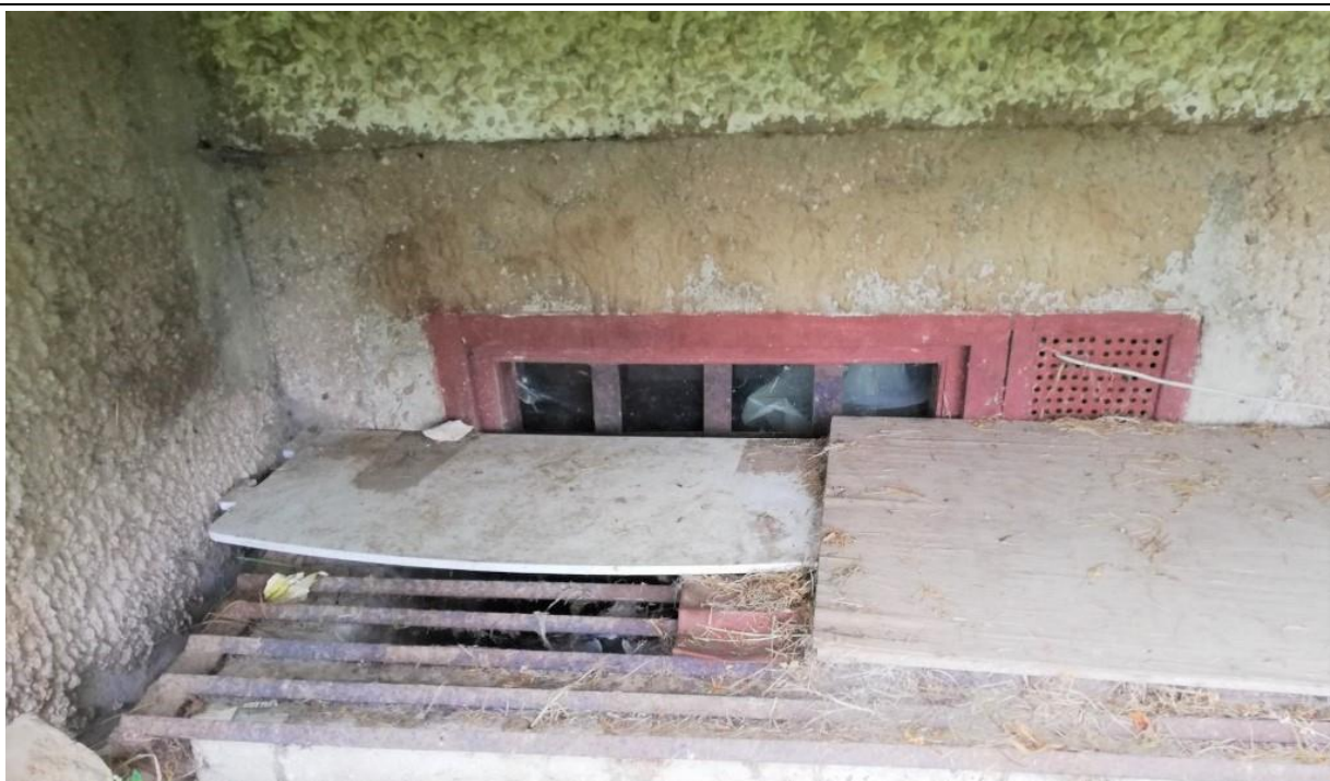
4.13.5.att. Pagraba logi koka rāmjos, ar bojātiem stikliem, nosepta pagraba logu šahta.
