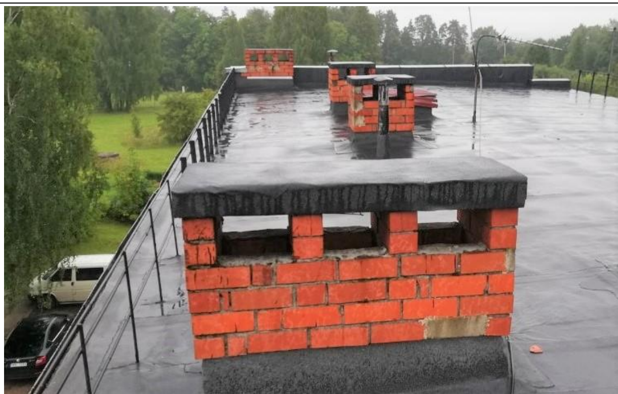
4.16.1.att. Ventilācijas šahtu izvadi uz jumta.
