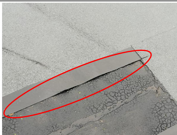
4.5.4. att. Nehermētisks jumta segums.
