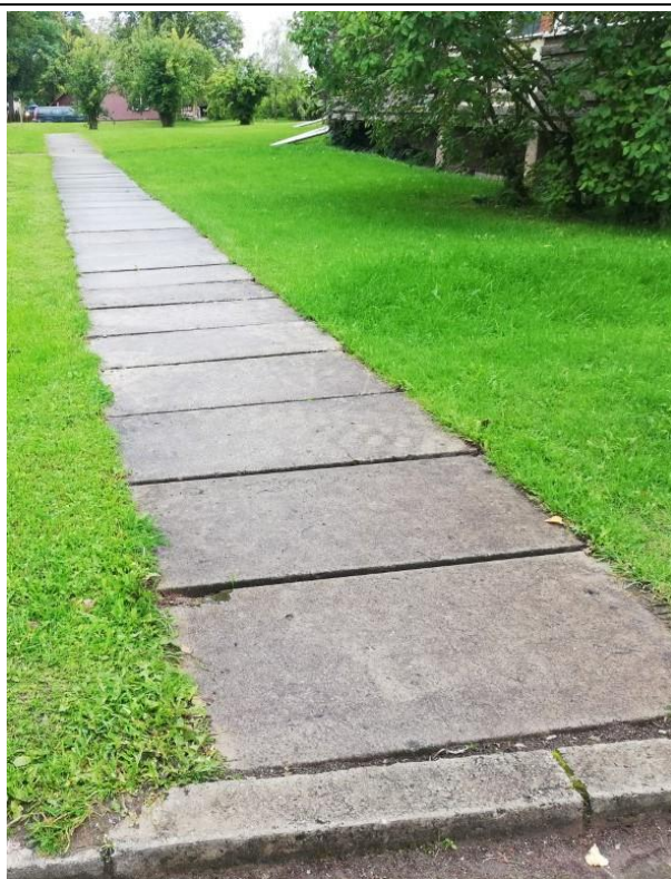
3.1.3.att. Betona plātņu gājēju ietve.
