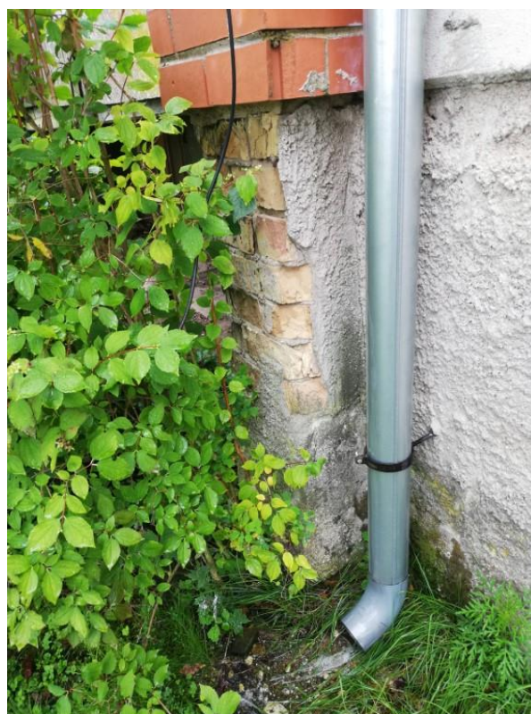
4.1.8.att. Nokrišņu ūdens netiek novadīts tālāk prom no pamatiem
