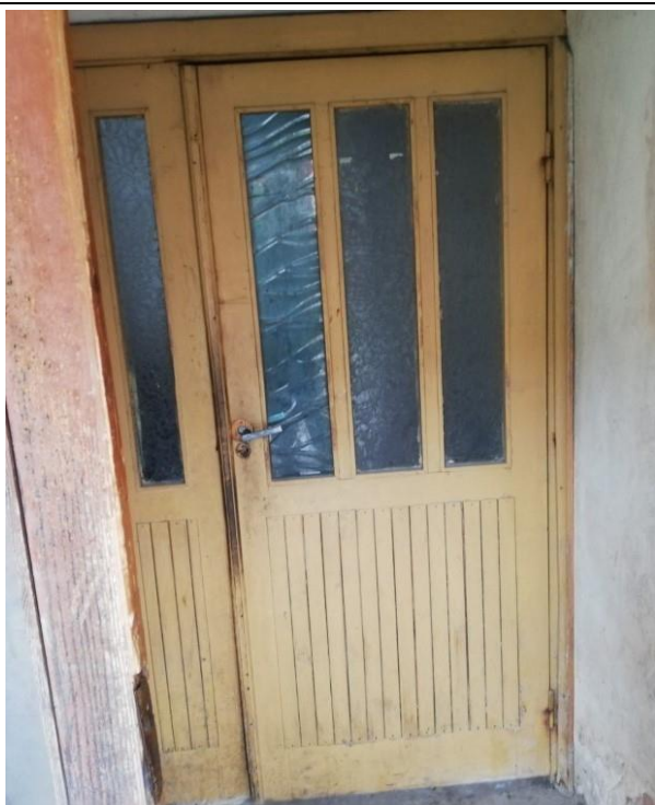
4.13.10.att. Nolietotojās koka ieejas durvis.
