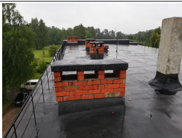
4.8.2.att. Daļā ēkas ruļļveida bitumena jumta segums ir atjaunots.
