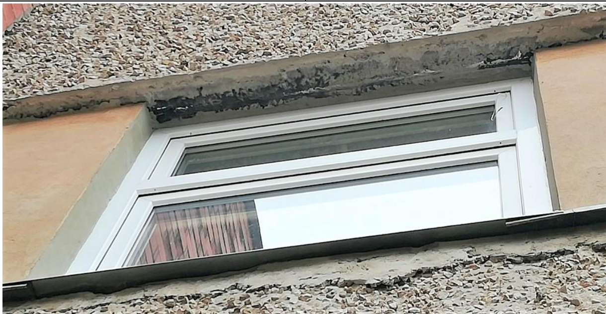
4.2.11.att. Pārsedžu funkcijas pilda ārējie keramzītbetona sienu paneļi.
