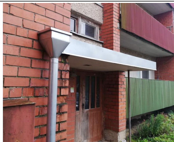
4.9.11.att. Jumtiņu plātnes mala aizsargāta pret nokrišņiem – lietus ūdens noteka ir atjaunota.
