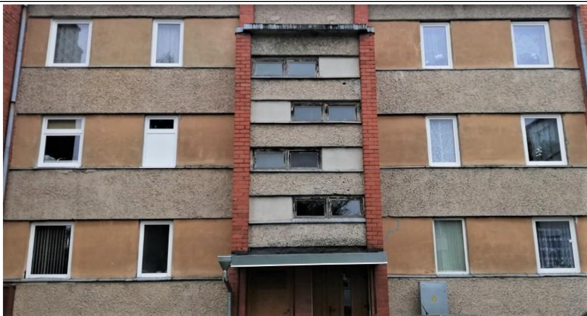
4.13.1.att. Kāpņu telpā logi koka rāmjos, dzīvokļos PVC rāmjos.
