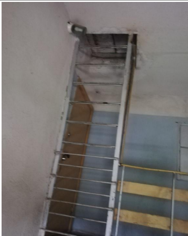
4.10.6.att. Metāla kāpnes nokļūšanai uz jumta.
