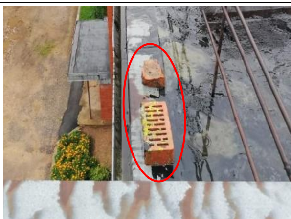
4.8.6.att. Uz jumta atrodas priekšmeti, kas var krītot apdraudēt garāmgājējus.
