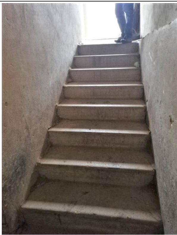
4.10.5.att. Betona kāpnes nokļūšanai pagrabā.
