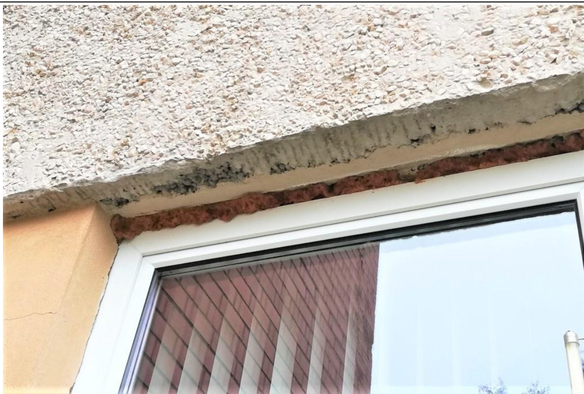
4.13.3.att. Nav veikta spraugu aizdare ar hermetizējošiem materiāliem.
