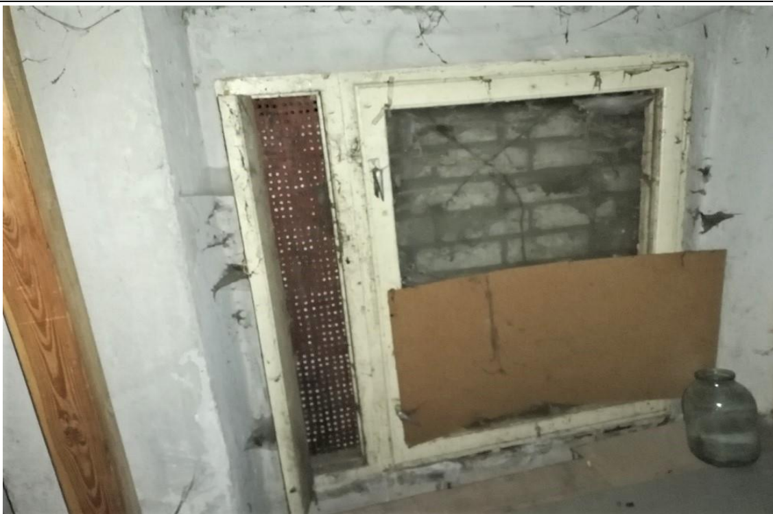
4.13.6.att. Pagrabstāvā koka logi ir aizmūrēti no ārpuses.
