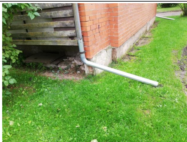
4.8.17.att. Pagarināts notekas posms, daļēji novērsta ūdens tieša ietekme uz ēkas ārsienu, pamatiem, konstrukcijām.
