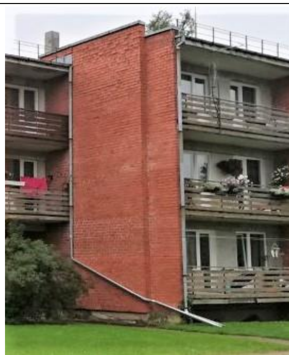
4.8.15.att. Pagarināts notekas posms, ir daļēji novērsta ūdens tieša ietekme uz ēkas ārsienu, pamatiem.
