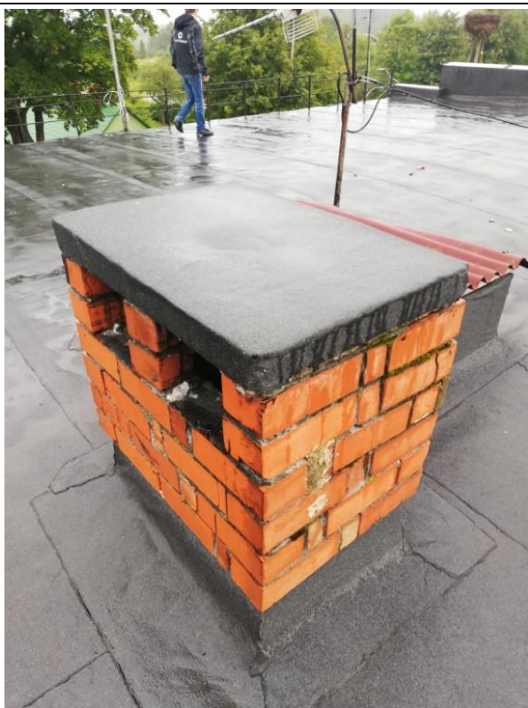
4.16.4.att. Atjaunots ventilācijas izvada jumts.
