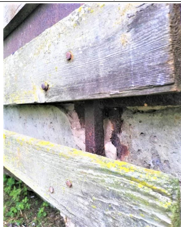
4.9.3.att. 4.9.4.att. Lodžiju norobežojošās metāla margas un to stiprinājumi ar vērojamu koroziju.
