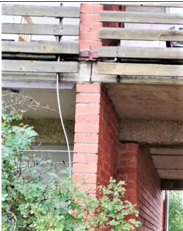
4.9.3.att. 4.9.4.att. Lodžiju norobežojošās metāla margas un to stiprinājumi ar vērojamu koroziju.
