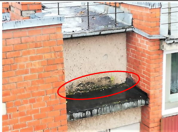
4.5.2. att. Mitruma koncentrācija jumta seguma un sienas savienojuma vietā.
