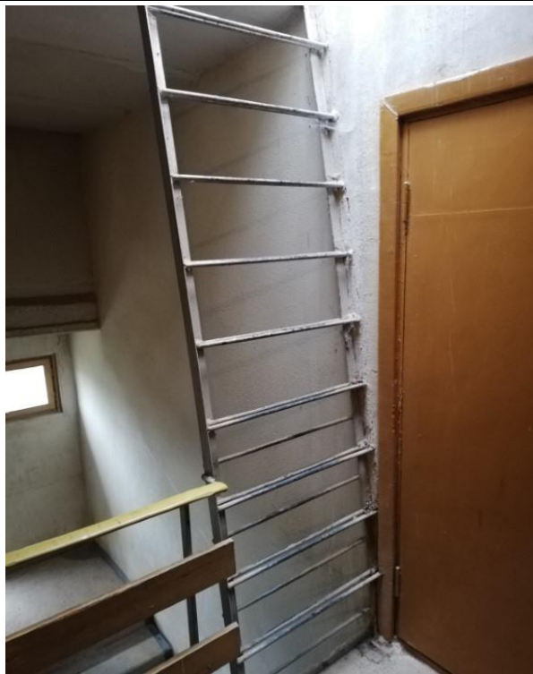
4.10.7.att. Metāla kāpnes nokļūšanai uz jumta.
