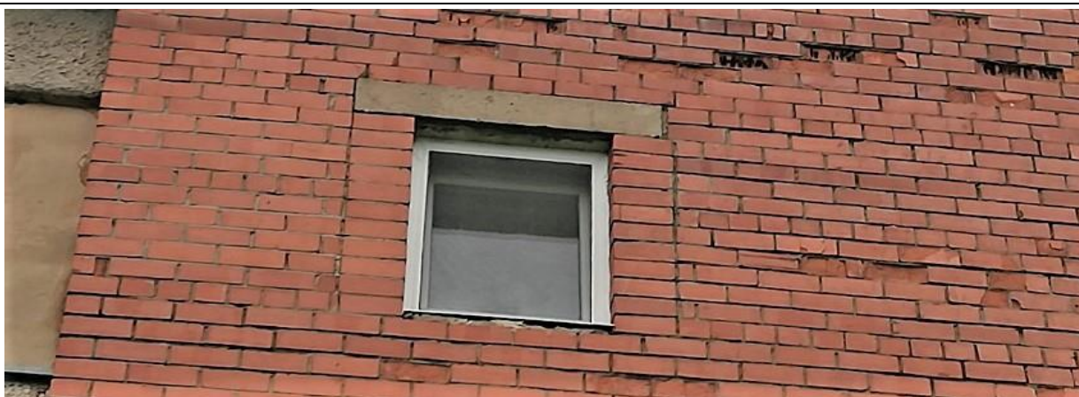
4.2.12.att. Nesošajās ārējās sienās pārsedzes ir ierīkotas no dzelzsbetona. Ailu pārsedzes un to balstvietas bez bojājumiem, apmierinošā stāvoklī.
