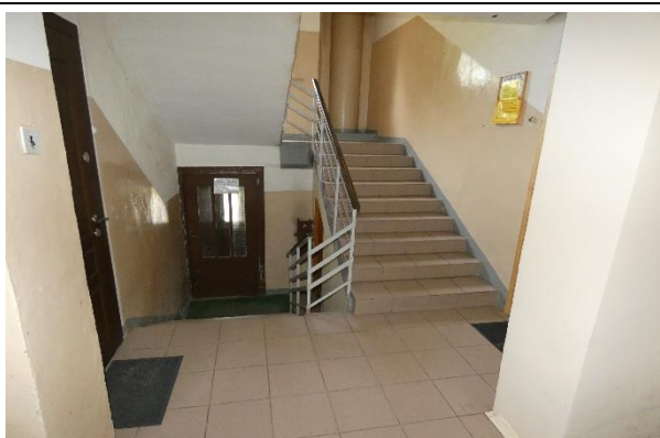
4.10.5.att. Kāpņu dzelzsbetona konstrukcijas apmierinošā stāvoklī. Laukumi un laidumi – flīzēti.
