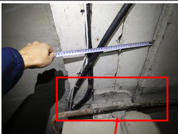
4.2.13.att. Bojāta/neatbilstoši izpildīta ailas pārsedzes balstvieta.
