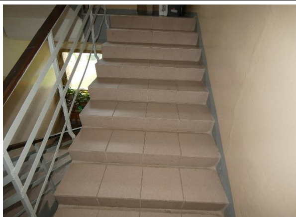
4.10.2.att. Kāpņu dzelzsbetona konstrukcijas apmierinošā stāvoklī. Laukumi un laidumi – flīzēti.
