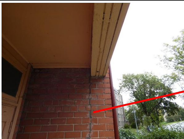
4.2.9.att. Plaisa nesošajā sienā pirmā stāva līmenī.
