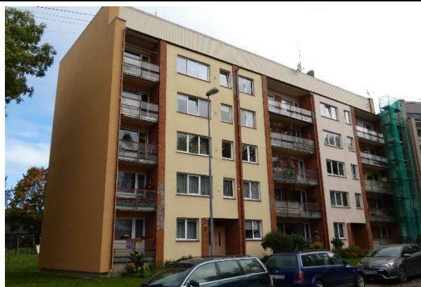
4.13.1. att. Vēsturiskie koka logi lielākoties aizstāti ar stiklapakešu logiem PVC rāmjos.
