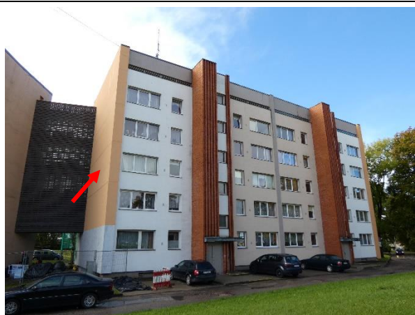
4.2.4.att. Nesošās gala sienas siltinātas – vizuāli labā stāvoklī.
