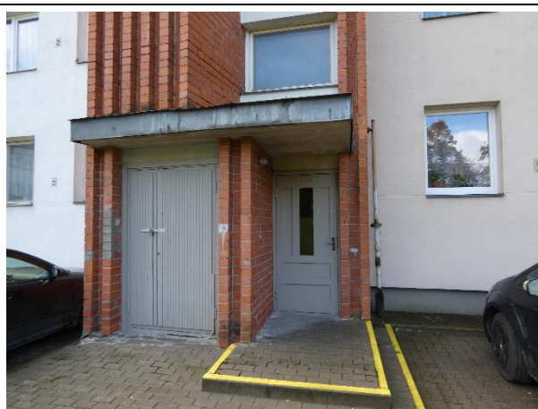
4.9.3.att. Ieejas lieveņi veidoti no bruģakmens - atjaunoti
