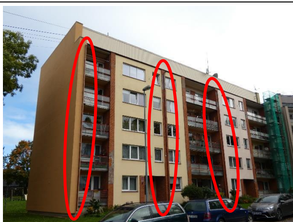
4.8.25.att. Ārējā lietussūdens novadsistēma. Teknes un notekas apmierinošā stāvoklī.
