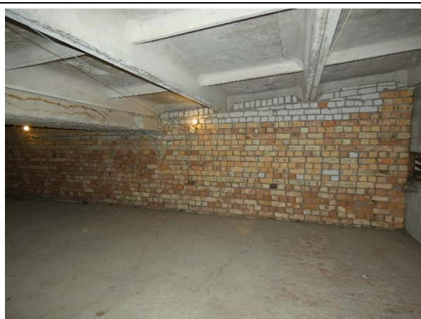
4.2.12.att. Nesošās šķērssienas bēniņos bez būtiskām plaisām.
