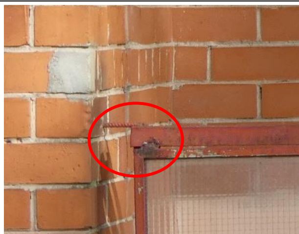
4.9.14.att. Lodžiju norobežojošo elementu stiprinājumi un metinājumu savienojumu vietas ar koroziju.
