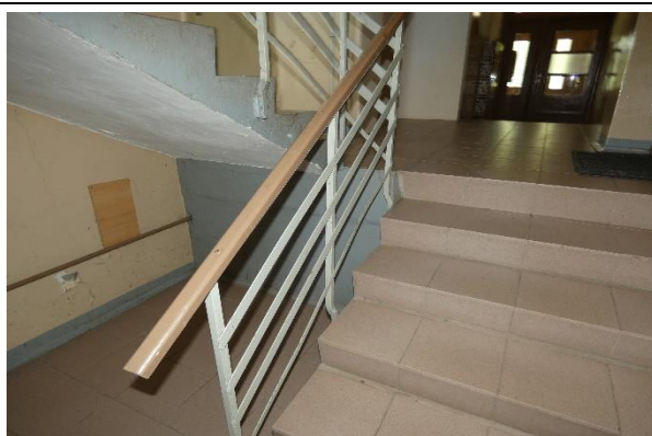
4.10.6.att. Kāpņu dzelzsbetona konstrukcijas apmierinošā stāvoklī. Laukumi un laidumi – flīzēti.
