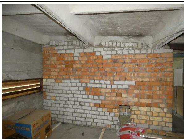
4.2.11.att. Nesošās šķērssienas bēniņos bez būtiskām plaisām.
