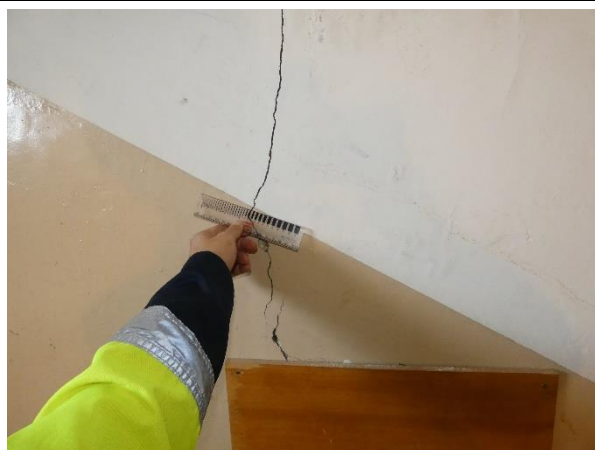
4.2.8.att. Plaisas platums kāpņu telpas sienā 2,0 mm.
