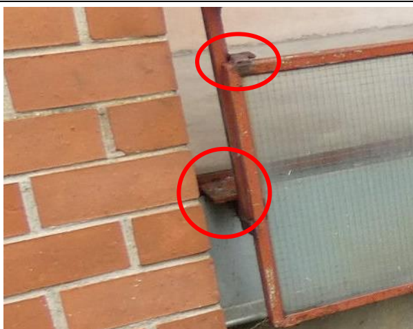
4.9.13.att. Lodžiju norobežojošo elementu stiprinājumi un metinājumu savienojumu vietas ar koroziju.
