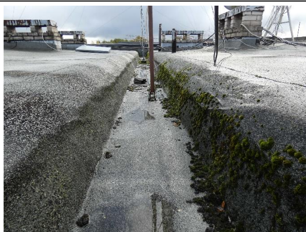
4.8.16.att. Jumta segums ar apaugumiem.
