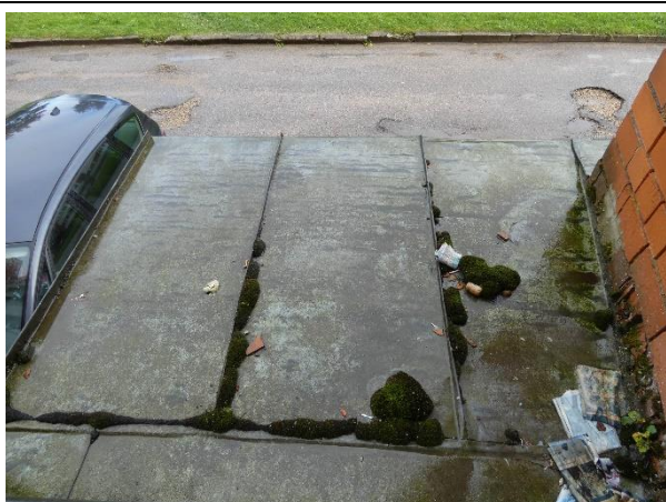
4.9.5.att. Jumtiņu segums ar apaugumiem, gružiem.
