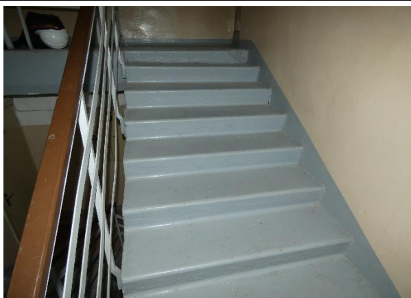
4.10.1.att. Kāpņu dzelzsbetona konstrukcijas apmierinošā stāvoklī.
