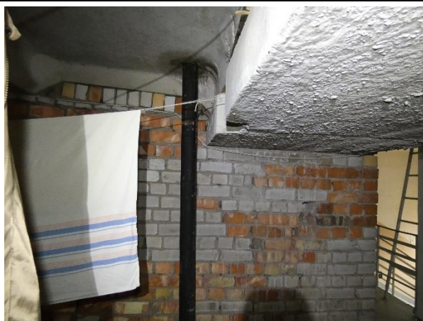
4.8.1.att. Jumta nesošais elements dzelzsbetona tekne, apmierinošā stāvoklī.
