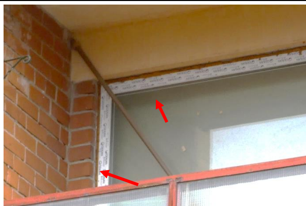
4.13.2. att. Nav veidota atbilstoša logailas apdare pēc montāžas.
