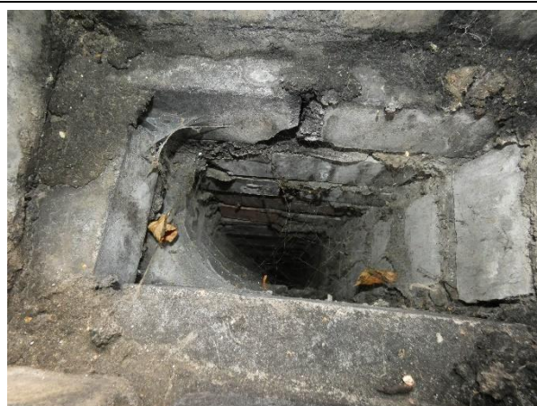
4.16.4.att. Vēdināšanas kanāli ar putekļiem un zirnekļu tīkliem. Nepieciešama tīrīšana.
