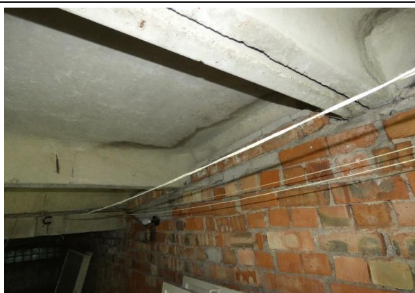
4.8.5.att. Mitruma pazīmes, balsta vietas bez slodzi pārdalošas dzelzsbetona joslas.
