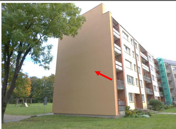
4.2.3.att. Nesošās gala sienas siltinātas – vizuāli labā stāvoklī.
