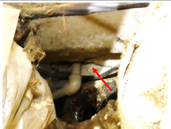
4.6.4. Att. Nav hermetizēta inženiertīklu šķērsojumu vieta.
