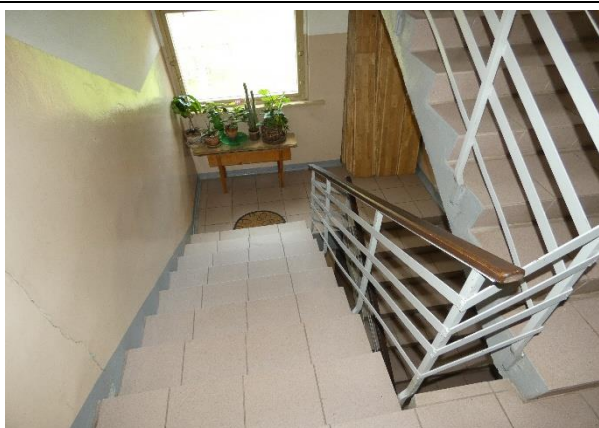
4.10.3.att. Kāpņu dzelzsbetona konstrukcijas apmierinošā stāvoklī. Laukumi un laidumi – flīzēti.
