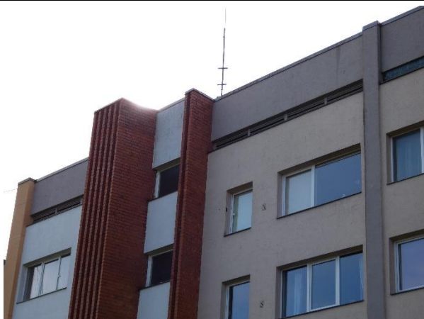
4.13.11. att. Tehniskā stāva līmenī stiklabloku vai vēdināšanas žalūziju ailu aizpildījums – apmierinošā stāvoklī.
