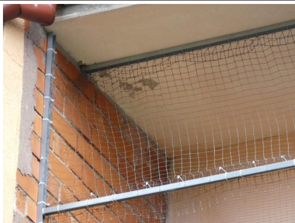
4.13.12. att. Lodžijai konstatēts uzstādīts metāla rāmis, kas nosepts ar sietu.
