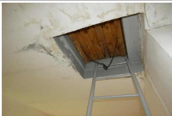
4.13.16. att. Konstatēts nehermētiskums
