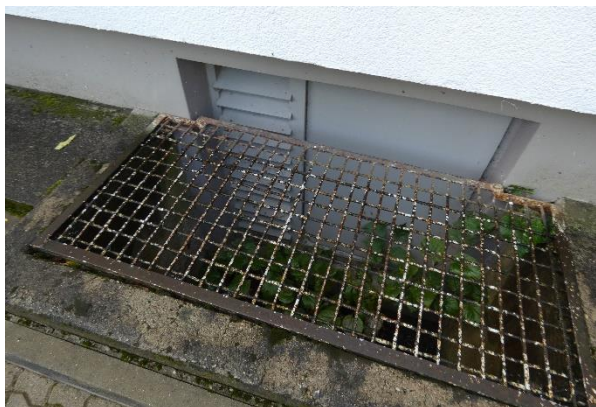
4.13.3. att. Pagraba logi lielākoties aizdarīti, atstājot vēdināšanas atveres.
