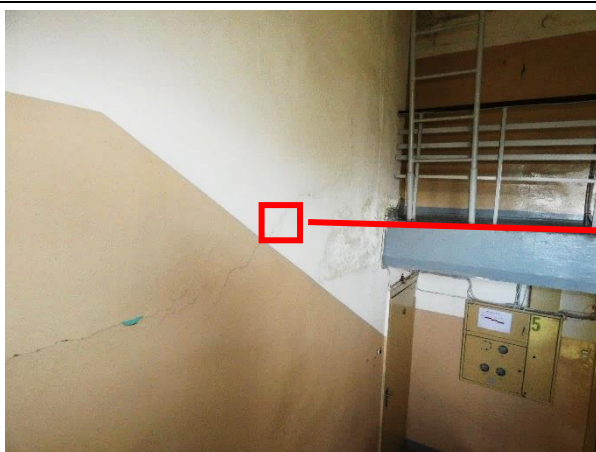
4.2.5.att. Plaisas kāpņu telpu nesošajās šķērssienu.
