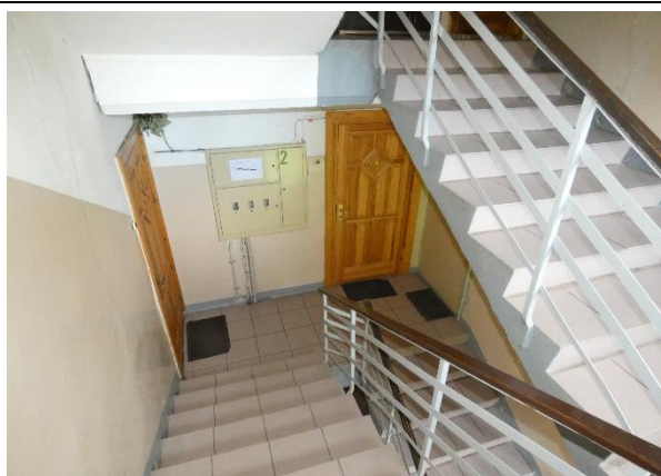
4.10.4.att. Kāpņu dzelzsbetona konstrukcijas apmierinošā stāvoklī. Laukumi un laidumi – flīzēti.
