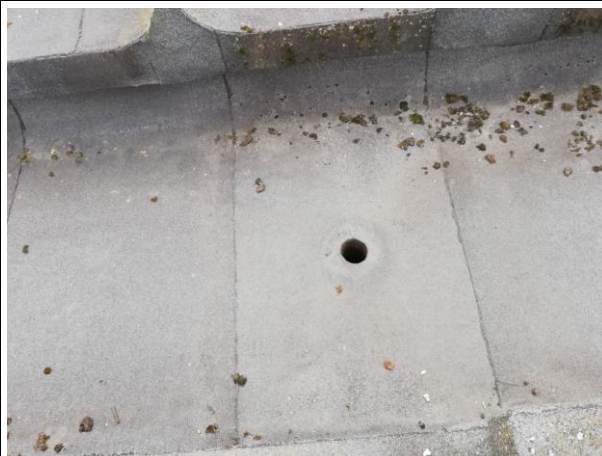
4.8.2.8.att. Lietus ūdens novadīšanas piltuvei nav aizsargelements.
