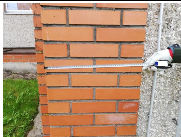
4.2.5.att. Ēkas sekcijas gala sienas pilastrs 640 mm biezumā.
