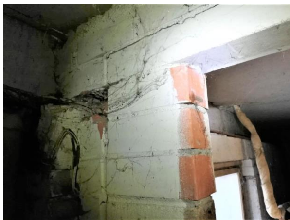
4.2.15.att. Dzelzsbetona gatvelementa pārsedzes balsta vieta pagrabā.
