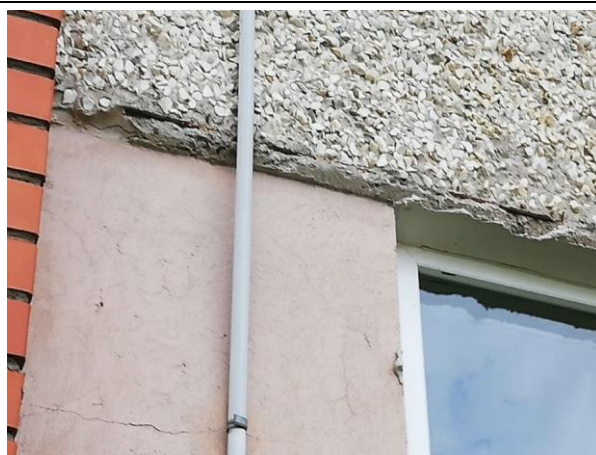
4.4.2.att. Lokāli izdrupumi un atsegts stiegrojums ārsienu paneļos, plaisas apmetumā gāzbetona starplogu aizmūrējumā.
