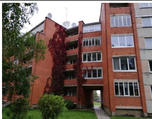
4.9.4.att. Lodžijām veikts iestiklojums koka vai PVC rāmjos.
