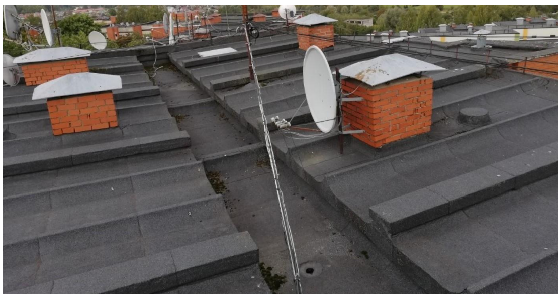
4.8.1.att. Ēkai izbūvēta dzelzsbetona gatavelementu jumta konstrukcija ar iekšējo lietus ūdens novadīšanas sistēmu.
