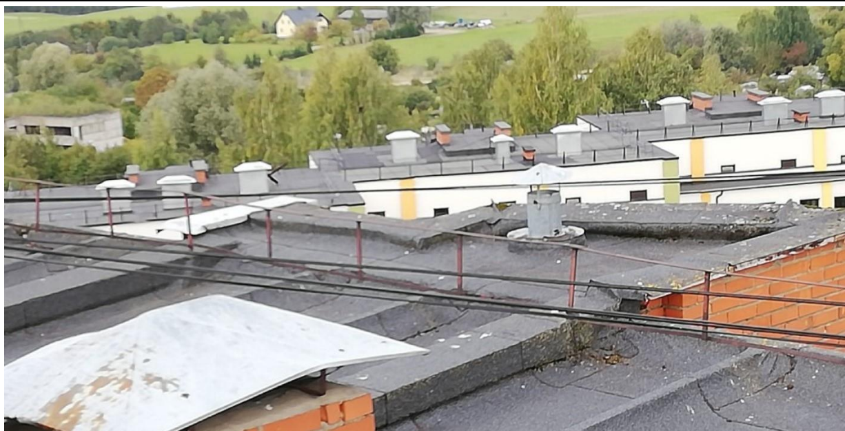
4.8.2.1.att. Jumta segums apmierinošā tehniskajā stāvoklī.
