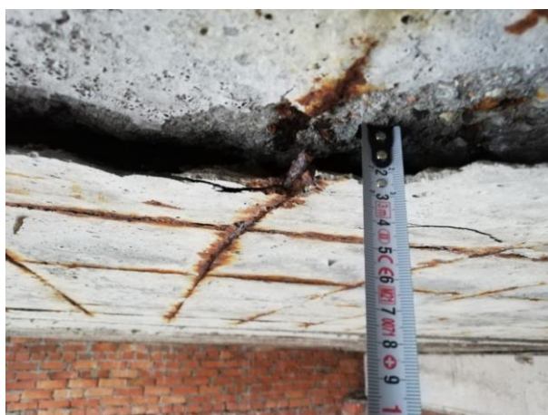
4.8.6., 4.8.7.att. Jumta klāja ribotām dzelzsbetona plātnēm atslāņojies betons un korodējis stiegrojums.
