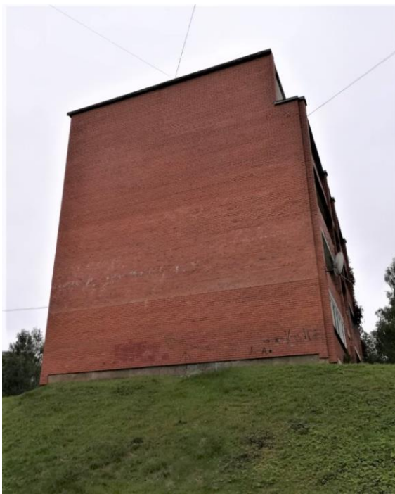
1.1. att. Apsekotā ēka, rietumu fasāde.
