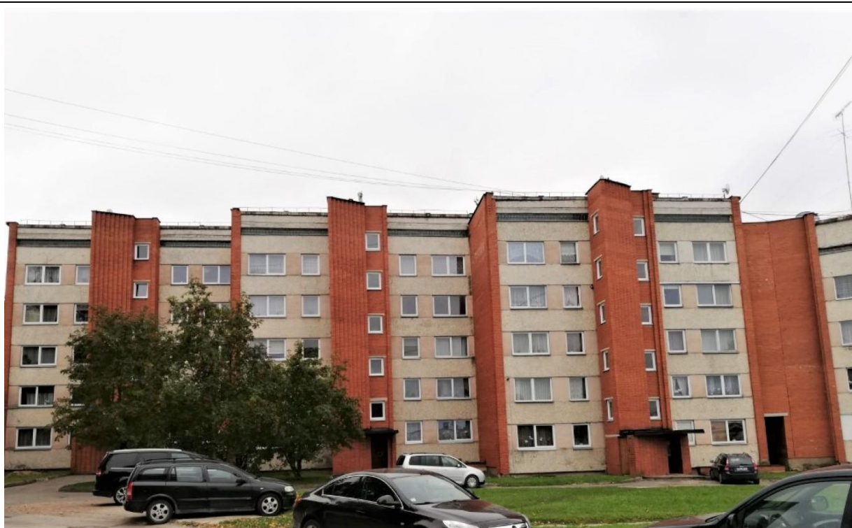
1.4. att. Apsekotā ēka, ziemeļu fasāde.
