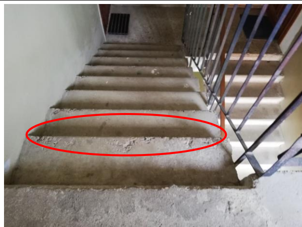
4.10.1.att. Dzelzsbetona gatavelementu laidumi, Izdrupumi pakāpienos.
