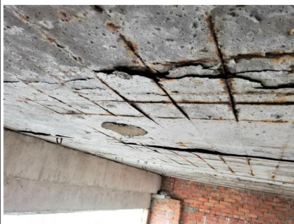
4.8.6., 4.8.7.att. Jumta klāja ribotām dzelzsbetona plātnēm atslāņojies betons un korodējis stiegrojums.
