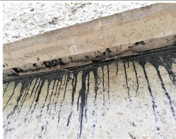
4.5.1. attēls. Horizontālā hidroizolācija – ruberoīds 2-3 kārtās uz bituma mastikas.
