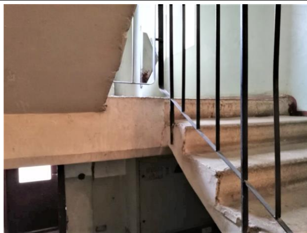
4.10.2.att. Kāpņu laidumi balstās uz kāpņu laukumiem.
