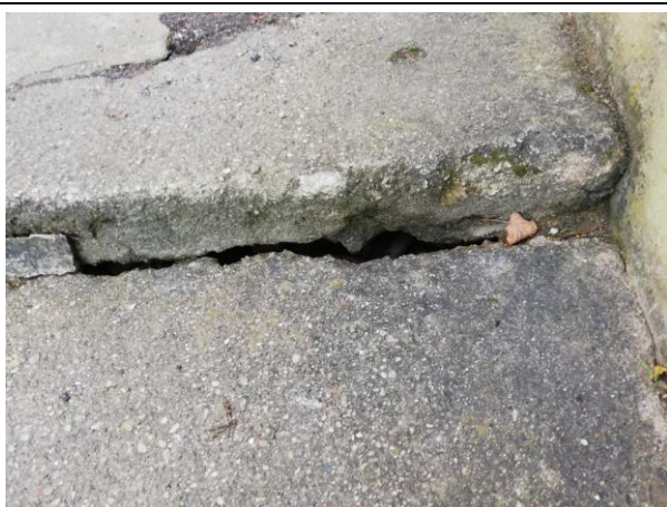
3.3.4.att. Izskalota pamatne ārējo kāpņu laukumam ēkas ziemeļu pusē.
