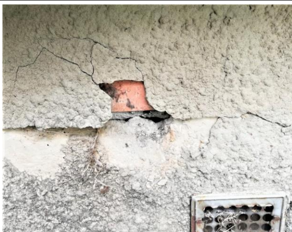
4.5.1. attēls. Horizontālā hidroizolācija – ruberoīds 2-3 kārtās uz bituma mastikas.
