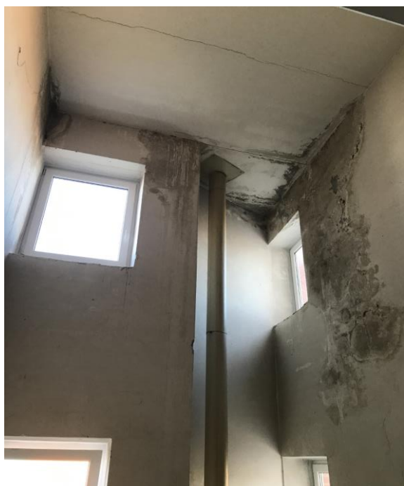
4.10.5.1.att. 5.stāvā ūdens caurtece novērsta
