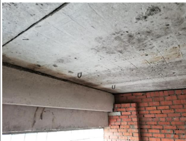
4.8.4.att. Dzelzsbetona rīgelis balstīts uz šķērssienu.
