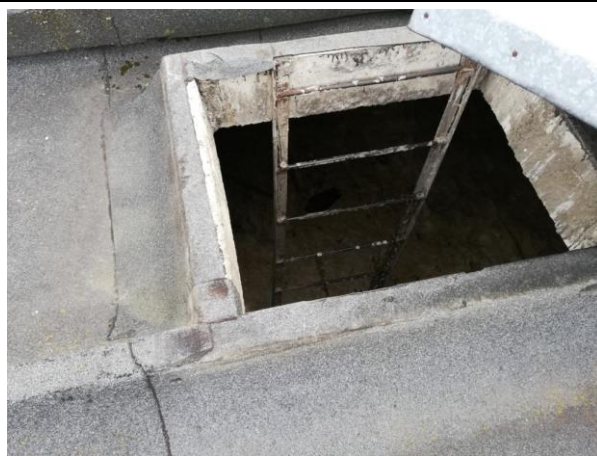
4.10.4.att. Sekcijā izbūvētas metāla kāpnes nokļūšanai uz jumta.
