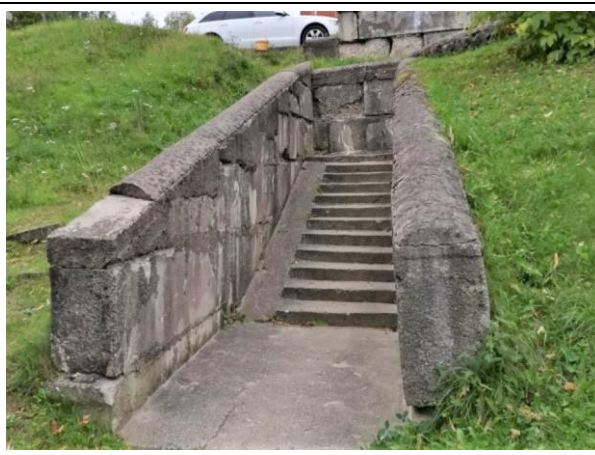
3.3.5.att. Ārējās kāpnes ēkas austrumu pusē.
