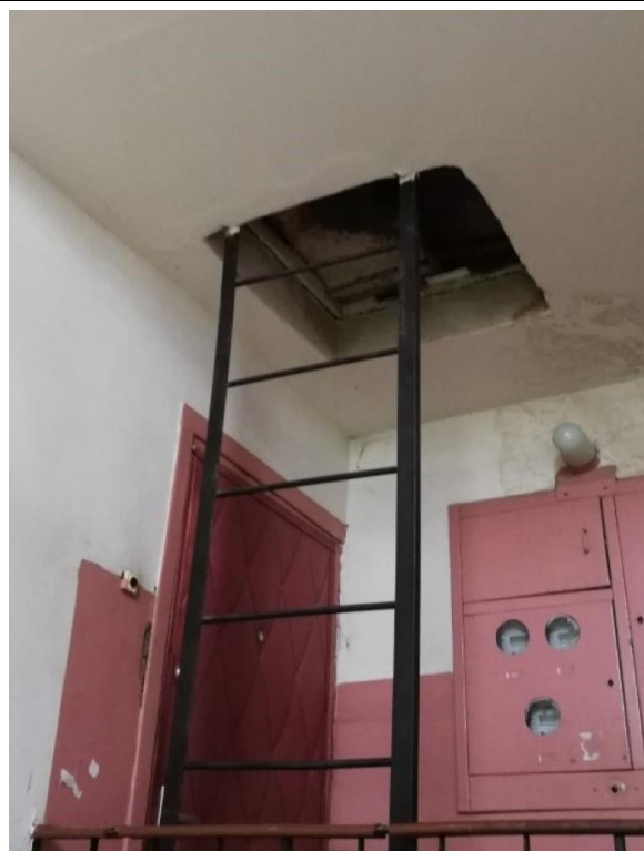
4.10.6.att. Metāla kāpnes nokļūšanai bēniņu stāvā un uz jumta.
