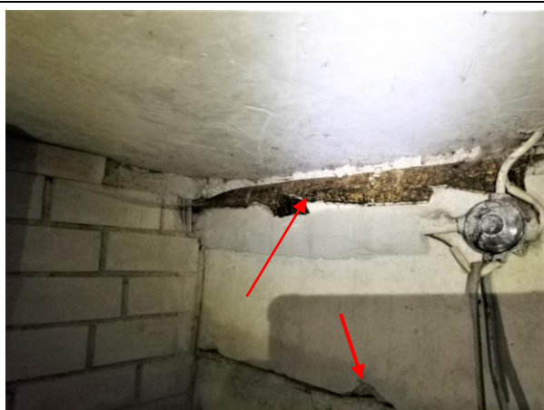
4.1.1.att. Ēkas pagrabstāva ārsienas izbūvētas no dzelzsbetona pamatu blokiem ar redzamu horizontālo hidroizolāciju un izdrupumiem.
