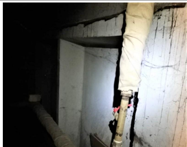
4.2.3.att. Cokola paneļu pagraba ārējās garensienas labā stāvoklī.
