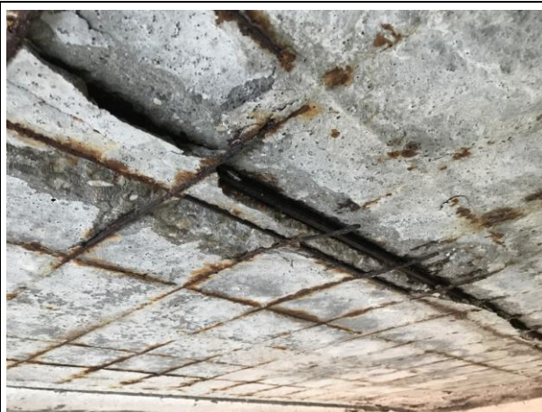
4.8.9.att. Stiegrojuma atsegums, sk. 4.8.8.att.
