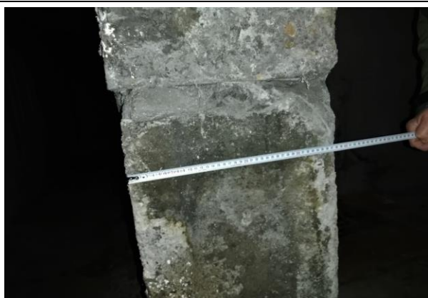
4.1.3.att. Ēkas pagrabstāva starpsiena izbūvēta no dzelzsbetona pamatu blokiem 400mm biezumā.
