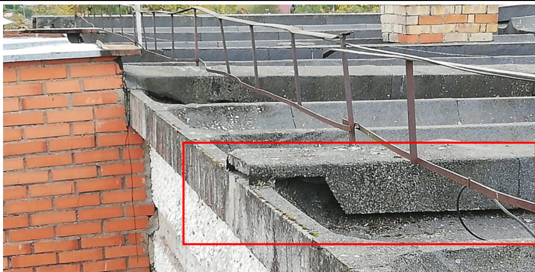
4.8.5.att. Savienojumi starp jumta plātnēm nosegti ar U-veida dzelzsbetona elementiem.
