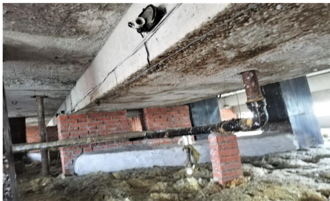
4.8.2.att. Dzelzsbetona tekne 1500 mm platumā.
