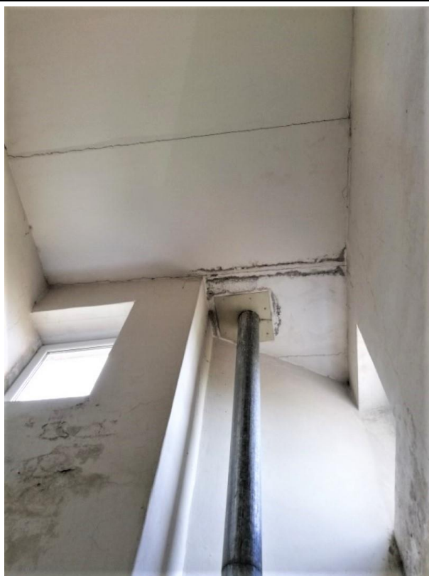
4.8.11.att., 4.8.12.att. Kāpņu telpas savietotā jumta dzelzsbetona pārseguma paneļi un siena ir bojāti mitruma ietekmē.
