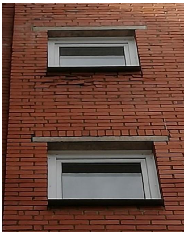
4.2.13.att. Dzelzsbetona gatavelementu pārsedzes kāpņu telpā.
