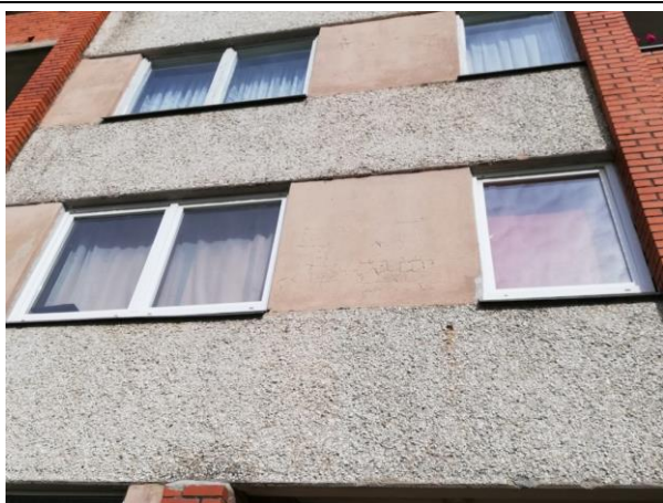
4.4.1.att. Ārsienu keramzītbetona paneļi un starplogu ailu aizpildījums-no gāzbetona bloku aizmūrējums.
