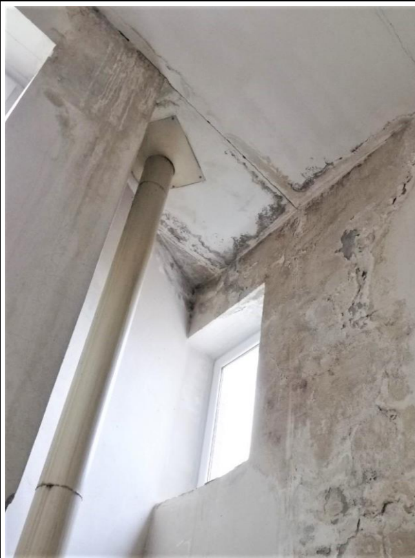
4.8.11.att., 4.8.12.att. Kāpņu telpas savietotā jumta dzelzsbetona pārseguma paneļi un siena ir bojāti mitruma ietekmē.
