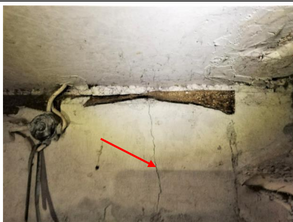
4.1.2.att. Nebūtiska plaisas pagrabstāva dzelzsbetona bloku ārsienas apmetumā.
