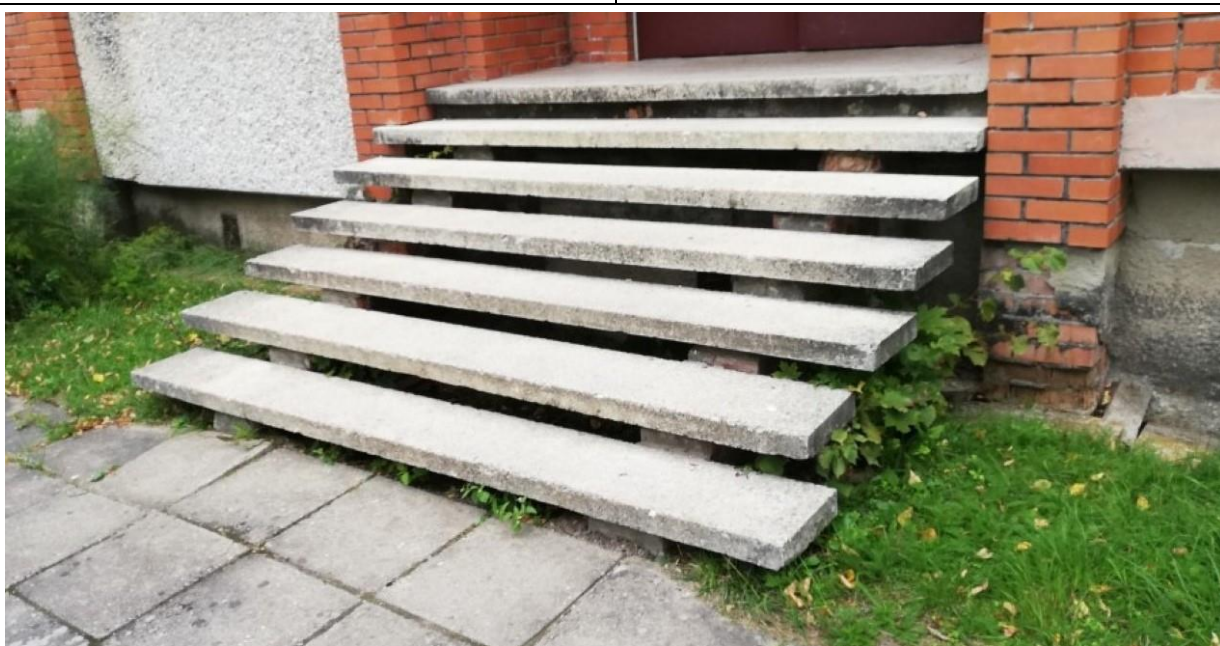
4.10.7.att. Āra kāpnes ar dzelzsbetona pakāpieniem un laidiem ēkas dienvidu pusē.
