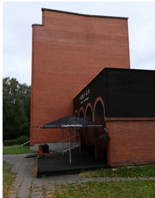
1.2. att. Apsekotā ēka, austrumu fasāde.
