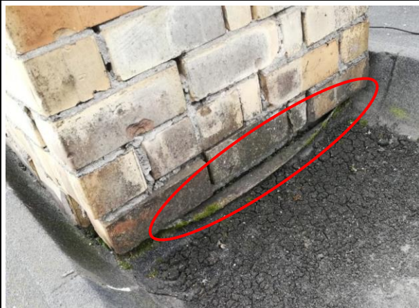
4.8.2.7.att. Nehermētisks jumta seguma pieslēgums ventilācijas šahtai.
