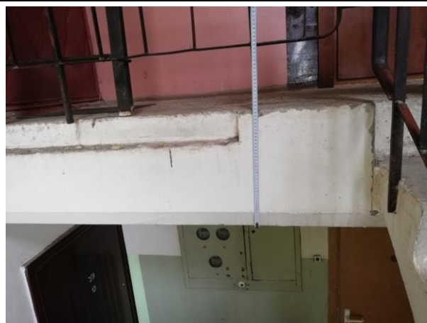
4.10.3.att. Kāpņu laukums 400mm biezumā balstās uz mūra šķērсноšajām sienām.
