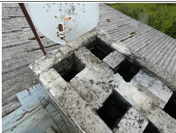
4.8.21.att. Vēdināšanas izvadi bez skārda jumtiņiem.
