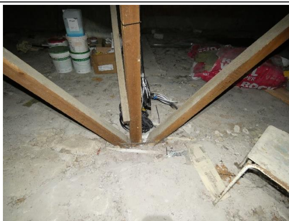
4.8.12.att. Jumta nesošo konstrukciju balstmezgls apmierinošā stāvoklī.
