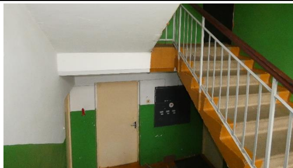
4.10.2.att. Kāpņu dzelzsbetona konstrukcijas apmierinošā stāvoklī.
