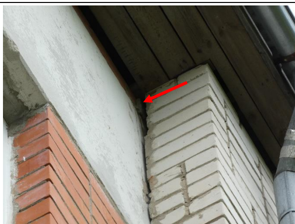
4.2.3.att. Šķērssienu pilastru daļas nav noenkurotas ārsinās bēniņu līmenī.
