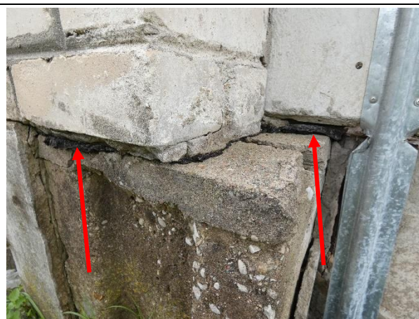
4.5.4. att. Horizontālā hidroizolācija virs cokola.
