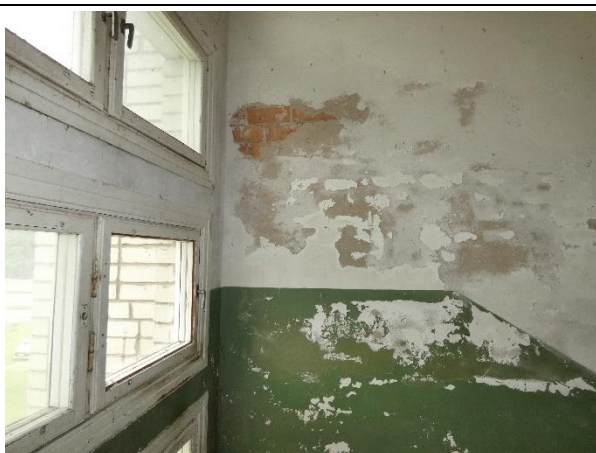
4.13.7. att. Koka logiem iztrūkst viena stiklojuma kārtā.
