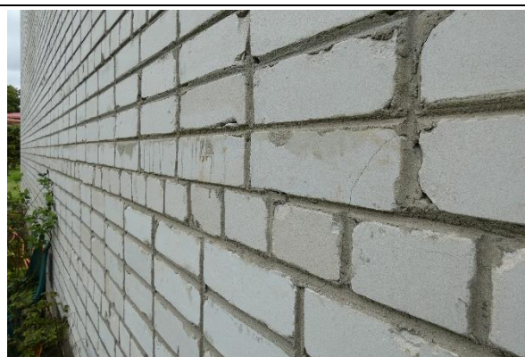
4.2.2.att. Konstatēti maznozīmīgi ķieģeļu izdrupumi, plaisas un lokālas remonta zonas.
