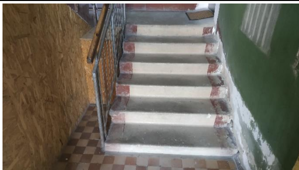
4.10.1.att. Kāpņu dzelzsbetona konstrukcijas apmierinošā stāvoklī.
