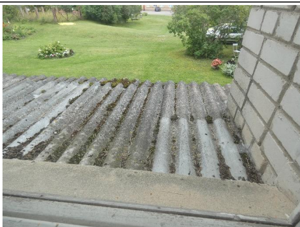
4.9.3.att. Gruži uz ieejas mezgla jumtiņa. Azbestcements lokšņu segums.
