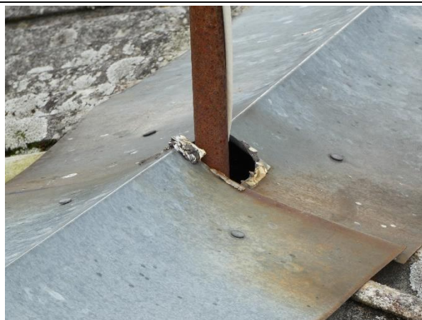
4.8.20.att. Nehermētiski skārda elementa pieslēgumi.
