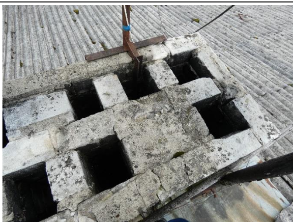
4.16.1.att. Mūrēto ventilācijas šahtu izvadi virs jumta līmeņa.
