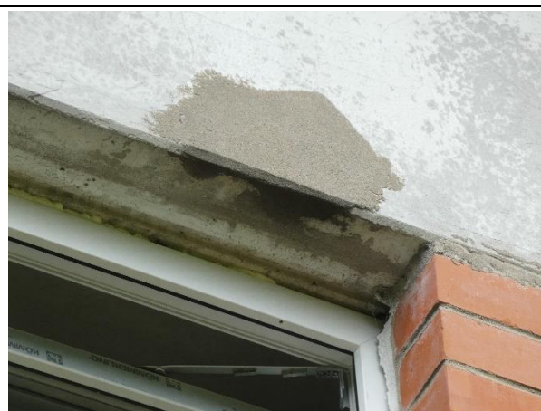
4.5.6. att. Nav veikta atbilstoša sadurvietas hermetizācija starp logu un logailu.
