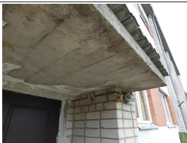
4.9.2.att. Jumtiņa plātne virs ieejas mezglā daļēji apmierinošā stāvoklī.
