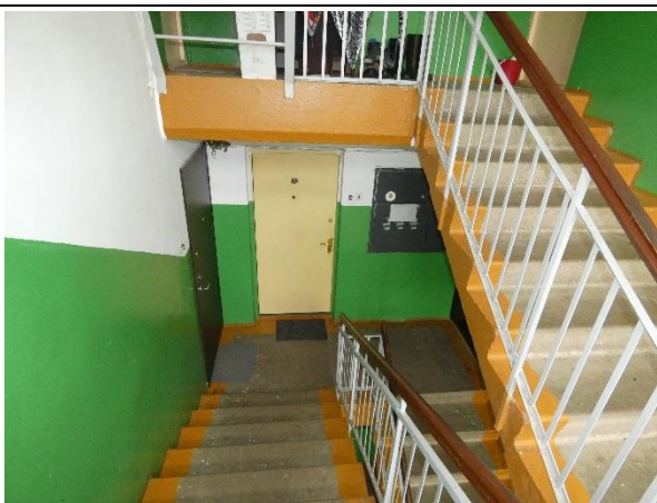
4.10.4.att. Kāpņu laukuma un laiduma balsta vietas – apmierinošā stāvoklī.
