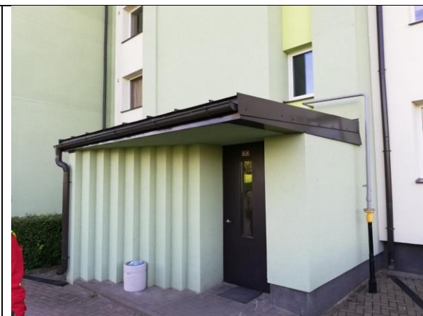
4.9.4.att. Jumtiņa elementi balstās uz vējtvera šķērssienām.
