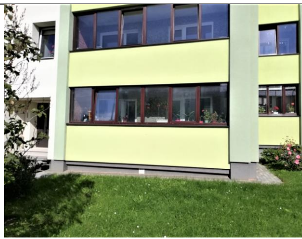
4.12.8.att. Lodžijas visai ēkai aizstiklotas ar PVC rāmju logiem.
