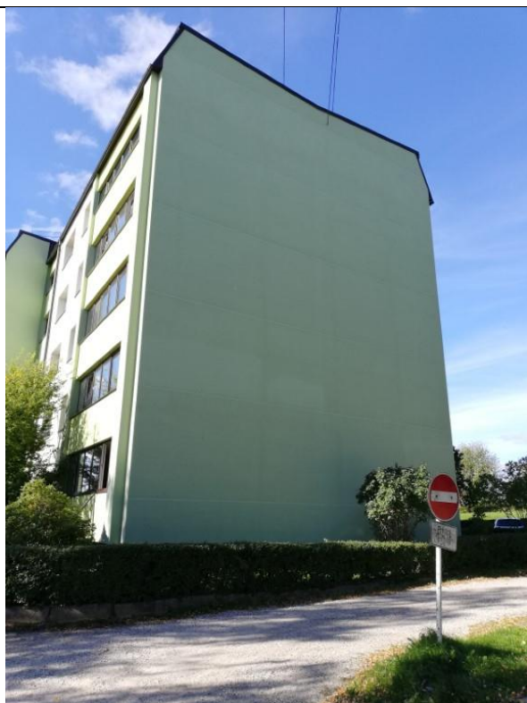
1.1. att. Apsekotā ēka, A fasāde.
