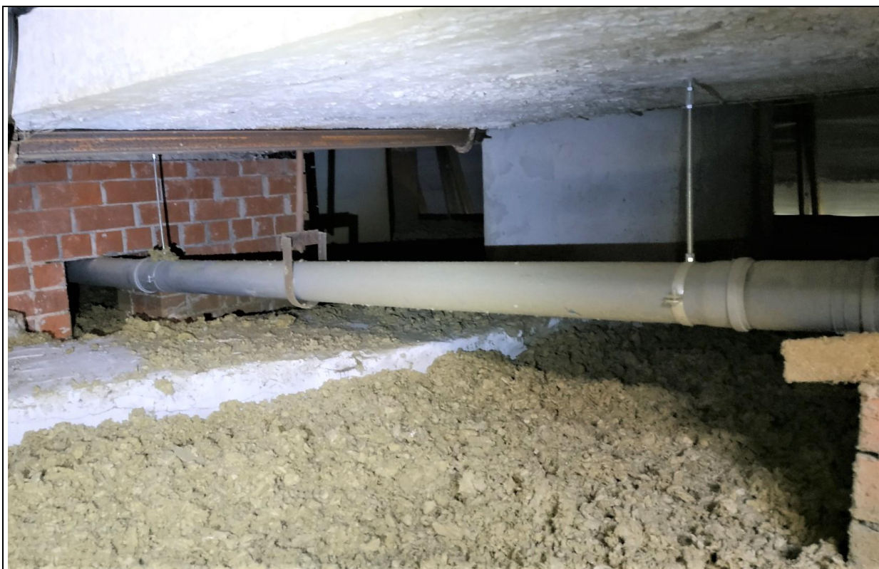
4.8.22.att. Lietus ūdens kanalizācijas guļvads bēniņos.
