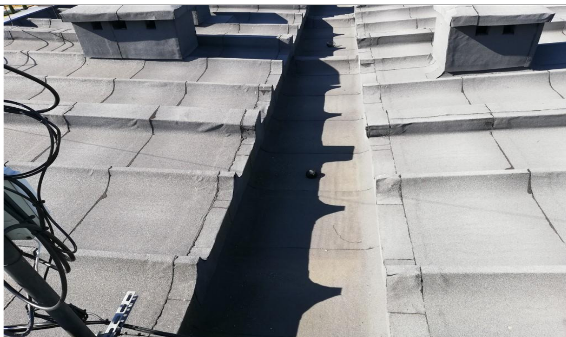
4.8.15.att. Hidroizolēta dzelzsbetona gatavelementu jumta tekne.
