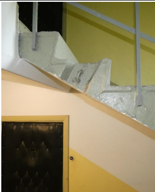
4.10.3.att. Kāpņu laidumi balstās uz kāpņu laukumiem.
