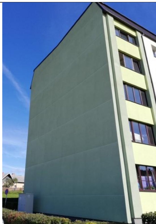
1.2. att. Apsekotā ēka, R fasāde.
