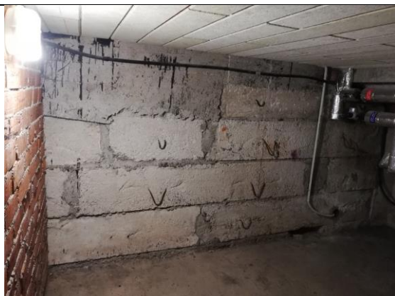
4.1.1.att. Ēkas pagrabstāva ārsienas izbūvētas no dzelzsbetona pamatu blokiem. Pagraba griesti siltumizolēti ar akmens vates lamelēm.
