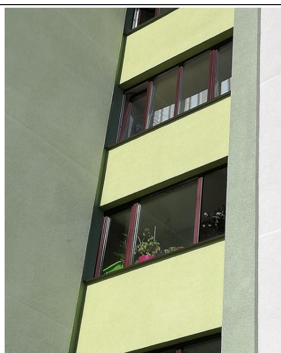
4.9.2.att. Lodžiju ķieģeļu mūra norobežojošās konstrukcijas.
