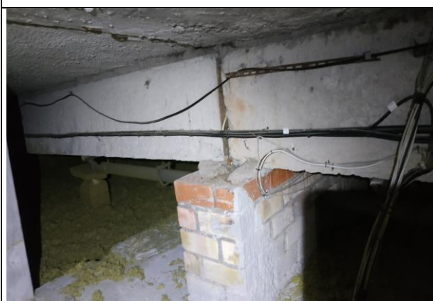
4.8.5.att. Dzelzsbetona gatavelementu teknes balsta vieta.
