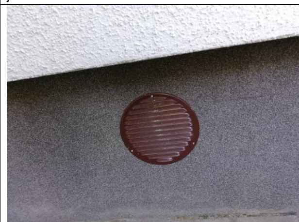
4.14.3.att. Pagraba vēdināšanas izvada nosegreste cokolstāva līmenī.
