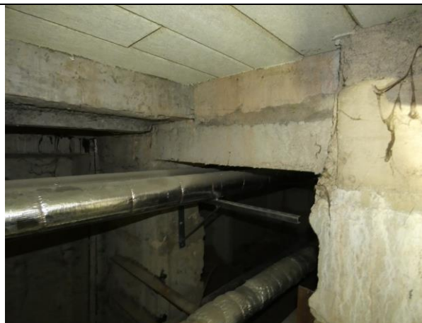
4.2.7.att. Dzelzsbetona pārsedze pagrabā komunikāciju gaitenī.
