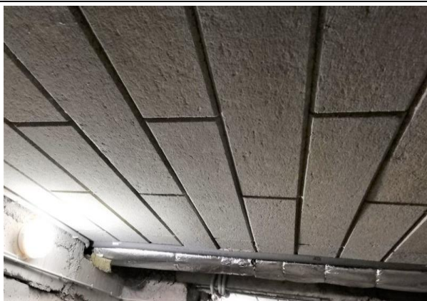
4.6.1.att. Pagraba pārsegums ar ierīkotu akmens vates lameļu siltumizolāciju.
