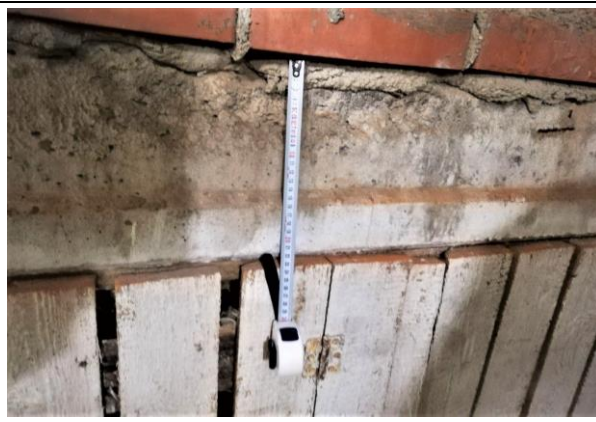
4.6.2.att. Pagraba pārseguma plātne 220mm biezumā.
