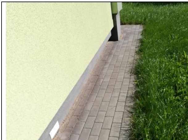
4.1.11.att. Atjaunota bruģakmens seguma pamatu aizsargapmale.
