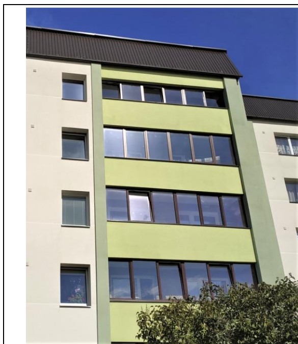
4.9.1.att. Lodžiju ķieģeļu mūra norobežojošās konstrukcijas un stiklojums.
