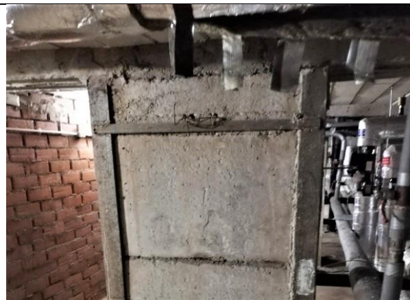
4.2.12.att. Pagraba tehniskā gaiteņa nesošo sienu aiļu pārsedžu balsta pastiprinājuma konstrukcija
