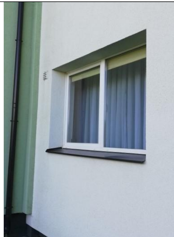
4.12.5.att. Stikla pakešu logs PVC rāmī.
