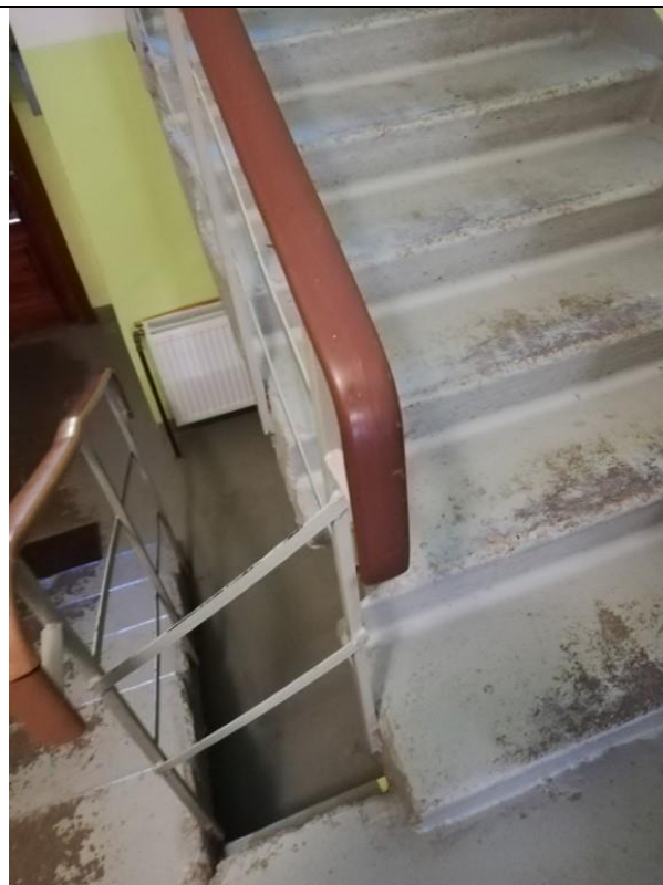
4.10.2.att. Margas nosegtas ar vinila lenteriem.
