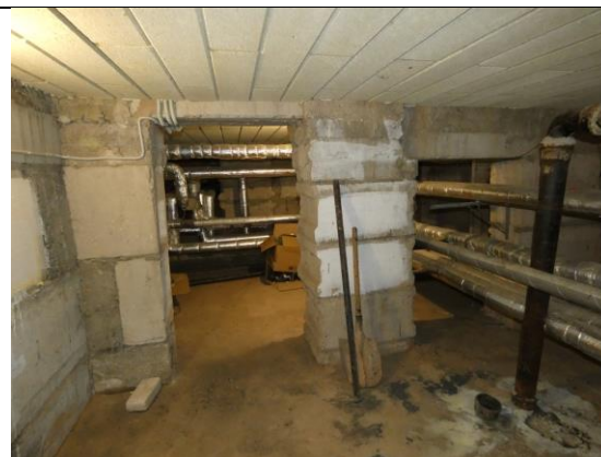
4.1.2.att. Ēkas pagrabstāva pārseguma balstījuma fragments no dzelzsbetona pamatu blokiem.
