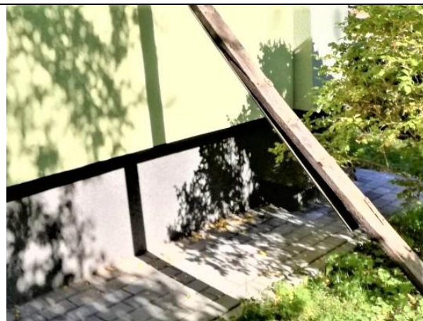
4.1.12.att. Pamatu cokola daļā iestrādāta siltumizolācija ar dekoratīvo apmetumu.
