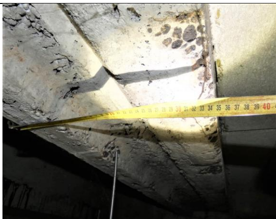
4.4.5.att. Ārsienas keramzītbetona panelis 350 mm biezumā, pagrabstāvā.
