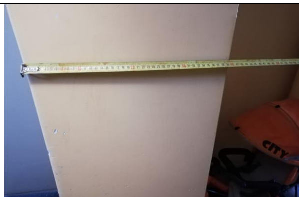
4.2.14.att. Kāpņu telpas nesošās šķērssienu 380 mm biezumā.
