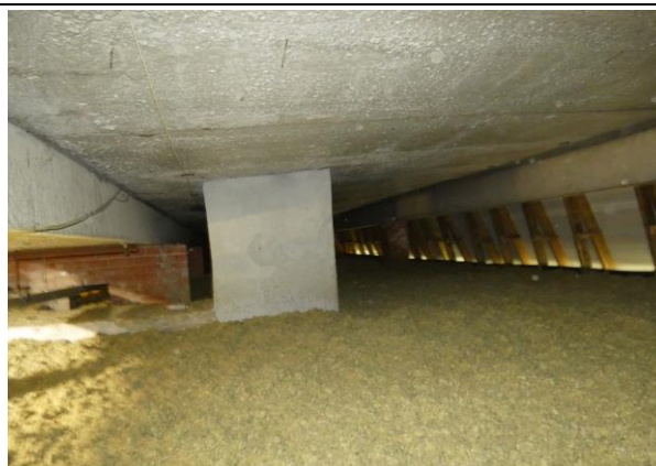
4.6.4.att. Bēniņu grīdas siltumizolācija.
