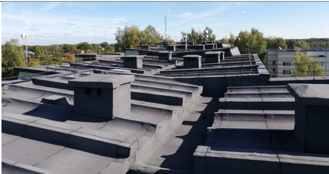
4.8.14.att. Kvalitatīvi izpildīts jumta iesegums.
