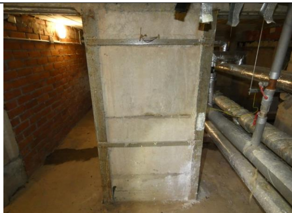
4.2.11.att. Pagraba tehniskā gaiteņa nesošo sienu aiļu pārsedžu balsta pastiprinājuma konstrukcija.
