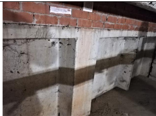
4.4.3.att. Cokola paneli ir apmierinošā tehniskā stāvoklī.
