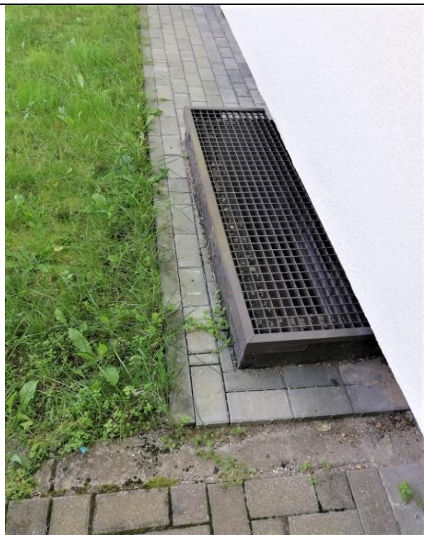
4.12.10.att. Pagraba loga gaismas šahta nosegta ar metāla režģi (lietošanas drošībai)
