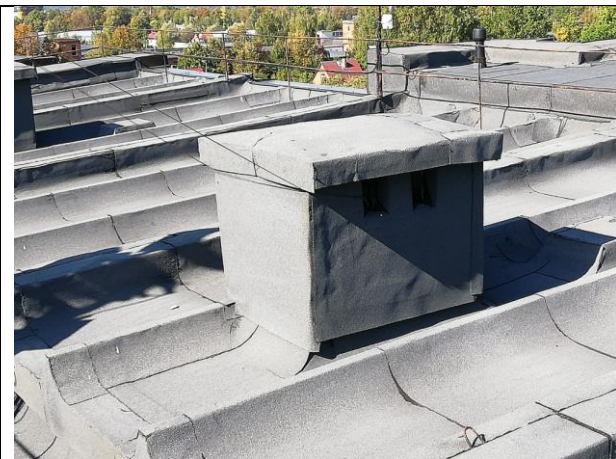
4.14.1.att. Vēdināšanas šahtu izvadi uz jumta.
