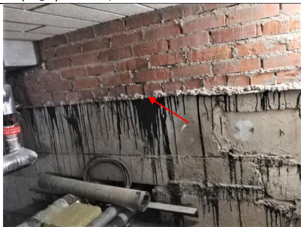
4.1.7.att. Starp pamatu bloku sienu un ķieģeļu mūri ieklāta horizontālā hidroizolācija.
