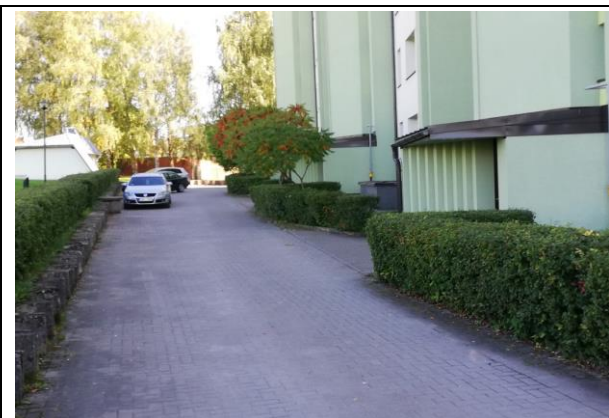
3.1.1.att. Ēkas ziemeļu un austrumu pusē izbūvēta brauktuve ar bruģakmens segumu.
