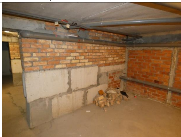
4.1.5.att. Saliekamā dzelzsbetona bloku un ķieģeļu mūra pamati 400 mm biezumā .
