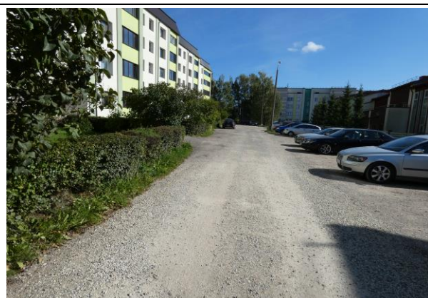
3.1.2.att. Ēkas dienvidu pusē izbūvēta brauktuve ar dolomīta sīkšķembu segumu.
