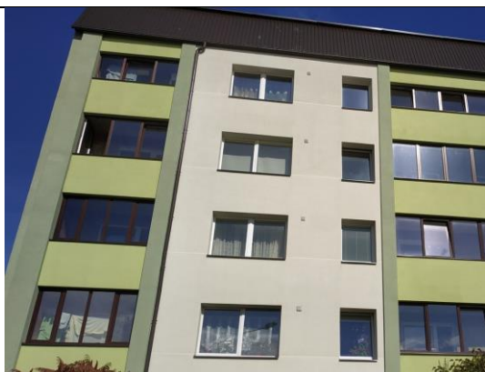
4.4.1.att. iekārtie keramzītbetona ārsienu paneļi nav redzamas, jo ēkas fasāde ir nosiltināta.
