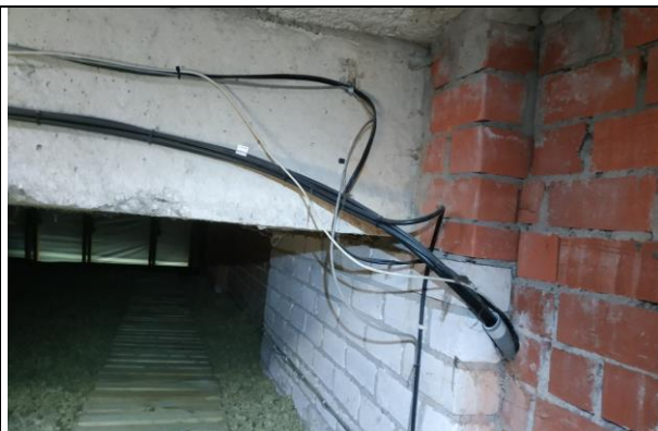
4.8.4.att. Dzelzsbetona tekne 1500 mm platumā balstīta uz šķērssienu.
