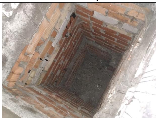
4.14.4.att. Nedarbojoša vēdināšanas šahta
