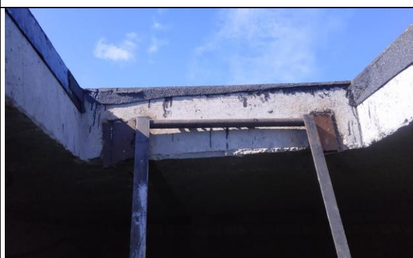
4.8.12.att. Jumta lūkas atvere dzelzsbetona plātnē.
