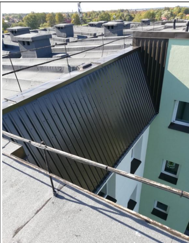
4.8.21.att. Profilētā jumta skārda iesegums virs 5.stāva.
