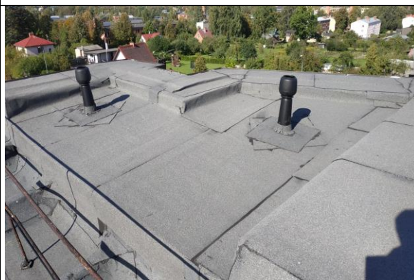
4.8.19.att. Ventilācijas izvadi uz ēkas jumta.
