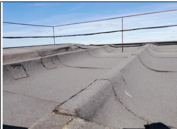
4.8.16.att. Uzstādītas drošības margas pa visu ēkas jumta perimetru.
