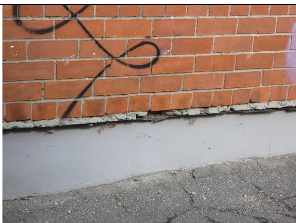
4.5.7.att. Konstatēta bitumena horizontālā hidroizolācija virs pamatu blokiem – apmierinošā stāvoklī.
