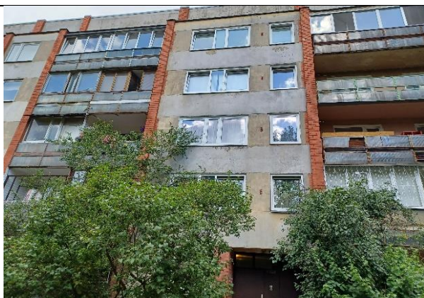
4.4.3.att. Ārsienu paneļi apmierinošā stāvoklī (dienvidu fasāde)
