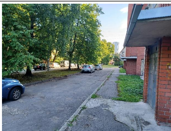
3.1.2.att. Asfaltbetona seguma brauktuve apmierinošā stāvoklī. Ietve ar lokālo bojājumu atjaunošanu daļēji apmierinošā stāvoklī
