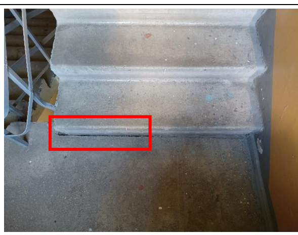
4.10.2.att. Kāpņu laida un kāpņu laukuma neaizdarīta savienojuma vieta
