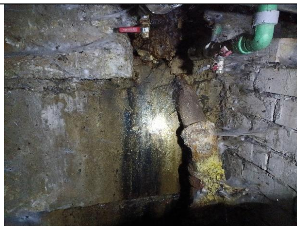
4.1.2.att. Ūdens filtrācijas pazīmes uz pamatu bloka virsmas; pamatu bloka izdrupumi
