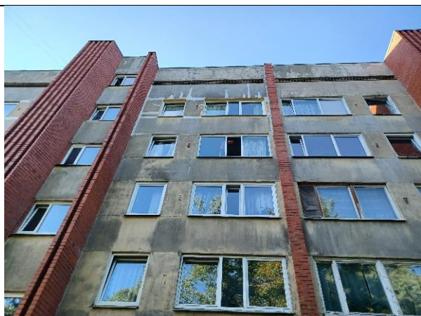
4.13.3.att. koka logi lielākoties aizstāti ar stikla pakešu logiem PVC rāmjos
