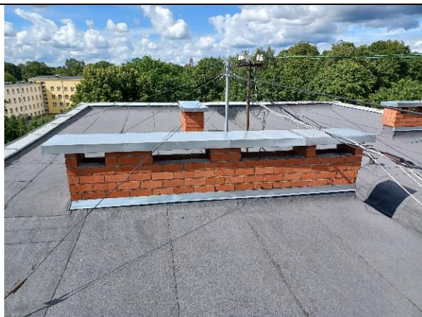
4.15.1.att. Ventilācijas šahtu izvadi virs jumta līmeņa apmierinošā stāvoklī
