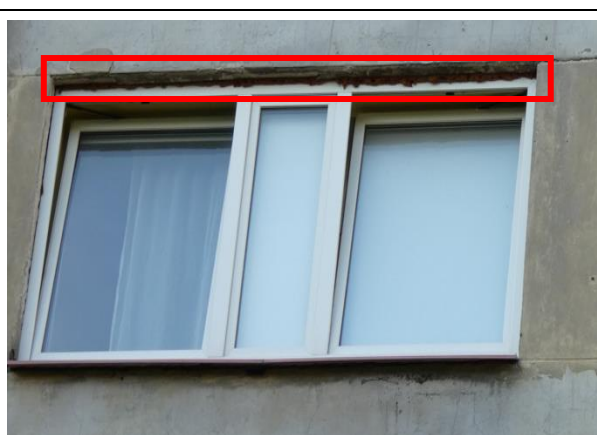
4.13.8. att. Nav veidota atbilstoša logailas apdare pēc montāžas
