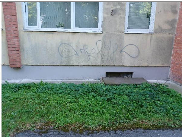
4.13.5. att. Pagraba logi lielākoties aizdarināti, atstājot vēdināšanas atveres
