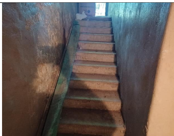
4.10.1.att. Kāpnes pagraba telpā (3. kāpņu telpa) apmierinošā stāvoklī
