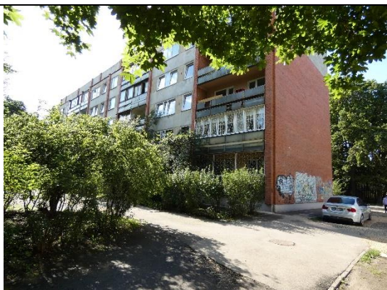
1.3. att. Apsekotā ēka, dienvidu fasāde
