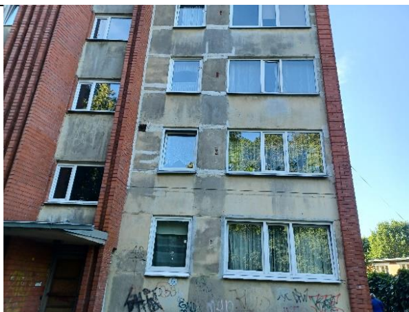
4.15.4. att. Izvadi vēdināšanai sienās - vietām aizdarīti
