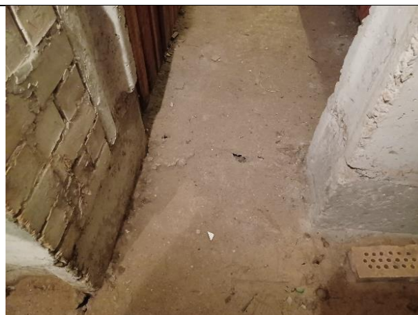
4.1.1.att. Pamatu bloki bez deformācijām
