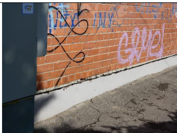
4.5.8.att. Konstatēta bitumena horizontālā hidroizolācija virs pamatu blokiem – apmierinošā stāvoklī.
