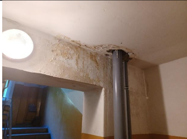
4.10.1.att. Cauruļvadu šķērsojums ugunsdrošajā konstrukcijā, nav veikta ugunsdrošā aizdare.
