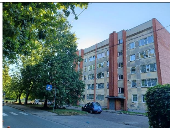
1.4. att. Apsekotā ēka, ziemeļu fasāde
