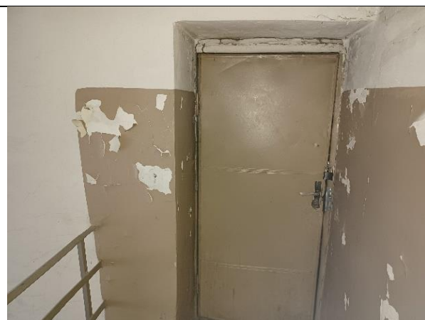
4.13.10. att. Bēniņu telpas metāla durvis apmierinošā stāvoklī
