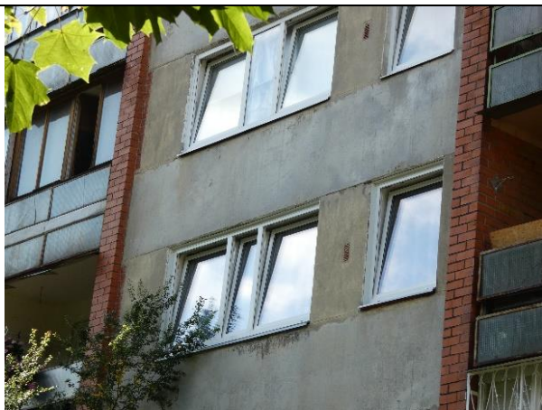
4.5.3.att. Ārsienu paneļu šuves labā stāvoklī (dienvidu fasāde)
