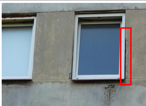
4.5.4.att. Nehermētisks pieslēgums gar logu (dienvidu fasāde)
