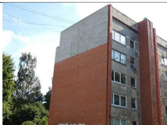
1.2. att. Apsekotā ēka, austrumu fasādes
