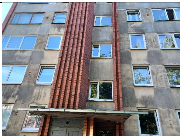
4.13.4. att. Kāpņutelpās stikla pakešu logi pvc rāmjos – apmierinošā stāvoklī
