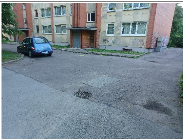
3.1.1.att. Asfaltbetona seguma brauktuve apmierinošā stāvoklī
