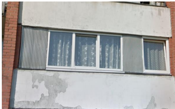
25.att. Variants ar ārsienu, kur ir siltināts koka karkss starp logiem
