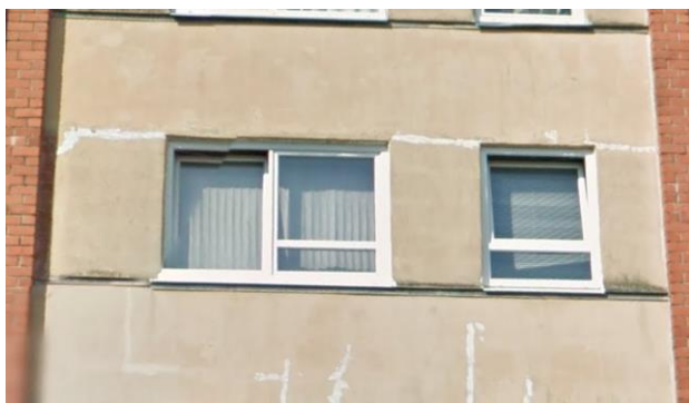
24.att. Variants ar ārsienu, kur ir gāzbetona paneļiem starp logiem
