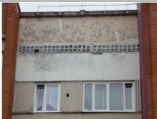
4.5.2. att. Nehermētiska savienojuma vieta starp ēkas sekcijām.
