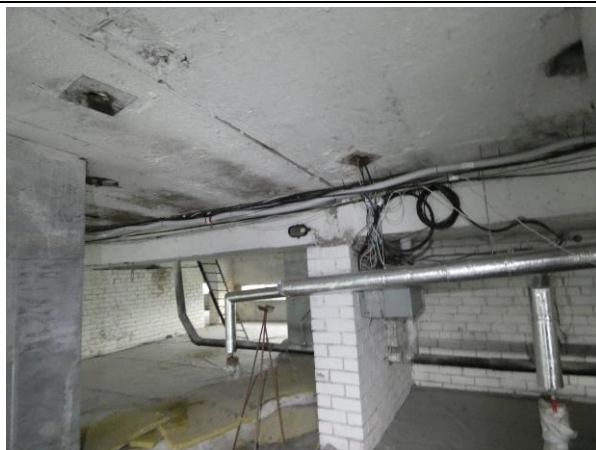
4.8.29. Att. Tekņu balstījuma vietas uz mūra šķērssienu – apmierinošā stāvoklī.
