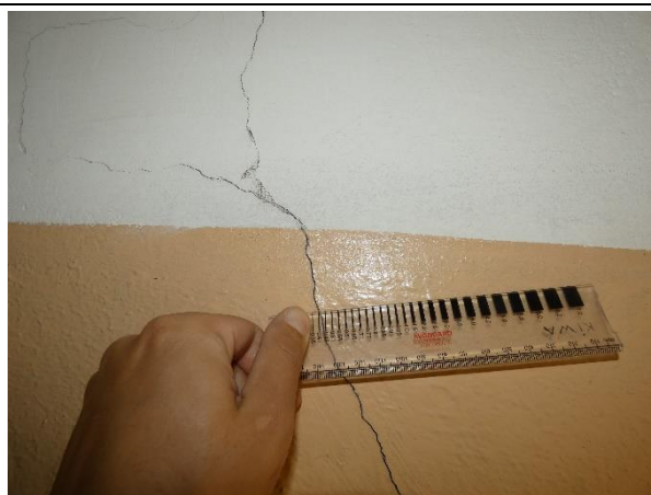
4.2.8.att. Plaisas platums kāpņu telpas sienā 0,4 mm.
