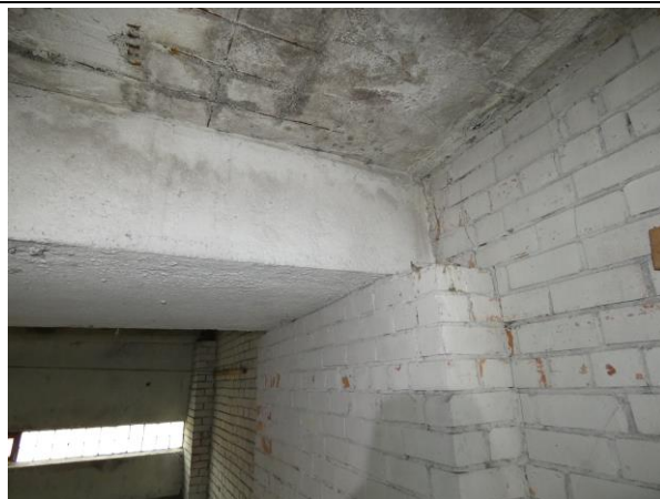
4.8.30. Att. Tekņu balstījuma vieta uz mūra šķērssienu – apmierinošā stāvoklī.
