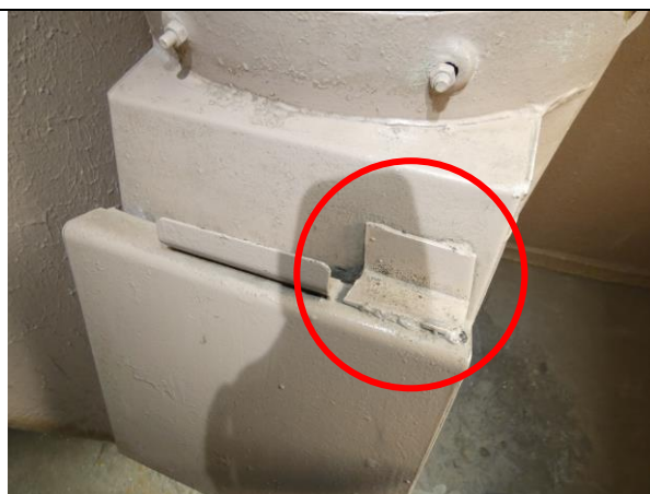
4.16.2.att. Atkritumu vada vāks aizmetināts un atkritumu vads netiek ekspluatēts
