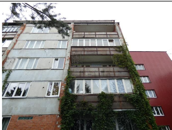
4.13.12. att. Lodžijām veidots dažāds ailu aizpildījums.
