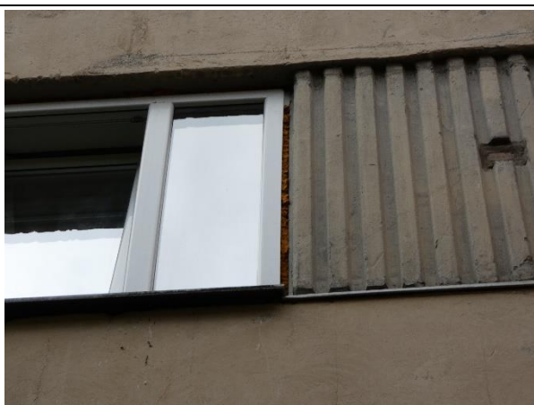
4.5.5. att. Nehermētiska savienojuma vieta starp logu un dekoratīvo loga aizpildījumu.
