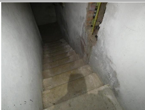
4.10.9.att. Kāpnes uz pagrabu – dzelzsbetona konstrukcijās, apmierinošā stāvoklī.
