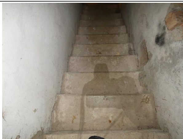
4.10.10.att. Kāpnes uz pagrabu – dzelzsbetona konstrukcijās, apmierinošā stāvoklī.
