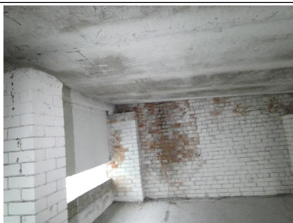
4.8.10.att. Konstatēta mitruma infiltrācija pie gala sienas.
