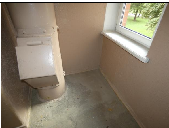
4.16.1.att. Atkritumu vada vāks aizmetināts un atkritumu vads netiek ekspluatēts
