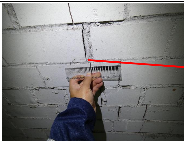
4.2.9.att. Plaisa nesošajā šķērssienā bēniņos. Iespējams, nav pietiekams stiebrojums
