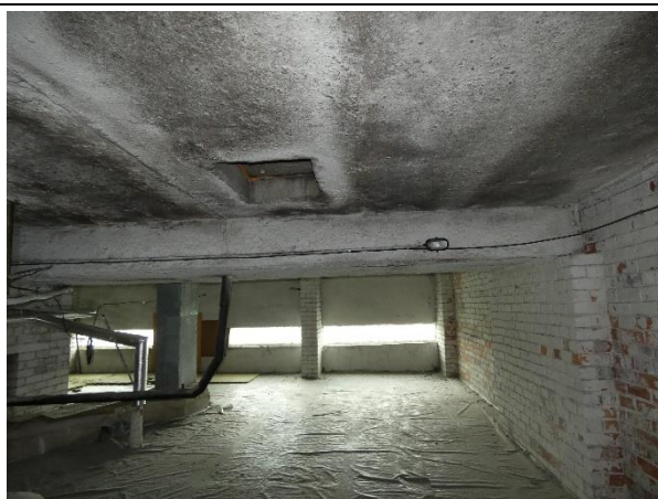
4.8.7.att. Dzelzsbetona teknes balsta vieta apmierinošā stāvoklī.
