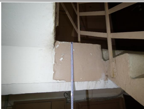
4.10.3.att. Kāpņu laukuma un laiduma savienojuma vietas – apmierinošā stāvoklī.
