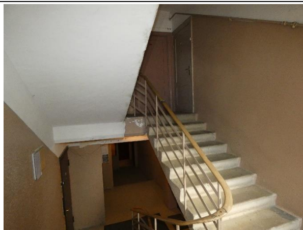
4.10.2.att. Kāpņu dzelzsbetona konstrukcijas apmierinošā stāvoklī.
