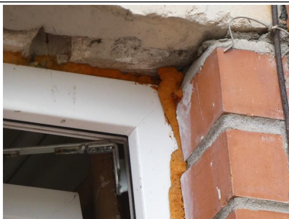
4.13.2. att. Nav veidota atbilstoša logailas apdare pēc montāžas.
