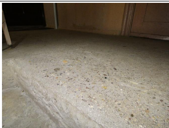
4.10.12.att. Kāpņu laukumīņš ar virskārtas nodilumu.
