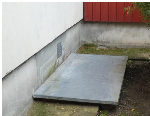
4.13.10. att. Pagraba logs aizmūrēts, atstājot vēdināšanas atveres.
