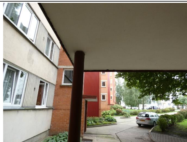
4.9.2.att. Jumtiņi virs ieejas mezgliem apmierinošā stāvoklī. Atjaunota plātnes dekoratīvā apdare no apakšpuses.
