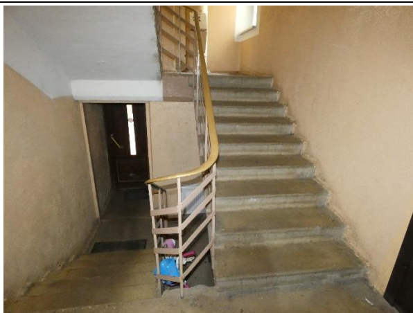
4.10.1.att. Kāpņu dzelzsbetona konstrukcijas apmierinošā stāvoklī.
