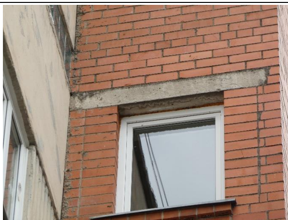
4.13.4. att. Kāpņutelpās stiklapakešu logi pvc rāmjos – labā stāvoklī.
