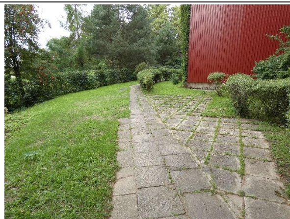
3.1.4.att. Ietves – daļēji apmierinošā stāvoklī.
