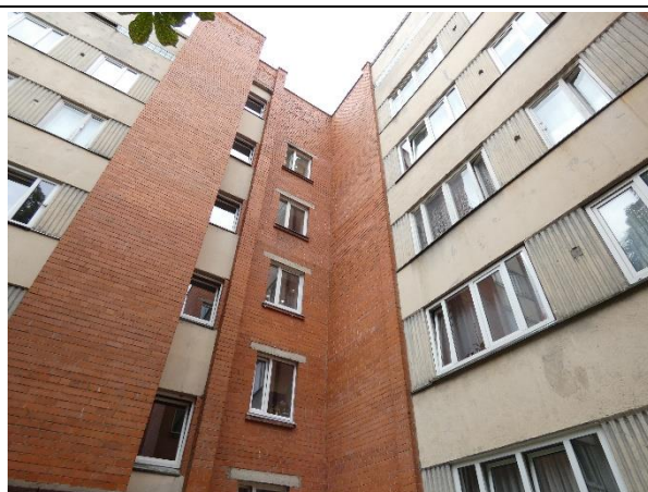
4.5.6. att. Ēkas sekciju savienojuma vieta bez plaisām – apmierinošā stāvoklī.
