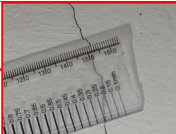
4.2.6.att. Plaisas platums kāpņu telpas sienā 0,25 mm.
