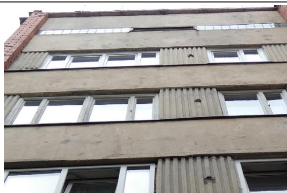
4.13.14. att. Koka logi – daļēji apmierinošā stāvoklī. Ieteicams tos nomainīt.
