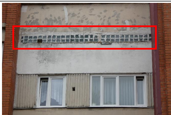
4.13.13. att. Bēniņos ailu aizpildījumu veido bojāti stiklabloki. Ieteicams tos nomainīt.
