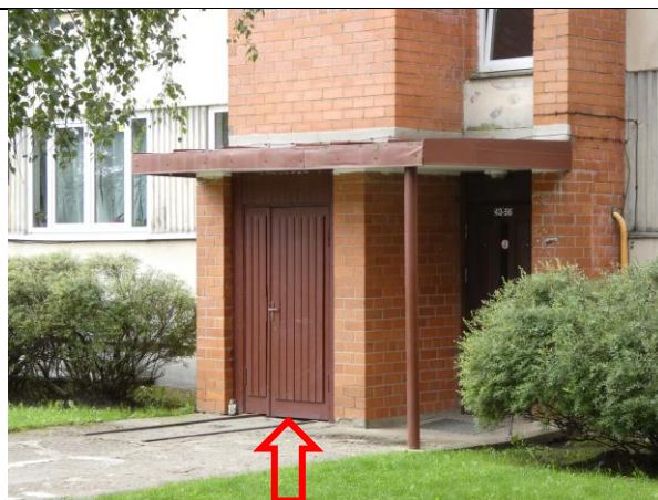
4.16.3.att. Atkritumu kameras durvis – apmierinošā stāvoklī.
