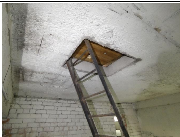
4.10.15.att. Kāpnes uz jumtu - apmierinošā stāvoklī.
