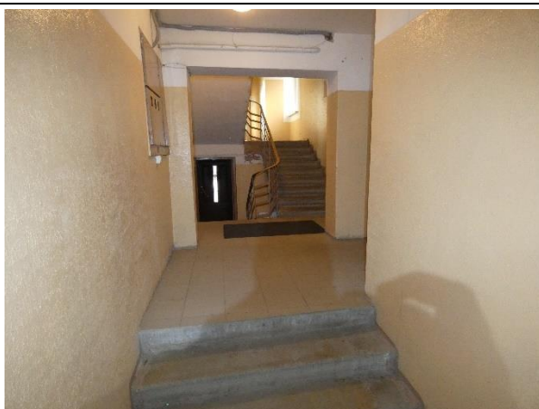
4.10.11.att. Kāpnes ieejas mezglā – dzelzsbetona konstrukcijās, apmierinošā stāvoklī.
