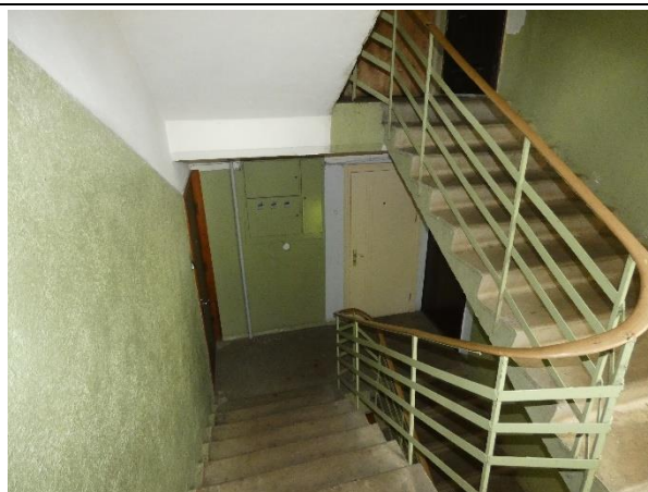
4.10.4.att. Kāpņu laukuma un laiduma savienojuma vietas – apmierinošā stāvoklī.
