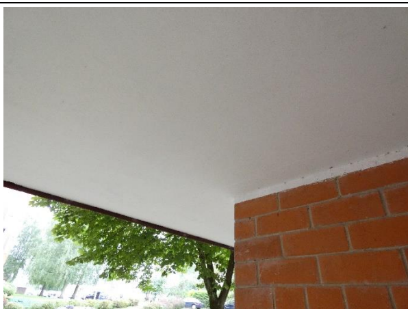
4.9.3.att. Atjaunota plātnes dekoratīvā apdare no apakšpuses.
