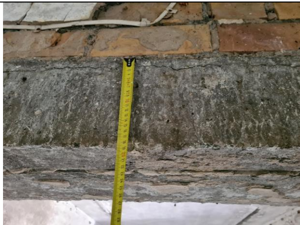
6.1.att. Dzelzsbetona pārsedzes nesošās mūra šķērssienas vidusdaļā ierīkotas no divām dzelzsbetona gatavelementu pārsedzēm, 200(h)x250 mm un 200(h)x120mm. Sk. kopā ar att. 6.2.
