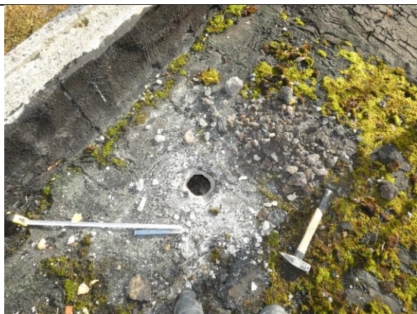
8.1.att. Jumta atsegums. Konstatēta siltumizolācijas kārtā 35-40 cm biezumā (faktiski, keramzīts un būvgruži), cementa javas izlīdzinošā kārtā 5-7 cm un ruberoīda un kausēta piķa kārtas ~20 mm. Kopējais biezums 45 cm.
