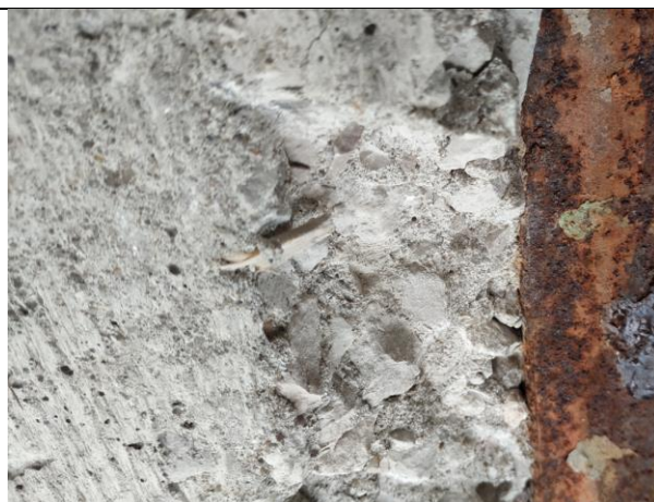
3.4.att. Ieejas mezgla jumtiņa dzelzsbetona plātne. Karbonizētais slānis lielāks par 2 cm.
