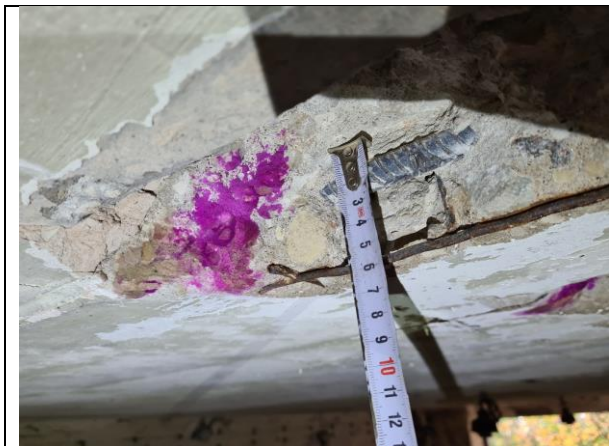
3.1.att. Dobās starpstāvu pārseguma plātnes pagrabā. Karbonizētais slānis 1-2 mm.
