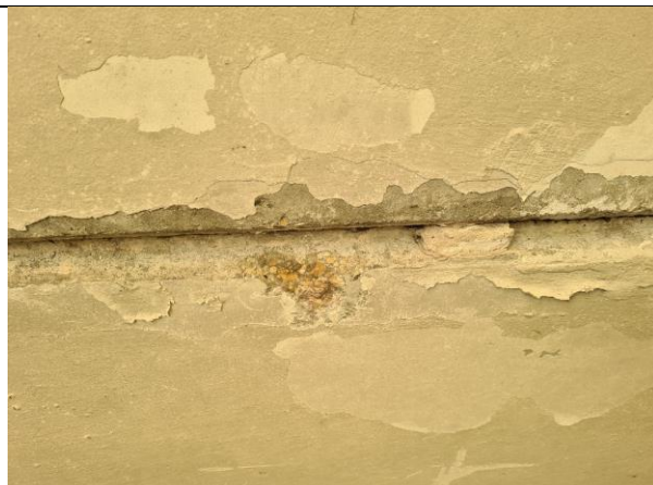
3.2.att. Dobās starpstāvu pārseguma plātnes 1.stāvā. Karbonizētais slānis ~ 1,0 cm.
