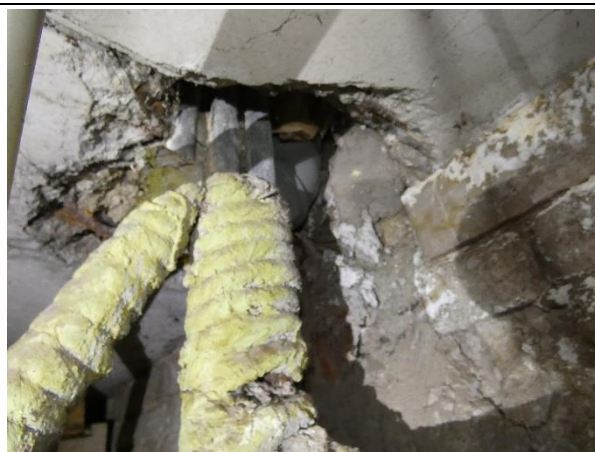
4.6.4. Att. Nehermētiski inženierkomunikāciju šķērsojumi pagraba pārsegumā.
