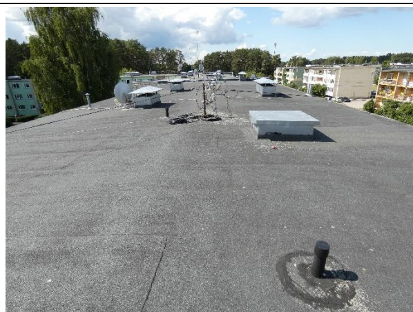
4.8.1.att. Jumta segums apmierinošā stāvoklī.
