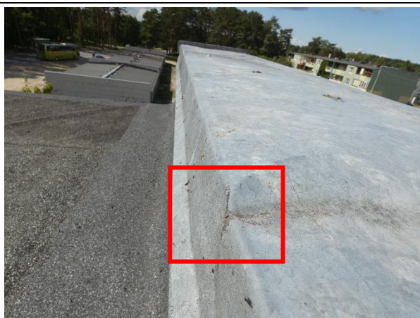
4.8.9.att. Bojāts parapeta skārda nosegelements.
