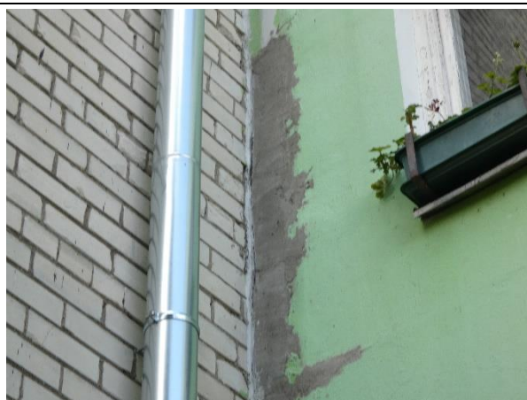
4.5.6. att. Remontēta savienojuma vieta starp ēkas sekcijām.
