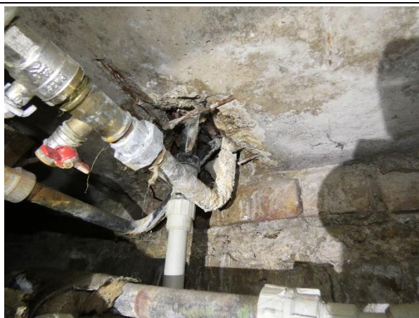
4.6.3. Att. Nehermētiski inženierkomunikāciju šķērsojumi pagraba pārsegumā.
