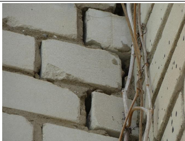
4.5.2. att. Nehermētiska savienojuma vieta starp ēkas sekcijām.
