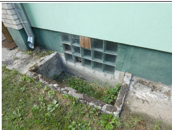
4.13.11. att. Pagraba logailas aizpildījums ar stiklablokiem. Konstatēti bojāti bloki.
