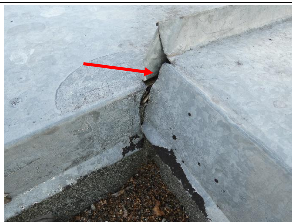
4.8.14.att. Nehermētiski parapeta skārda savienojuma elementi.
