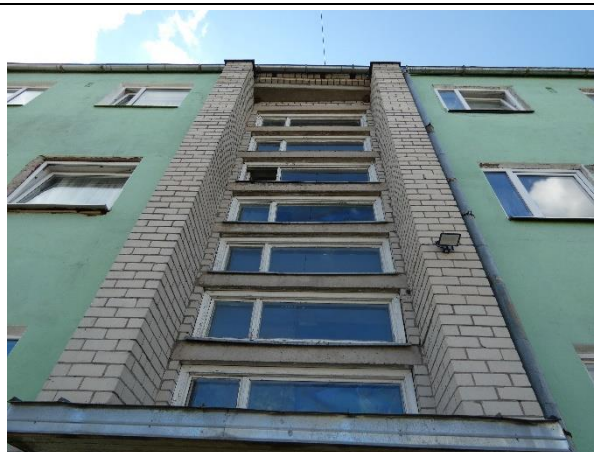
4.13.4. att. Kāpņutelpās koka futera tipa logi ar divkāršu stiklojumu. Lokālās vietās stiklojums bojāts vai iztrūkst.
