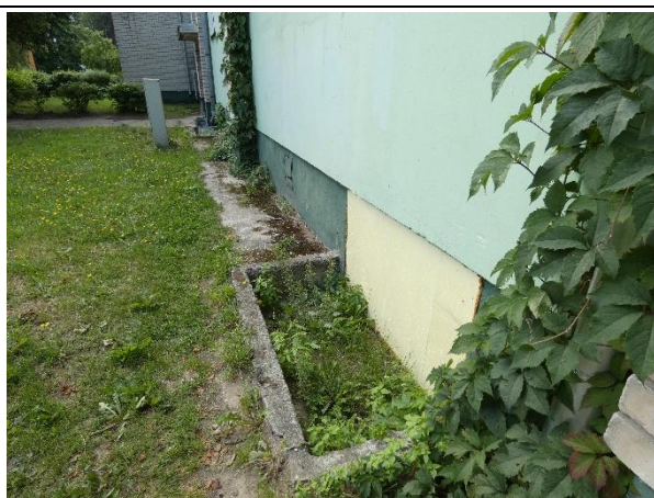
4.5.7. att. Nehermētiska šuve pagraba loga aizpildījuma vietā.
