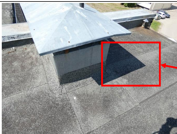
4.8.7.att. Mitrums zem jumta seguma.
