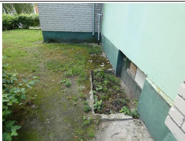
4.13.10. att. Pagraba logaila aizpildīta ar dažādiem būvmateriāliem.
