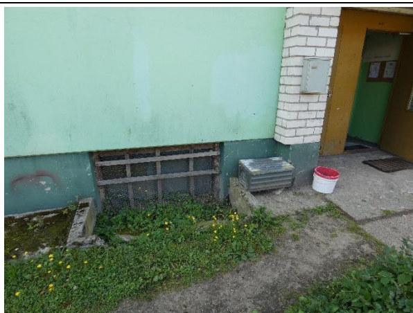
4.13.3. att. Pagraba logi aizdarīti ar dažādiem materiāliem.
