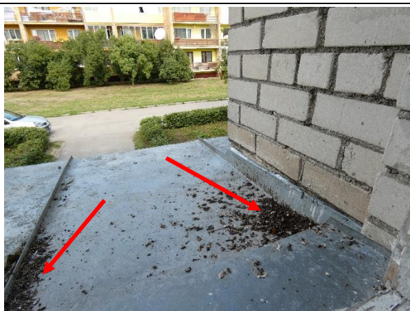
4.9.3.att. Gruži uz ieejas mezglu jumtiņiem.
