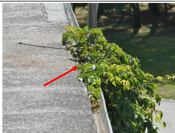
4.8.10.att. Tekne daļēji nosprostota ar vītenaugiem.
