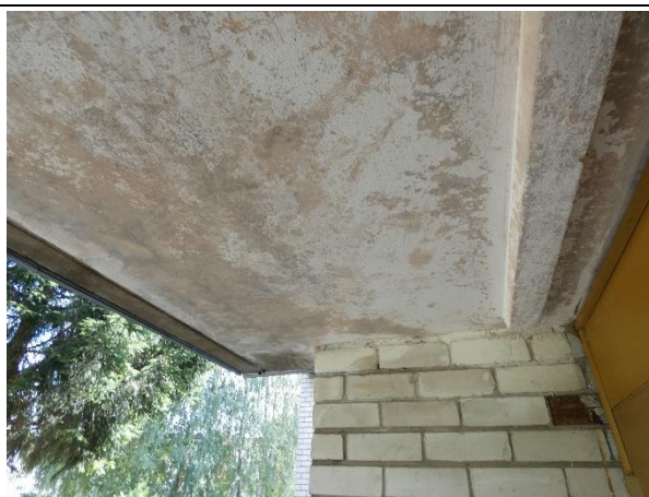
4.9.4.att. Mitruma pazīmes zem ieejas mezglu jumtiņiem.
