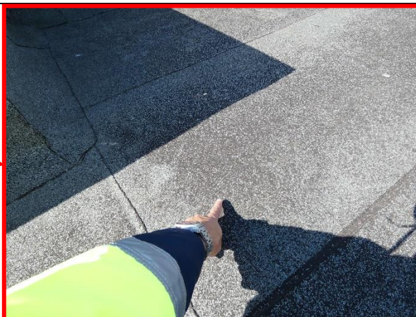
4.8.8.att. Mitrums zem jumta seguma.
