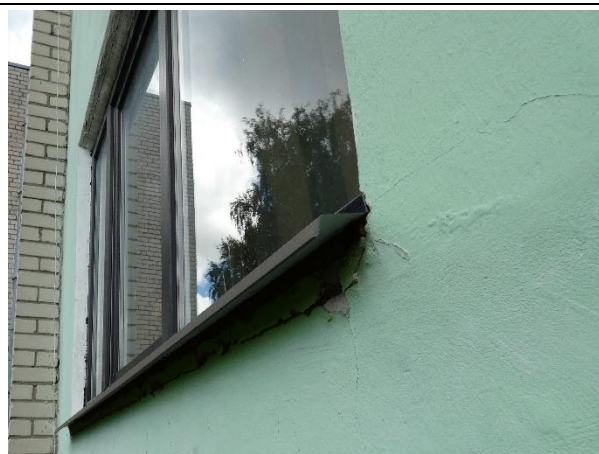
4.5.1. att. Nehermētiska starppaneļu šuve.
