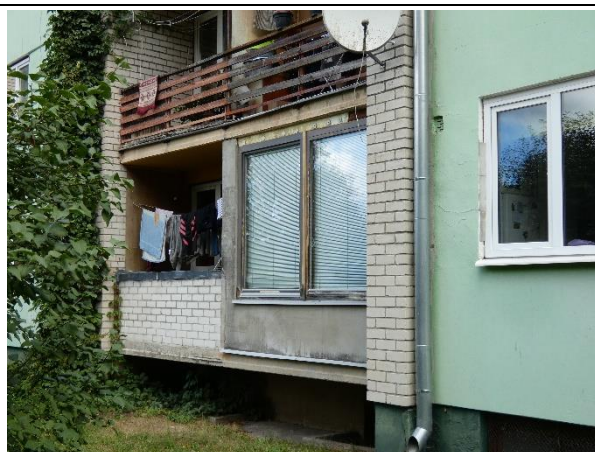
4.13.12. att. Lodžijām veidots dažāds ailu aizpildījums.
