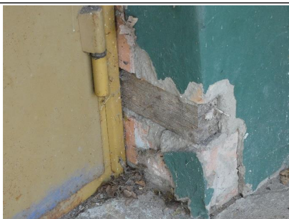
4.5.9. att. Cokola zonā vertikālā hidroizolācija netika konstatēta.
