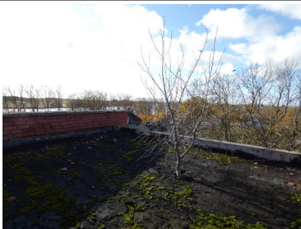
4.8.2.att. Jumta klājs ar apaugumu
