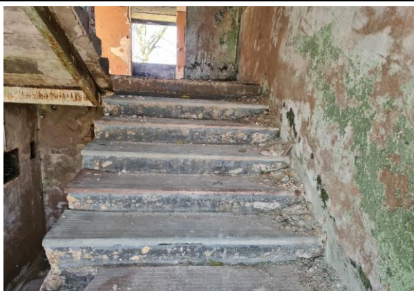
4.10.3.att. Kāpņu laidī no dzelzsbetona gatavelementiem balstīti uz nesošajām metāla konstrukcijām
