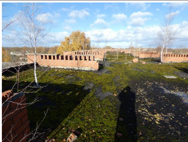
4.8.1.att. Jumta klājs ar apaugumu
