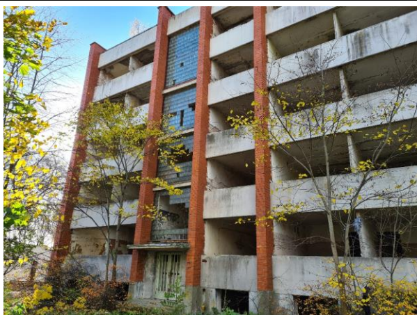
4.12.1.att. Stikla bloku ailu aizpildījums kāpņu telpā
