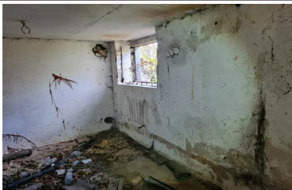
4.2.9.att. Pagraba ķieģeļu mūra garensienas 510 mm biezumā
