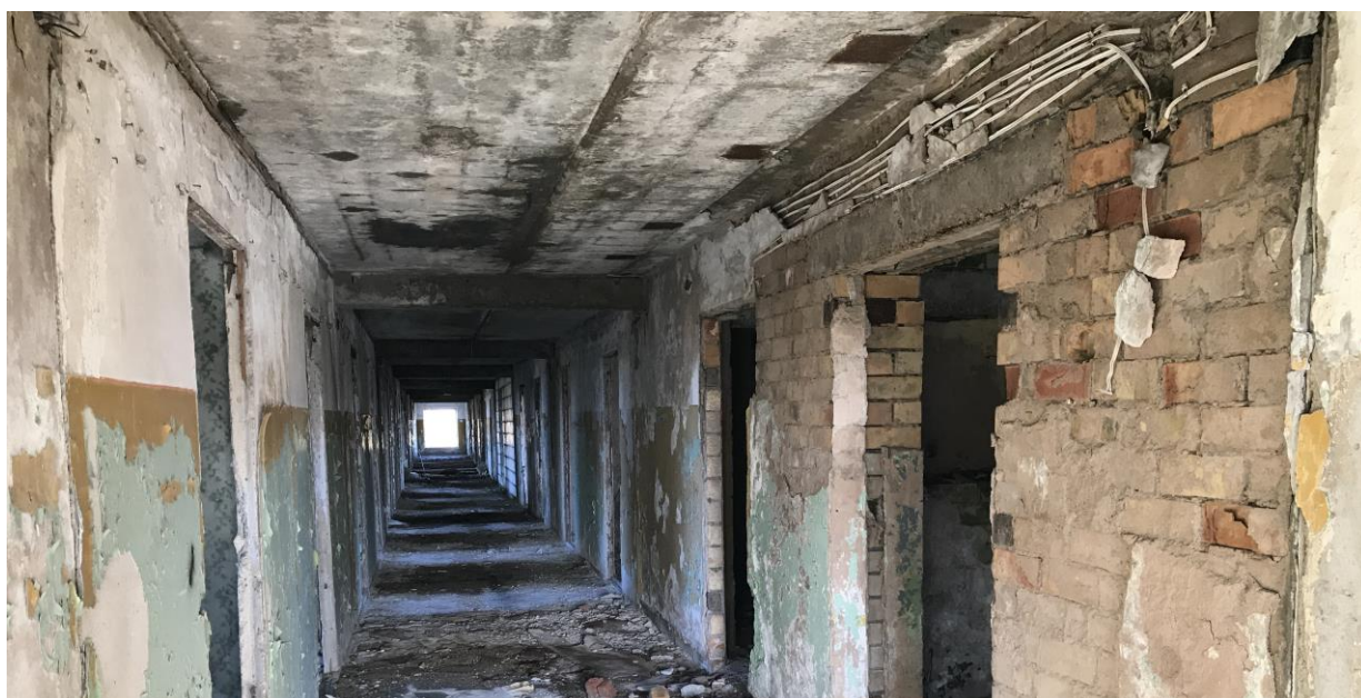
4.8.2.att. Savietotā jumta dobās dzelzsbetona pārseguma plātnes ar mitruma izraisītiem bojājumiem
