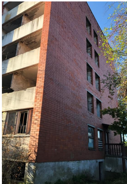
1.2. att. Apsekotā ēka, ziemeļrietumu fasādes daļa
