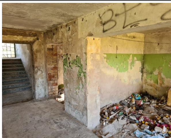
4.2.6.att. Nesošās mūra šķērssienas 380 mm biezumā
