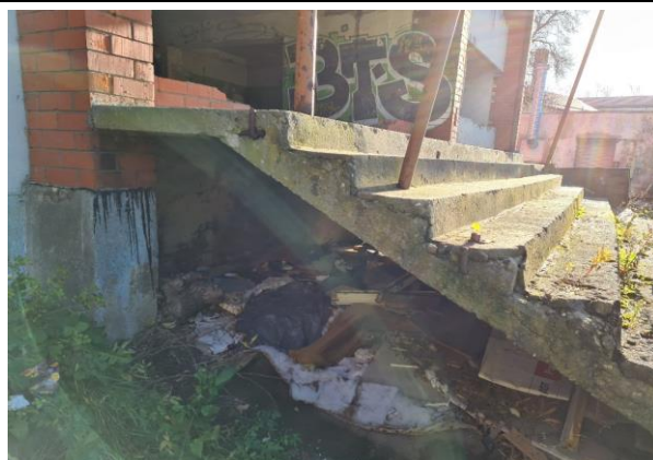
4.10.4.att. Ārējās dzelzsbetona kāpnes degradētas un ir neapmierinošā tehniskajā stāvoklī
