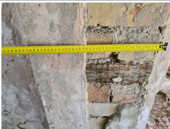
4.2.7.att. Nesošās mūra šķērssienas 380 mm biezumā
