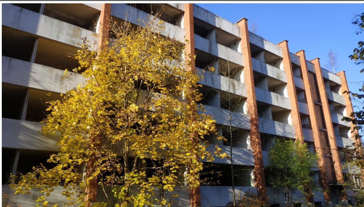
1.3. att. Apsekotā ēka, ziemeļaustrumu fasāde
