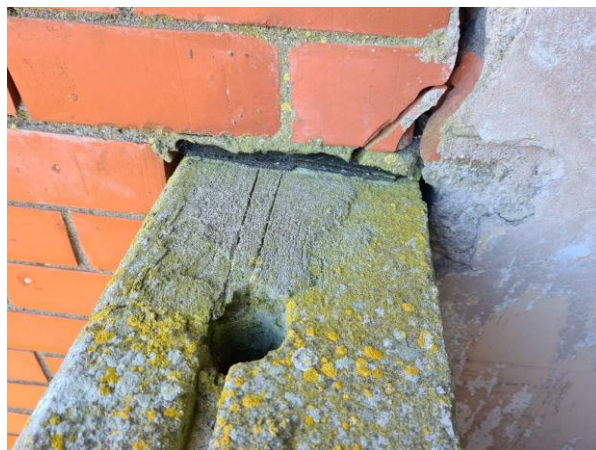
4.4.2.att. Ārsienas paneļi. Paneļu galu virsmām ierīkota ruberoīda hidroizolācija.
