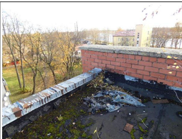
4.8.6.att. Skārda nasegdetaļas korodējušas
