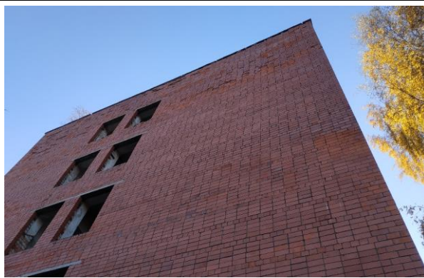
4.2.10.att. Gala siena ar mūra eroziju augšdaļā
