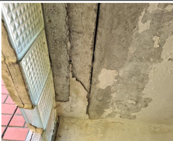
4.2.5.att. Dzelzsbetona gatavelementu pārsedzes kāpņu telpā
