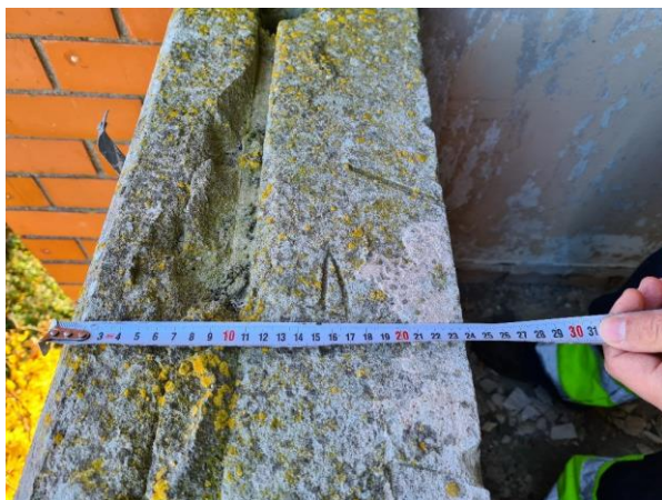
4.4.1.att. Ārsienas gāzbetona paneļi 240 mm biezumā
