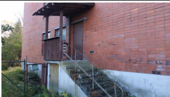
4.10.3.att. Kāpņu laidī no dzelzsbetona gatavelementiem balstīti uz nesošajām metāla konstrukcijām
