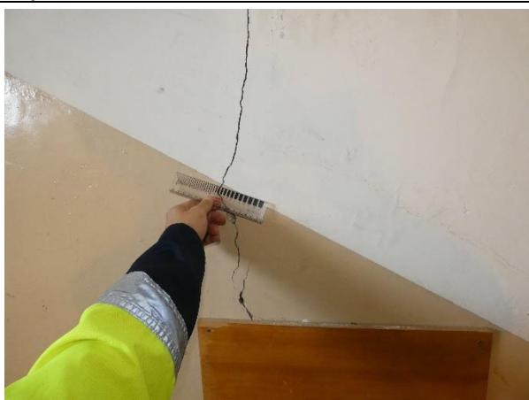
4.2.23.att. Plaisas platums kāpņu telpas sienā 2,0 mm. 1905.gada iela, Talsi.
