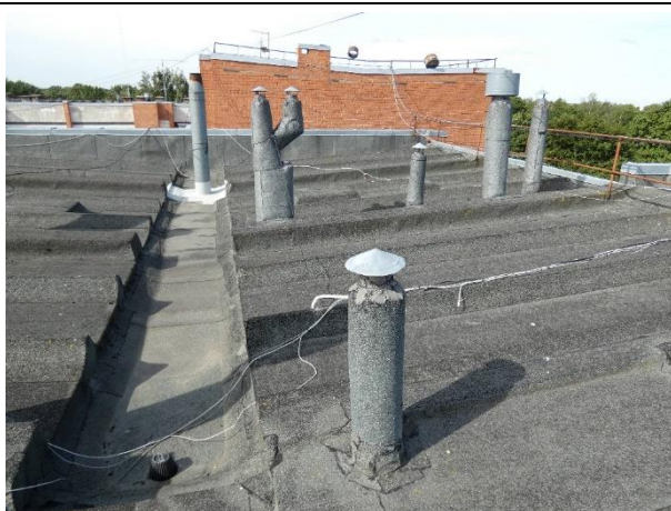
4.8.10.att. Jumta segums labā tehniskā stāvoklī. Jumta konstrukcija ar paneļu ribām uz augšu.
