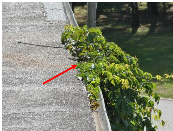
4.8.67.att. Tekne daļēji nosprostota ar vītenaugiem. Kapseļu iela 4 k-2, Rīga
