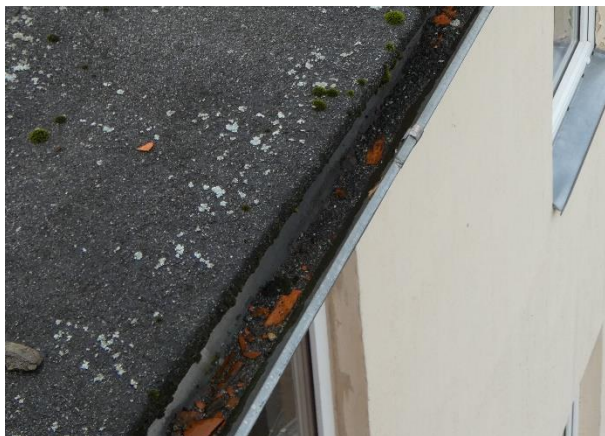
4.8.76.att. Tekne daļēji nosprostota ar gružiem. Mazcenu aleja 9, Jaunmārupe
