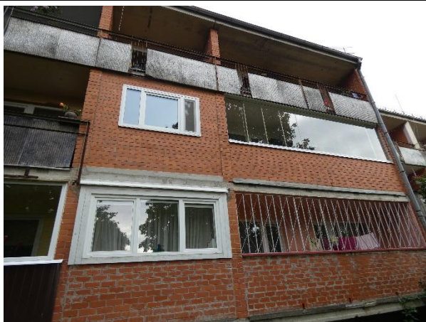
4.9.3.att. Lodžiju norobežojuma konstrukcijas korozija. Kapseļu iela 4 k-2, Rīga
