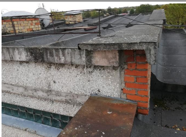
4.8.34.att. Jumta klājs no ribotajām plātnēm, parapets nosegts ar dzelzsbetona elementu, Valmieras iela 21, Cēsis
