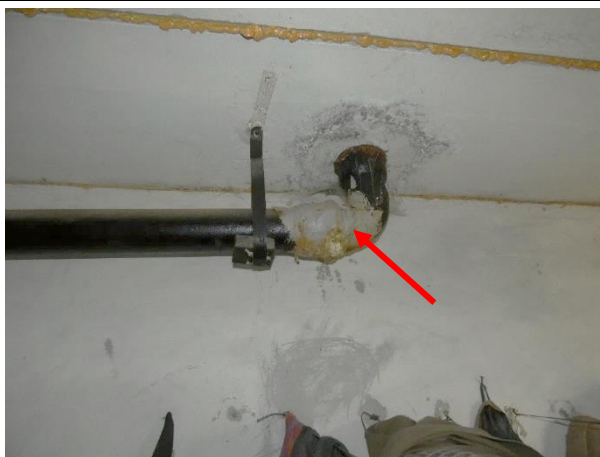
4.8.75.att. Lietus ūdens kanalizācijas cauruļvadi (ķeta). Iepriekš veikts savienojumu remonts un blīvēšana. Loka iela 3, Cēsis
