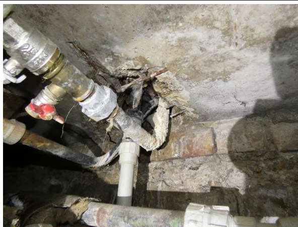
4.6.6. Att. Nehermētiski inženierkomunikāciju šķērsojumi pagraba pārsegumā. Mazcenu aleja 13, Mārupe
