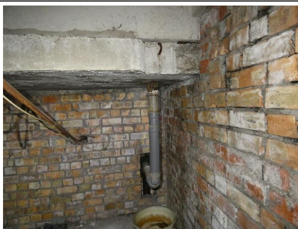
4.8.65.att. Lietusūdens novadsistēma, daļēji nomainīta uz PVC caurulēm. Kapseļu iela 4 k-2, Rīga
