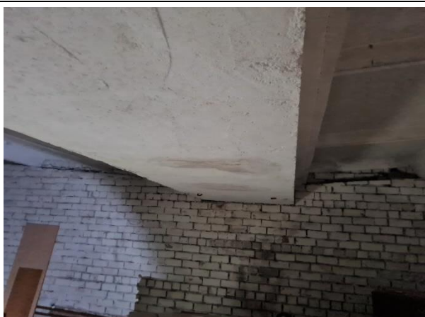
4.8.28.att. Tekņu elementu balsta vieta bez bojājumiem, apmierinošā stāvoklī. Grēdu ielā 3, Rīgā
