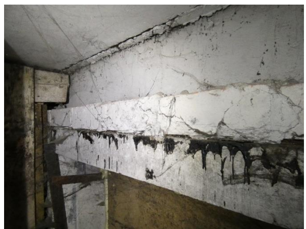
4.1.11.att. Horizontālā hidroizolācija virs cokola paneļiem. Kapseļu iela 4 k2, Rīga
