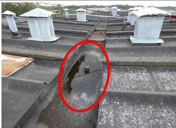
4.8.46.att. Nokrišņu uzkrāšanās dzelzsbetona tehnē. Jumta segums ar apaugumiem. Ausekļa prospekts 1, Ogre
