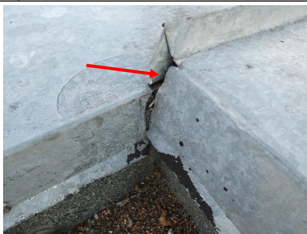
4.8.40.att. Nehermētiski parapeta skārda savienojuma elementi. Mazcenu aleja 13, Mārupe
