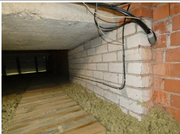
4.8.30.att. Tekņu elementu balsta vieta uz mūra sienu labā stāvoklī. Vaives iela 2A, Cēsis
