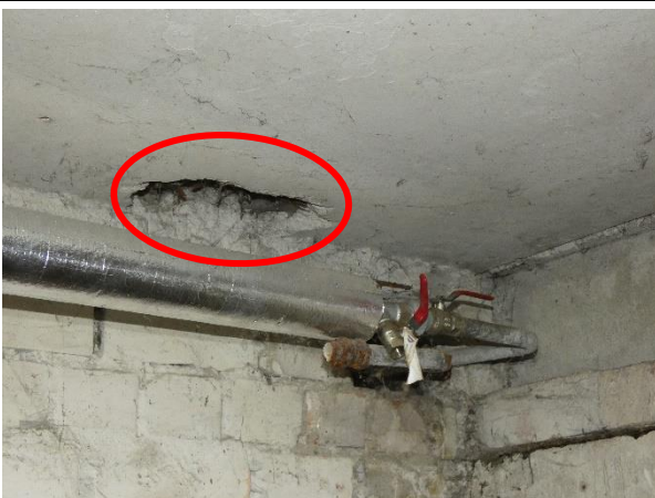
4.6.5.att. Atvērumi un nehermētiski komunikāciju šķērsojumi un izdrupumi pagraba pārsegumā. Kapseļu iela 4 k-2, Rīga.
