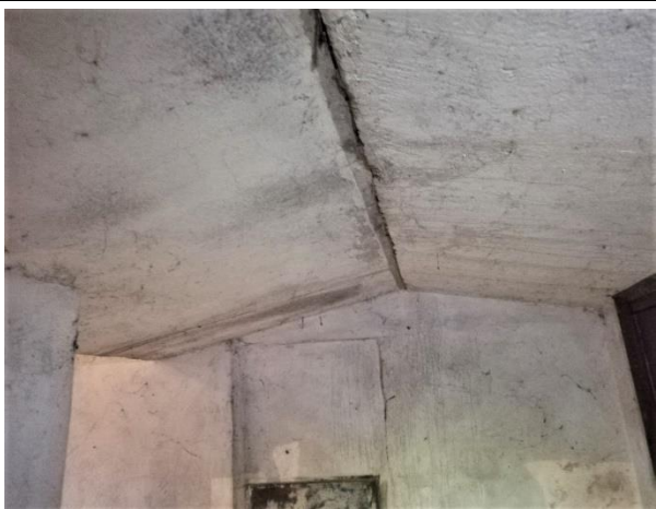
4.6.9.att. Pagraba pārseguma dobie paneļi 220 mm biezumā, javas izdrupumi starp plātnēm. Valmieras iela 25, Cēsis.
