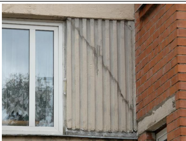
4.4.15. att. Izdrupumi starppaneļu šuvē, aizdare veikta nekvalitatīvi. Irlavas iela 26, Rīga.
