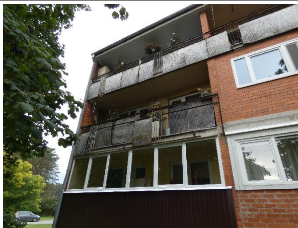
4.9.4.att. Korodējusi lodžiju konstrukcija un stiprinājumu elementi. Kapseļu iela 4 k-2, Rīga
