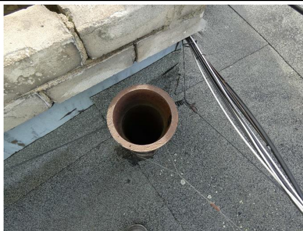
4.8.55.att. Trūkstošie skārda nasegelementi izvadiem jumtā. 1905.gada iela 7, Talsi
