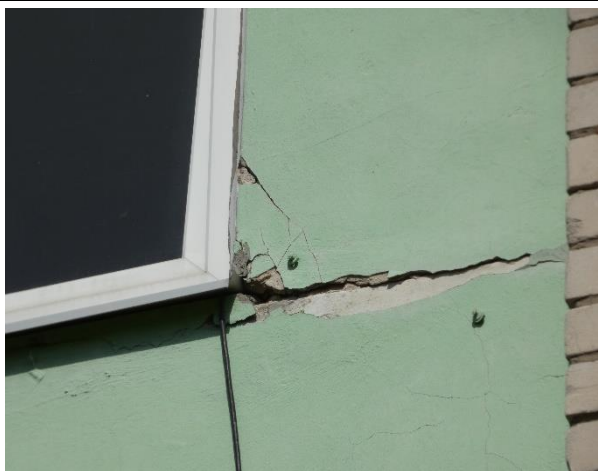
4.5.1. att. Nehermētiska starppaneļu šuve un izdrupumi. Mazcenu aleja 13, Mārupe.
