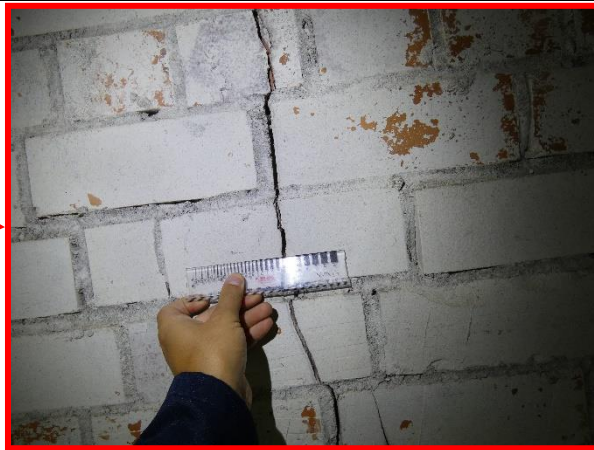
4.2.30.att. Plaisa nesošajā sienā bēniņos Ausekļa prospekts 1, Ogre.
