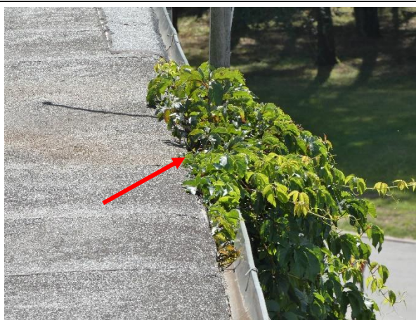
4.8.41.att. Tekne daļēji nosprostota ar vītenaugiem, nav organizēta nokrišņu ūdens novadīšana. Mazcenu aleja 13, Mārupe
