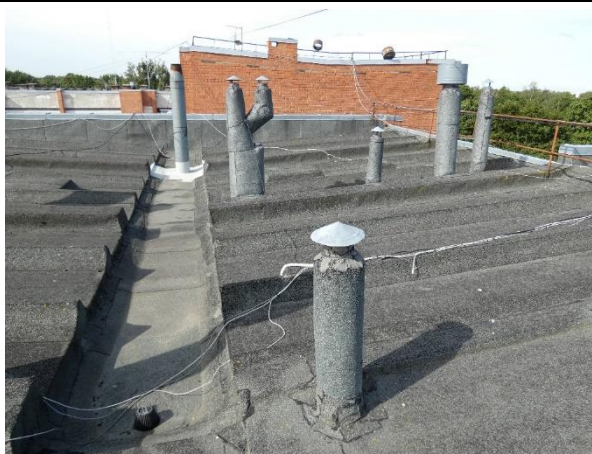
4.8.43.att. Jumta segums labā tehniskā stāvoklī. Irlavas iela 26, Rīga
