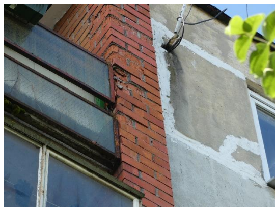
4.9.4.att. Korodējusi lodžiju konstrukcija un stiprinājumu elementi. Kapseļu iela 4 k-2, Rīga
