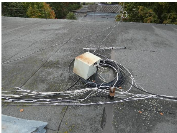
4.8.58.att. Kabeļi nav atbilstoši aizsargāti. Neatbilstoša kabeļu izolācija. Mazcenu aleja 9, Jaunmārupe
