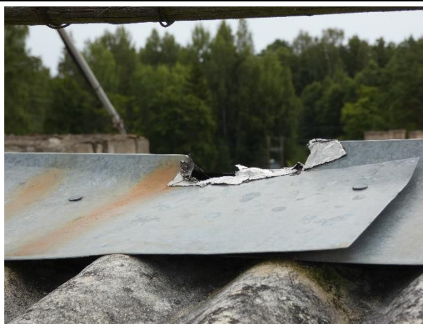
4.8.63.att. Nehermētiski un bojāti skārda elementi kores daļā. Mazirbe, Skolotāju māja 2.
