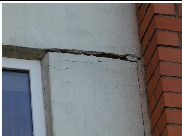
4.4.23.att. Izdrupums starppaneļu šuves aizpildījuma. Plaisu tīkls. Loka iela 3, Cēsis.
