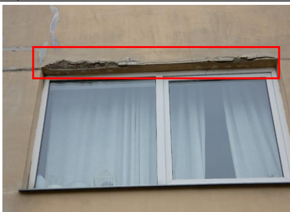
4.4.13. att. Ārsienas paneļa apakšējās malas izdrupumi. Irlavas iela 26, Rīga.
