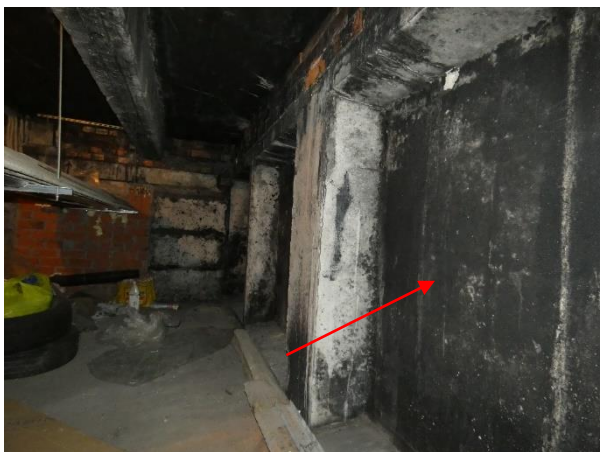
4.2.4. att. Cokola paneli ēkas pagrabā ar ugunsgrēka rezultātā radušos apkvēpumu. Irlavas iela 26, Rīga.
