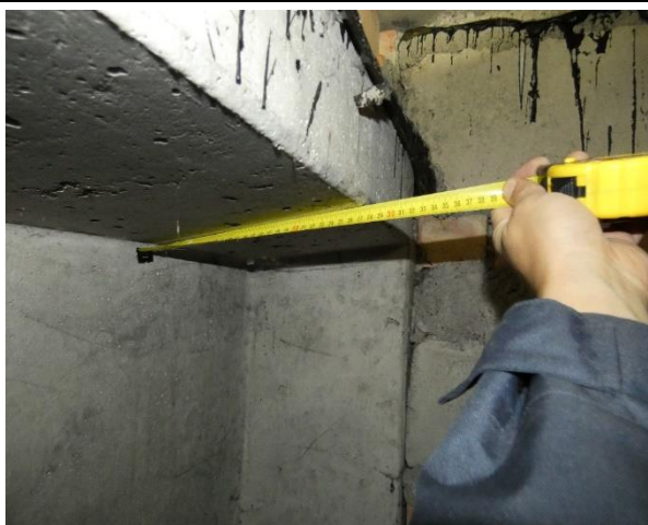
4.2.11.att. Ārsienu cokola paneļi labā stāvoklī un horizontālā hidroizolācija virs tiem ēkas pagrabā. Grēdu iela 3, Rīga
