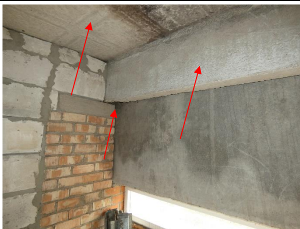
4.8.9.att. Jumta klāja ribotās dzelzsbetona plātnes balstītas uz rīģeli PK1. Atsegts, korodējis stiegrojums. Irlavas iela 26, Rīga.
