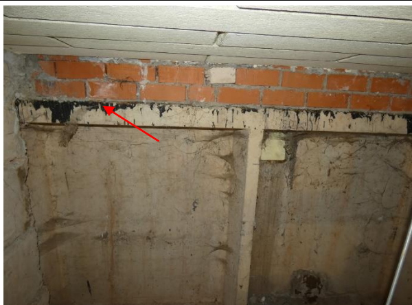
4.2.8.att. Pagraba ārsienu cokola paneļi, horizontālā hidroizolācija virs tiem. Vaives iela 2, Cēsis
