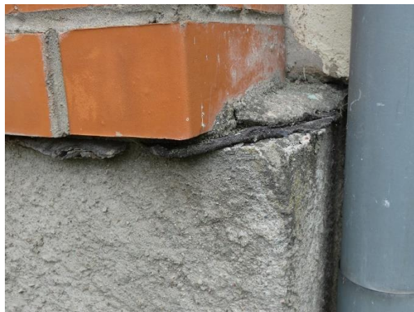
4.1.12. attēls. Hidroizolācija uz atz. -0,69 m. Loka iela 3, Cēsis
