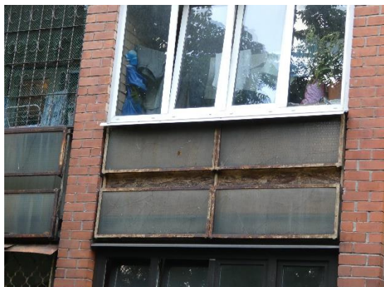
4.9.3.att. Lodžiju norobežojuma konstrukcijas korozija. Kapseļu iela 4 k-2, Rīga
