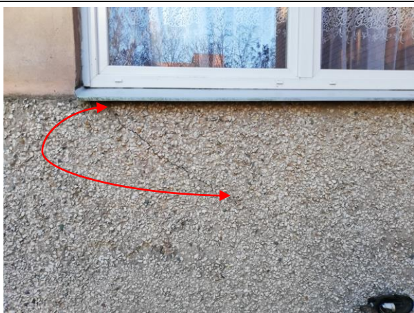
4.4.21.att. Plaisa ēkas 1.stāvā keramzītbetona paneļa virsmā. Valmieras iela 21, Cēsis
