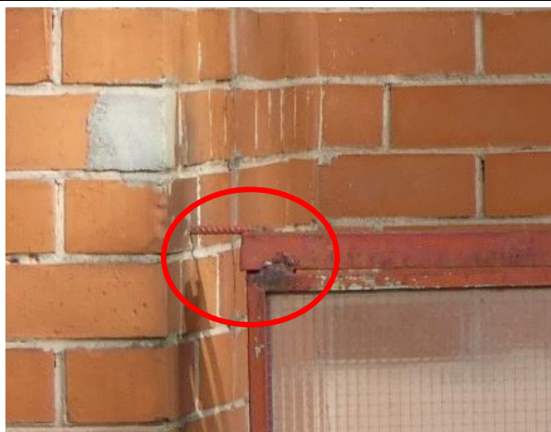
4.9.16.att. Lodžiju norobežojošo elementu stiprinājumi un metinājumu savienojumu vietas ar koroziju. 1905.gada iela 7, Talsi
