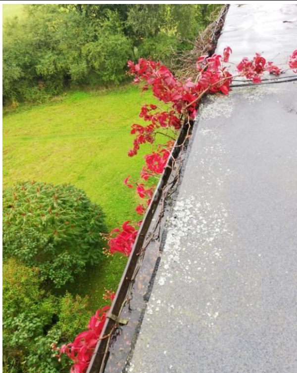
4.8.70.att. Lietus ūdens tekne nosprostota ar vītenaugiem. Ūdens novadīšana nav organizēta. Saulkalni, Liepa
