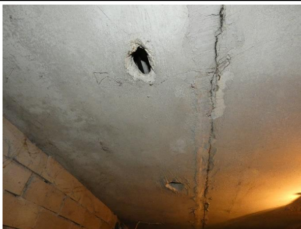
4.6.8.att. Mehāniski bojājumi pagraba pārsegumā. Loka iela 3, Cēsis.
