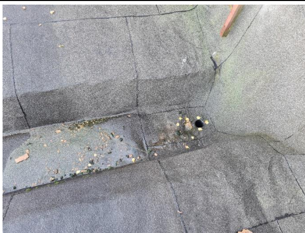
4.8.32.att. Jumta lietus ūdens novadīšanas tekne, izvads bez aizsargrestes. Grēdu iela 3, Rīga.
