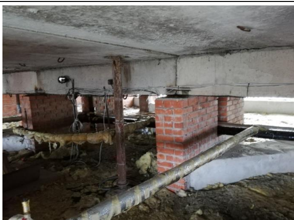
4.8.26.att. Tekņu elementu balsta vieta apmierinošā stāvoklī. Valmieras iela 21, Cēsis
