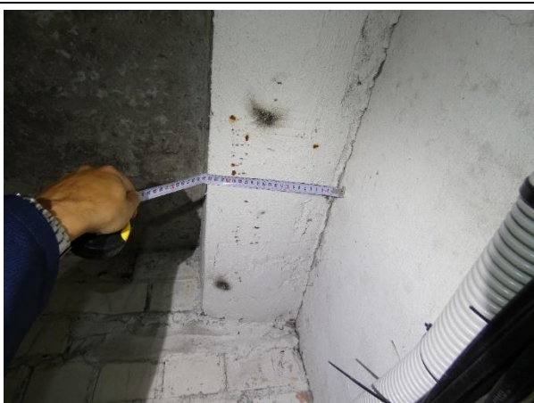
4.6.16. att. Tērauda sijas balsta vieta mūra šķērssienā – apmierinošā stāvoklī. Ausekļa prospekts 1, Ogre.
