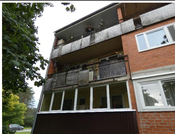
3.7.att. Konstatēta neatbilstība - lodžijas aizmūrējums un aizstiklojums. Mazcenu aleja 13, Mārupe
