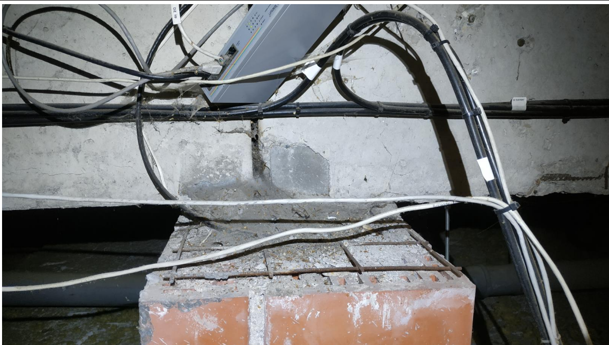
4.2.14.att. Balsta vietā ierīkots siets un pabetonējums. Vaives iela 2, Cēsis
