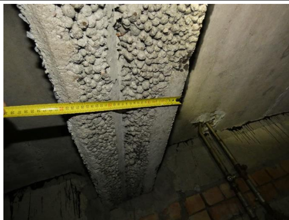
4.4.26.att. Keramzītbetona ārsienu paneļi. Grēdu iela 3, Rīga.
