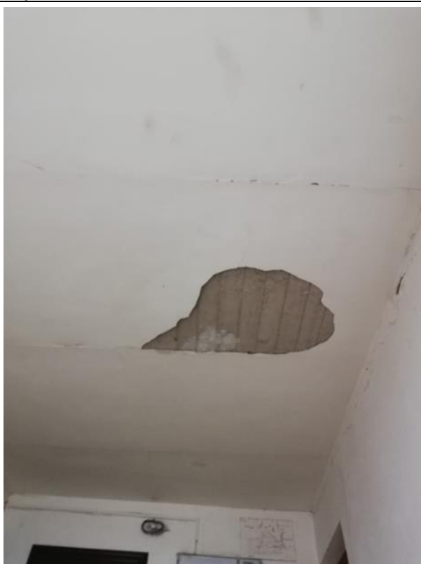
4.8.36.att. Savietotā jumta pārsegums virs kāpņu telpas no monolītā dzelzsbetona. 3-stāvu ēka Saulkalni, Liepa.
