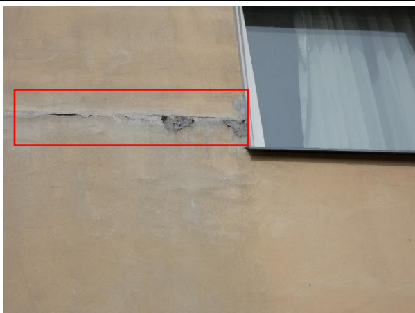
4.4.15. att. Izdrupumi starppaneļu šuvē, aizdare veikta nekvalitatīvi. Irlavas iela 26, Rīga.
