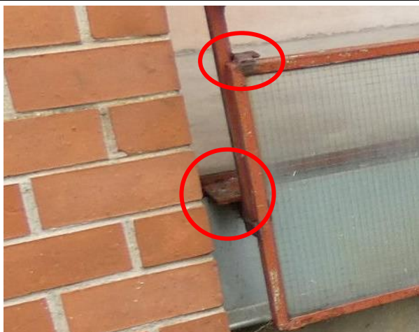
4.9.15.att. Lodžiju norobežojošo elementu stiprinājumi un metinājumu savienojumu vietas ar koroziju. 1905.gada iela 7, Talsi
