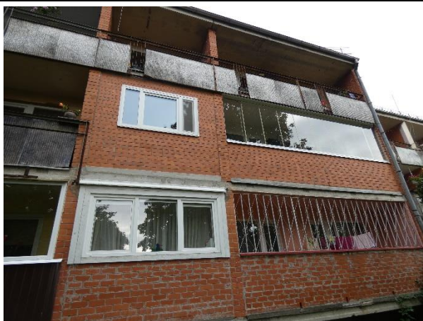
3.6.att. Konstatēta neatbilstība Projektam un patvaļīgi būvdarbi - lodžiju aizmūrējums un aizstiklojums. Mazcenu aleja 13, Mārupe
