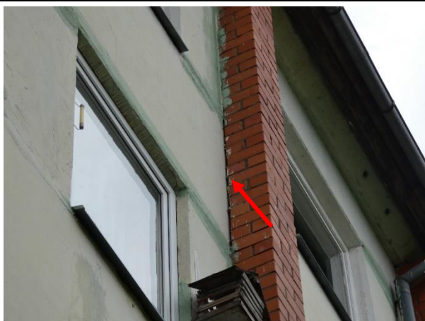
4.2.19.att. Atstarpe starp mūra sienas izvirzījumu (pilastru) un ārsienas paneli. Loka iela 3, Cēsis.
