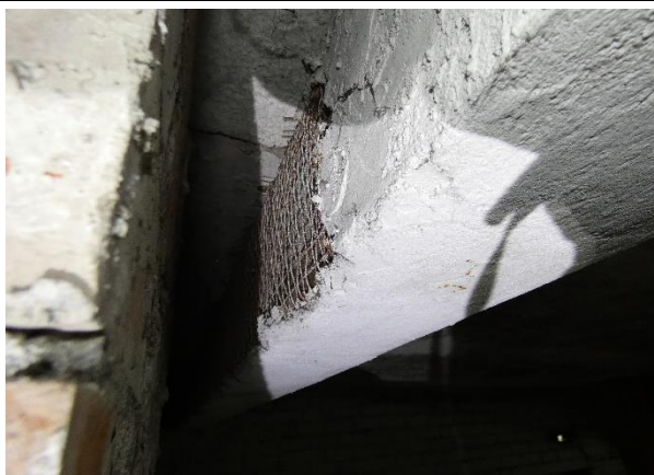
4.8.14.att. Apmesta metāla sija – apmierinošā stāvoklī. Ausekļa prospekts 1, Ogre.
