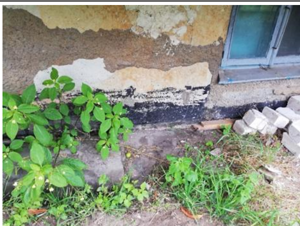
4.1.13. att. Vertikālā hidroizolācija. Saulkalni, Liepa.
