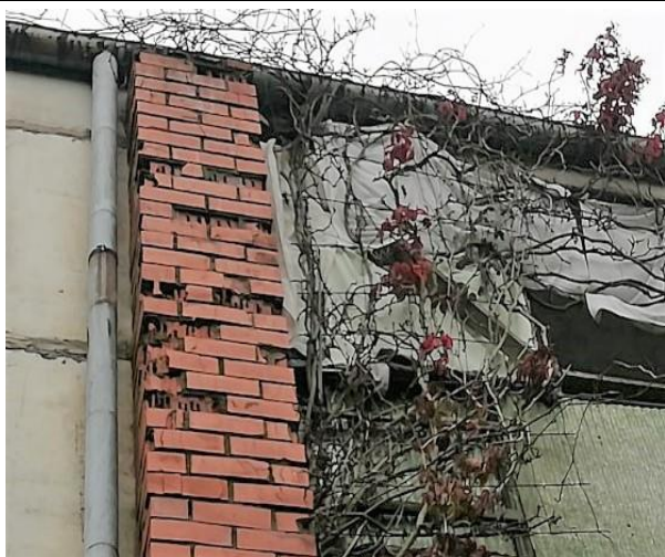
4.2.17.att. Klimata ietekmē erodējis šķērssienas mūris. Saulkalni, Liepa.
