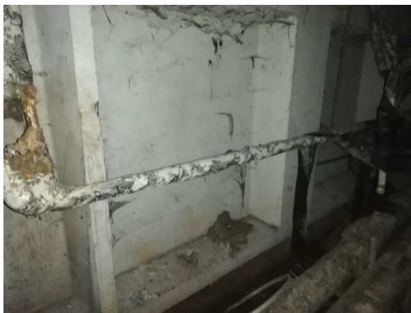
4.2.5.att. Pagraba ārsienas no dzelzsbetona ribotiem paneļiem, bez bojājumu pazīmēm. Pūpoli, Liepa
