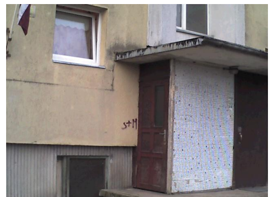
2.att. Ēkas ieejas mezgls un ārsiena (termiskais tilts)
