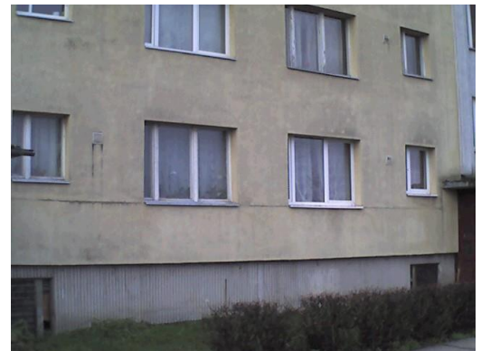
1. att. Ēkas fasāde (siltināta) un cokols (nesiltināts)
