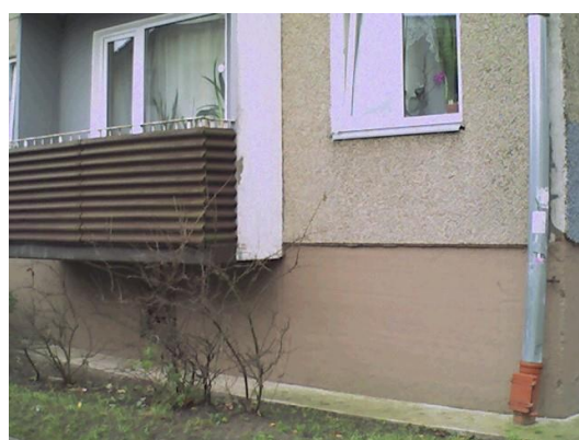
11.attēls. Paaugstināta virsmas temperatūra cokola/ārsiena mezglā
