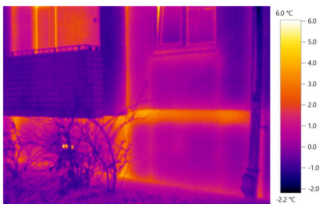
11.attēls. Paaugstināta virsmas temperatūra cokola/ārsiena mezglā
