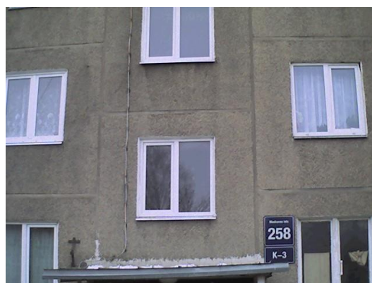
18.attēls. Paaugstināta virsmas temperatūra paneļu savienojuma vietās
