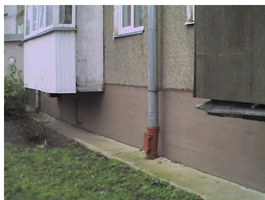
11.attēls. Paaugstināta virsmas temperatūra cokola/ārsiena mezglā
