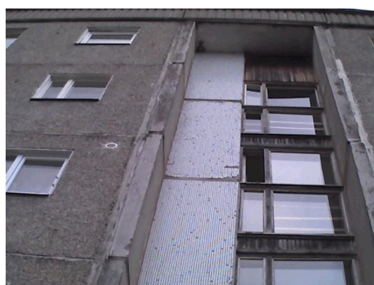
14.attēls. Termiskais tilts ēkas stūros, siltuma zudumi caur kāpņu telpas logiem
