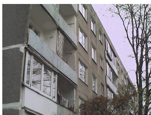
11.attēls. Ēkas fasāde, ārsienas/balkona termiskais tilts
