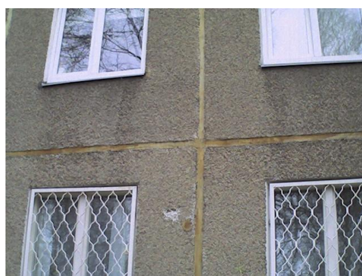
14.attēls. Siltuma zudumi caur logiem un ārsienu paneļu savienojuma vietām
