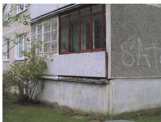
11.attēls. Ēkas fasāde, ārsienas/balkona termiskais tilts
