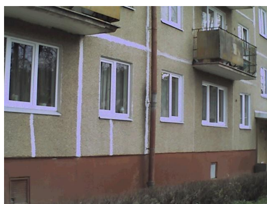
9.attēls. Virsmas temperatūras paaugstināšanās cokola paneļu šuvju vietās
