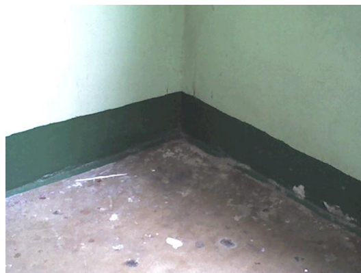
13.attēls. Ārsienas/pārseguma termiskais tilts
