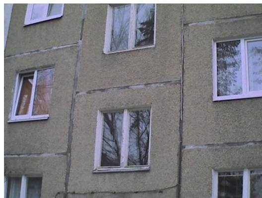
10.attēls. Siltuma zudumi caur paneļu šuvēm
