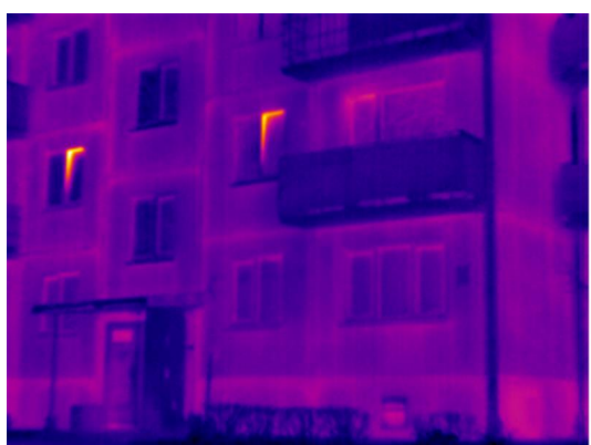
13.attēls. Temperatūras paaugstināšanās cokola paneļu savienojumā
