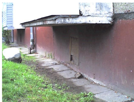
3.attēls. Ēkas cokols, paaugstināta virsmas temperatūra cokola paneļu savienojuma vietās
