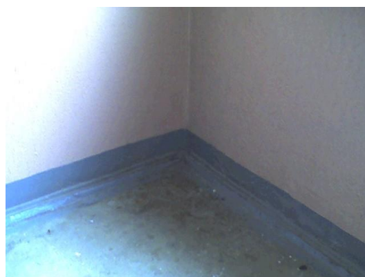
6.attēls. Termiskais tilts pārseguma/ārsienas mezglā
