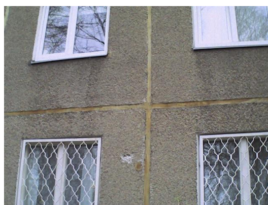
14.attēls. Siltuma zudumi caur logiem un ārsienas paneļu savienojuma vietām
