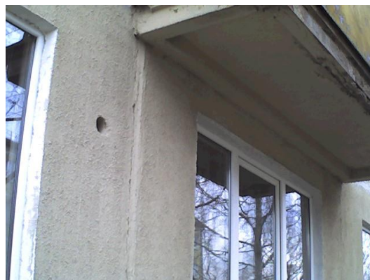
7.attēls. Paaugstināta virsmas temperatūra balkona/ārsienas mezglā, termiskais tilts loga rāmja/stiklojuma savienojumā
