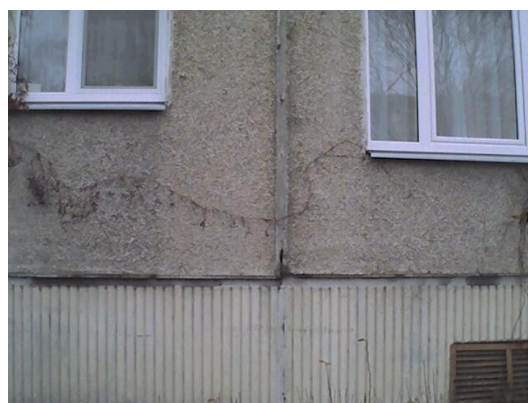
15.attēls. Paaugstināta virsmas temperatūra paneļu savienojuma vietās un loga rāmja/stiklojuma termiskais tilts
