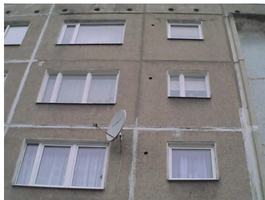
4.attēls. Paaugstināta virsmas temperatūra paneļu savienojuma vietās
