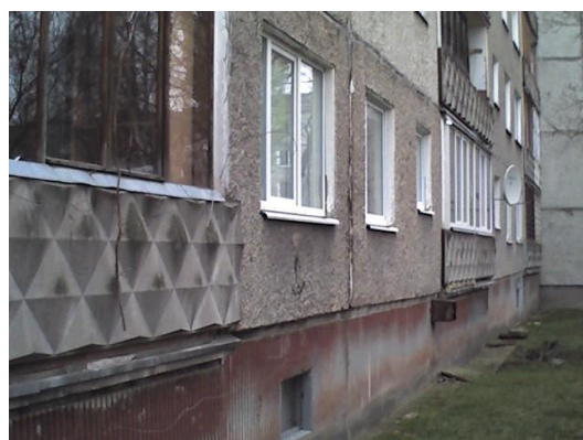
6.attēls. Ēkas dienvidu fasāde, siltuma zudui caur logu cokolā un 1.stāva loga rāmi
