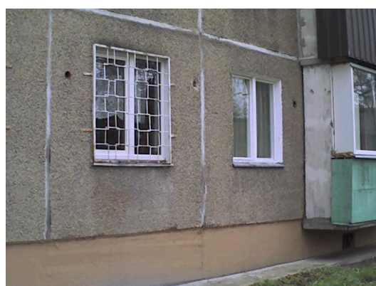
17.attēls. Paaugstināta virsmas temperatūra ārsienas/cokola mezglā, ārsienas/balkona termiskais tilts.
