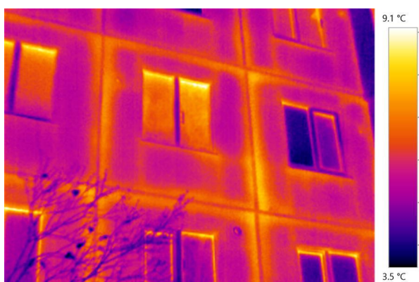
12.attēls. Lokāla temperatūras paaugstināšanās paneļu šuvju vietās
