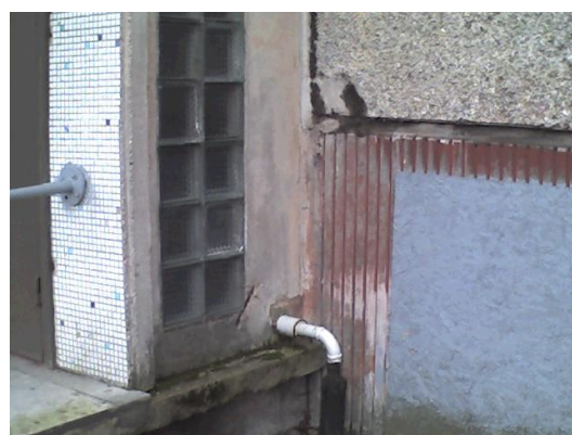
2.attēls. Termiskais tilts konstrukciju savienojuma vietā
