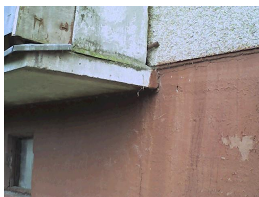
10.attēls. Paaugstināta virsmas temperatūra balkona/ārsienas mezglā
