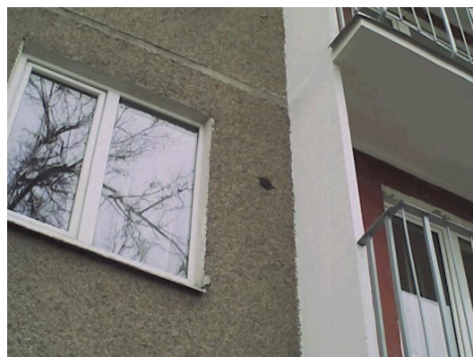
2.attēls. Balkona termiskais tilts, siltuma zudumi caur loga rāmi
