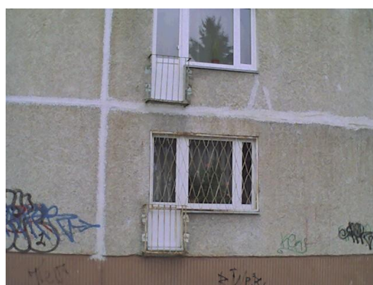
8.attēls. Ēkas ziemeļu fasāde, paaugstināta virsmas temperatūra uz loga rāmja, paneļu šuvju vietās
